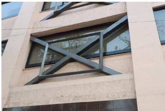
写真 3.65 ブレース補強の様子
