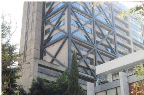
写真 3.62 ブレース補強の様子(1)
