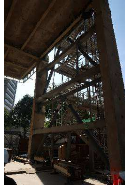
写真 3.33 最下層部分でのダンパー設置
