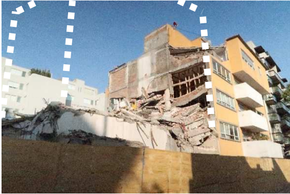
写真 3.27 被害建築物の除去後の様子
