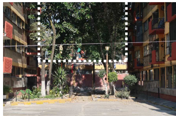
写真 3.23 2階より上部が除去された建築物
