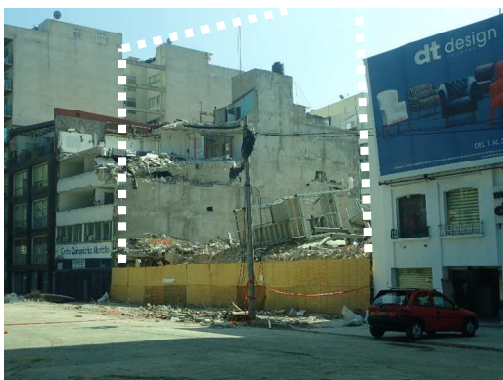
写真 3.47 崩壊建築物の除去後の様子
