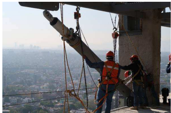
写真 3.35 ダンパー設置作業の様子
