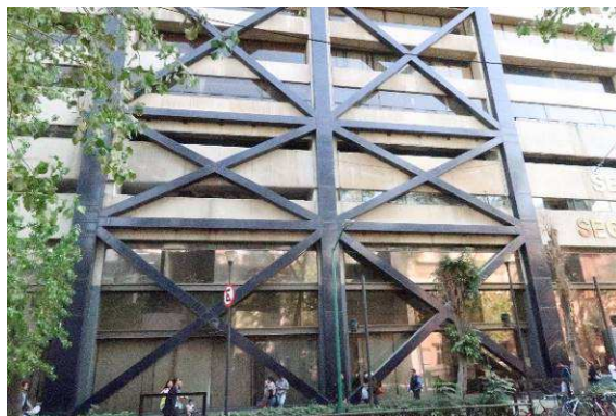
写真 3.63 ブレース補強の様子(2)
