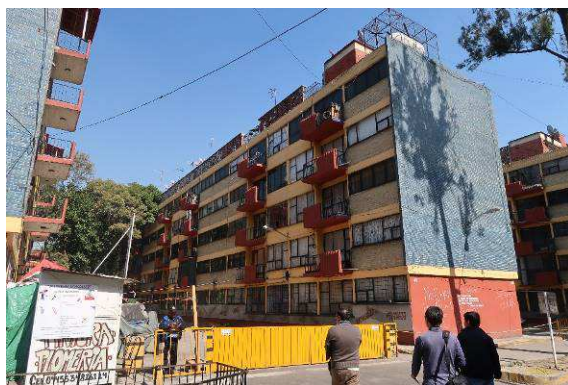
写真 3.22 被害が軽微な建築物の全容
