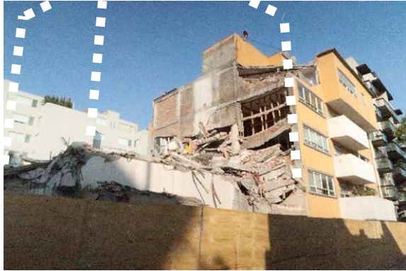
写真 3.27 被害建築物の除去後の様子
