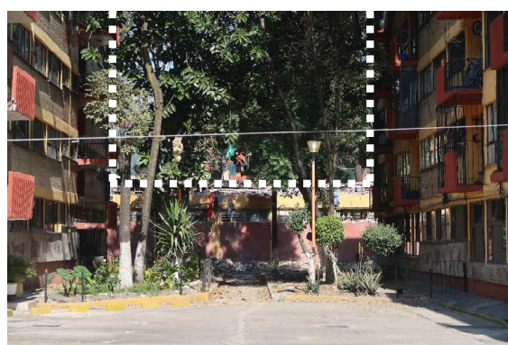
写真 3.23 2階より上部が除去された建築物
