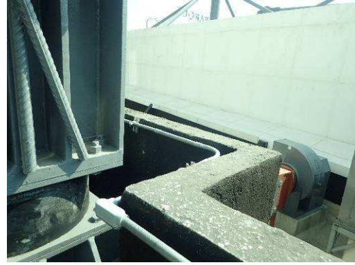
写真 3. 69 免震層周囲のクリアランス
