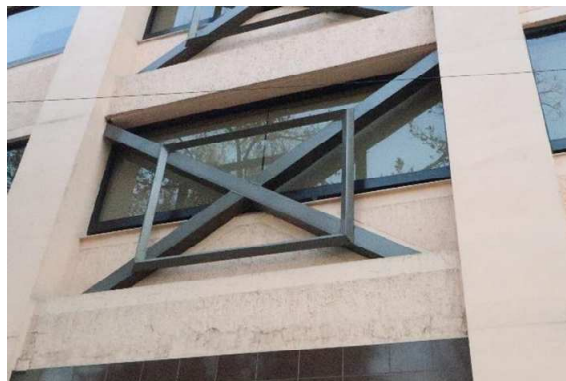
写真 3.65 ブレース補強の様子
