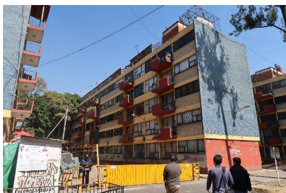
写真 3.22 被害が軽微な建築物の全容
