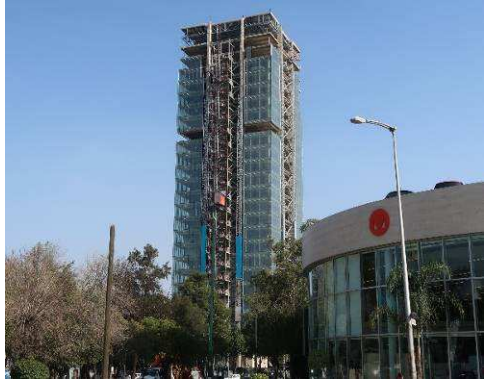
写真 3.32 建築物全容(制振補強中)
