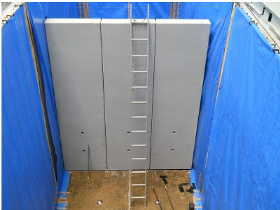
写真 2-3 設置完了（前面側）
