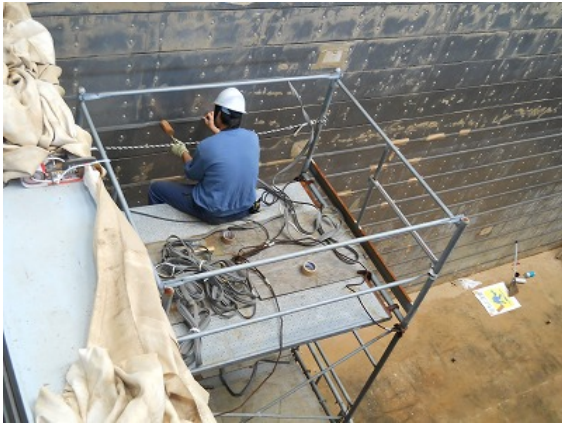
写真 1-1 セン断フレーム間の防水
