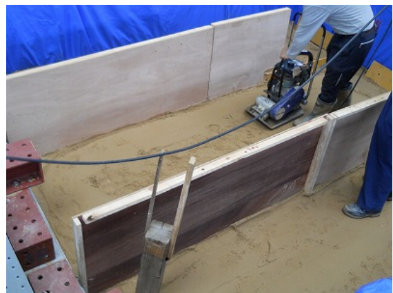
写真 7-26 擁壁背面地盤施工状況 (表層)
