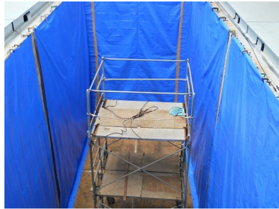
写真 1-4 ブルーシート設置
