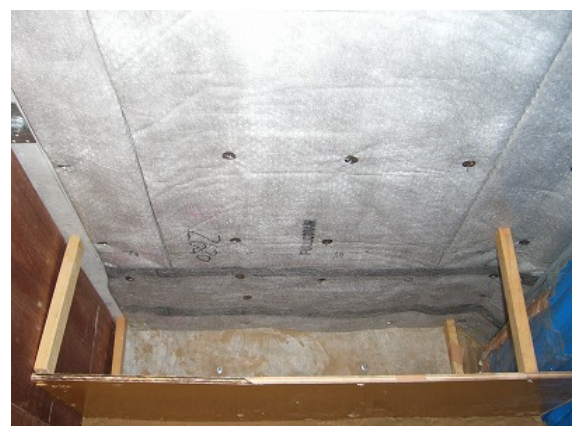
写真 7-12 試験体 No. 6、従来工法 (C-40)
