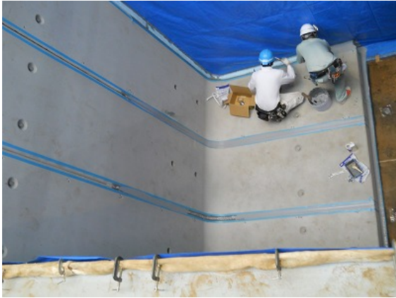
写真 3-1 擁壁周囲防水状況
