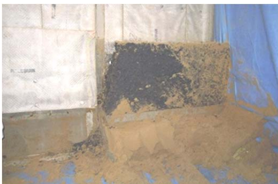
写真 4.3-1 砕石(C-40) 露出状況
