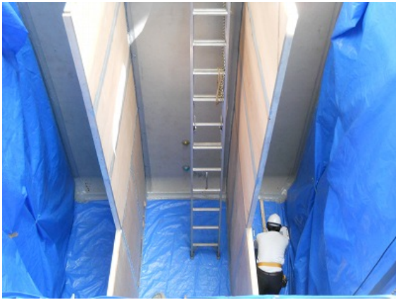
写真 4-1 擁壁仕切り板設置状況（擁壁背面）
