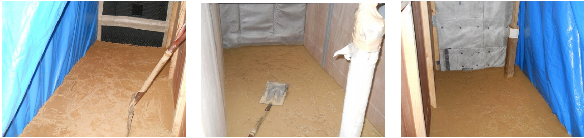
試験体 No. 1、新工法(A)
