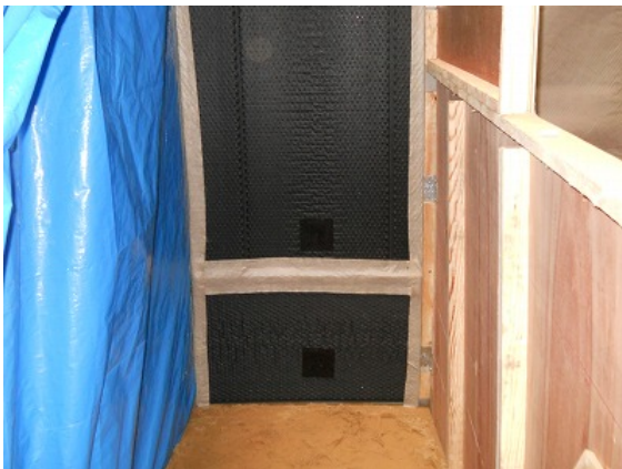
写真 7-16 試験体 No. 3、新工法 (C)
