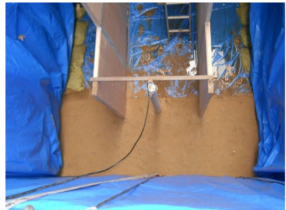
写真 7-3 一層目修了状況
