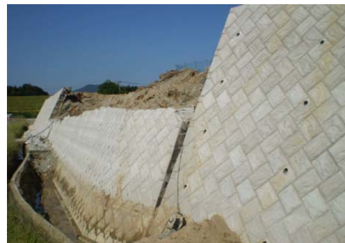
写真 1.1-1 再生砕石による不具合事例
