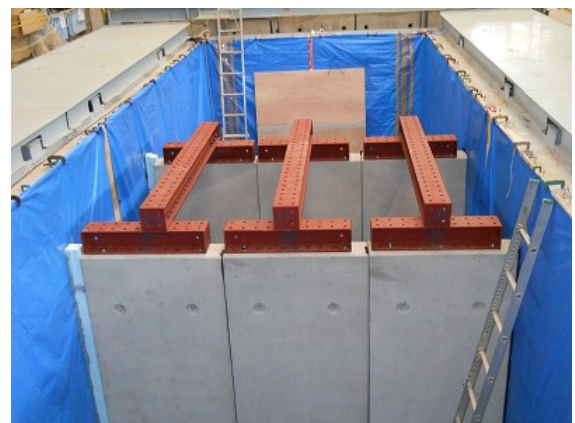
写真 2-5 擁壁天端支保工設置状況
