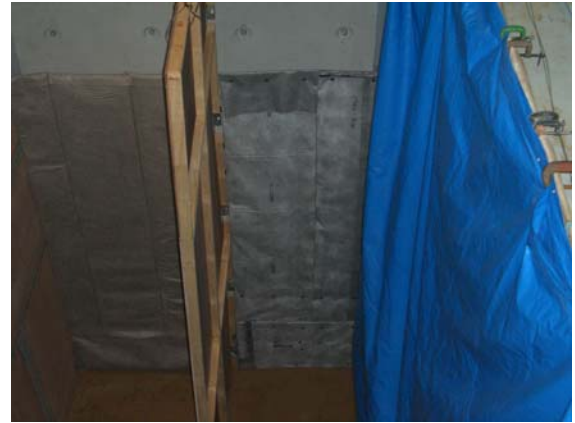
写真 7-13 新工法透水マット貼付状況
