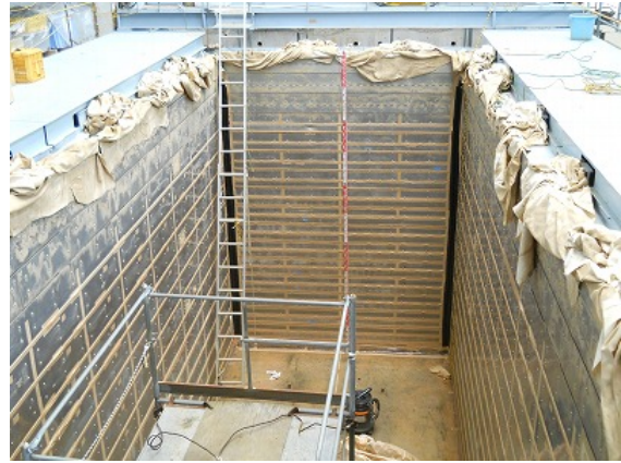
写真 1-2 防水補強(粘着テープを追加)
