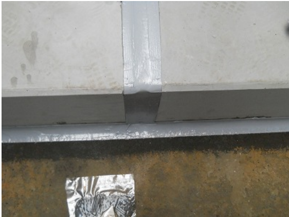
写真 3-3 防水処理状況
