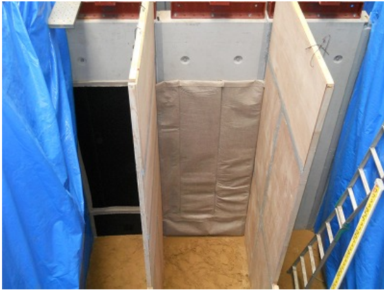
写真 7-13 新工法透水マット貼付状況
