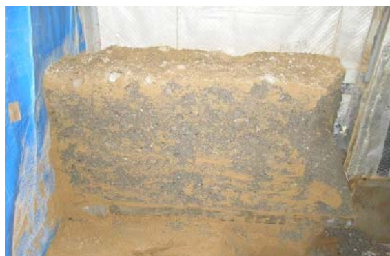
写真 4.3-2 再生砕石(RC-40) 露出状況
