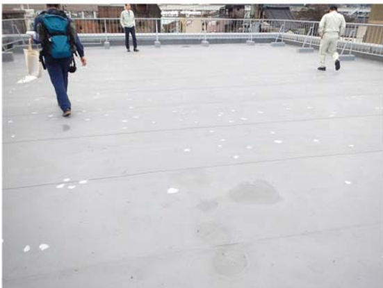
写真 4.2.2.1 屋上の状況(左：火の粉の着床による防水シートの補修跡、右：採取時のサンプル)
