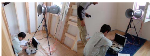
左：施工過程気密検査 右：完了器気密検査
