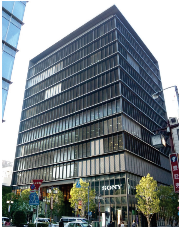
図 V. 2. 7. 1 事務所建物 (3H) 外観
