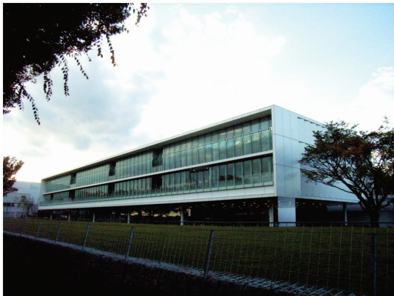
図 V. 2. 6. 1 事務所建物 (3G) 外観
