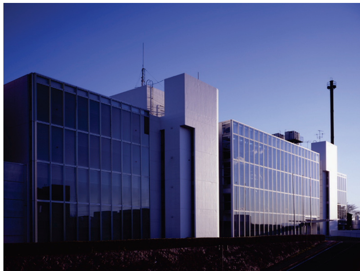
図 V. 2. 2. 1 事務所建物 (3A) 外観
