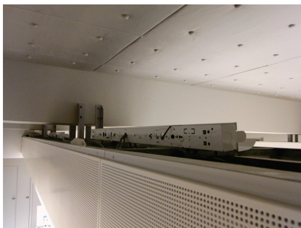
図 V. 2. 2. 42 ダクト裏 間接照明設置状況
