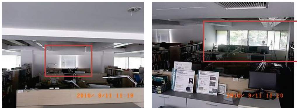
図 V. 2. 2. 4 南東面開口部
