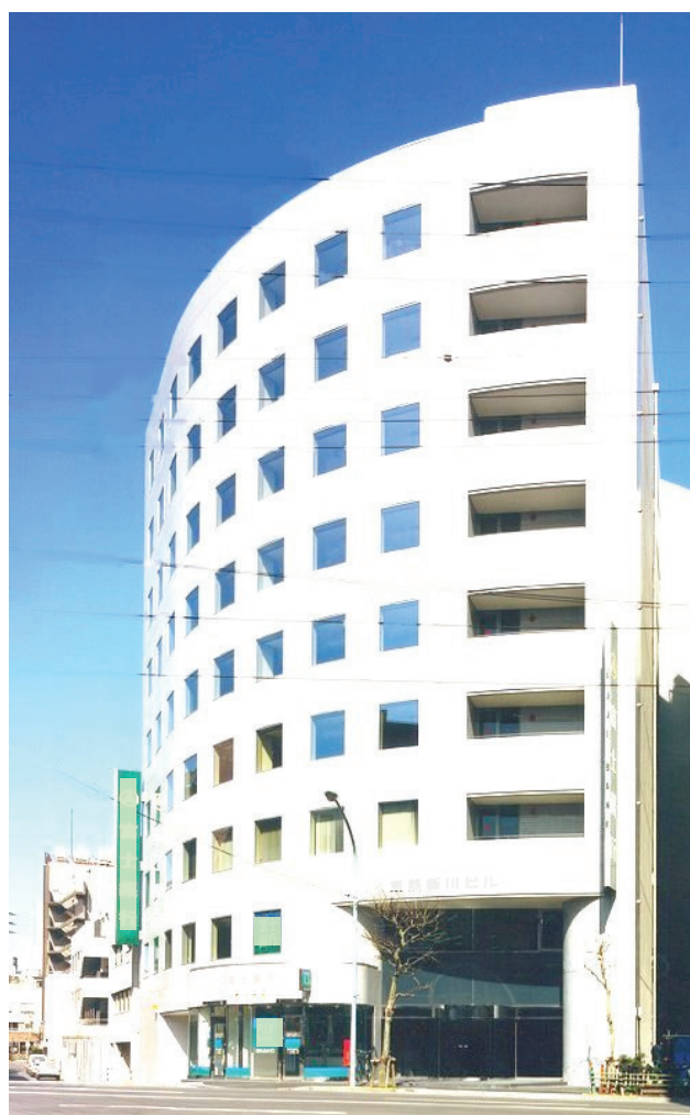
写真Ⅲ.4.4.1.1 建物外観
