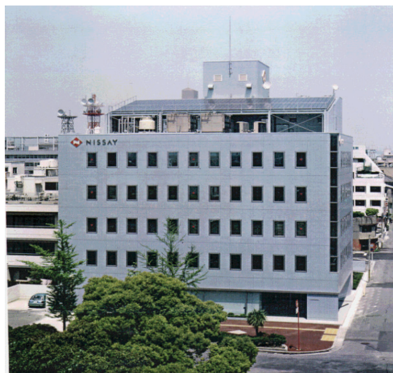
図Ⅲ.4.4.5.1. 事務所 1E 建物外観
