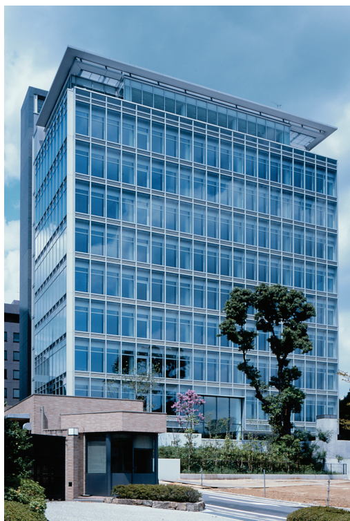
写真Ⅲ.4.4.4.1. 建物外観
