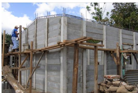
写真1 ブロックパネル造
