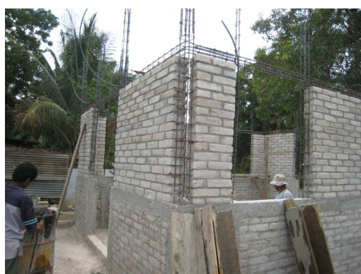
写真3 枠組組積造（ソイルセメントレンガ）
