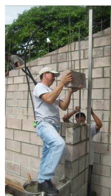
写真2 コンクリートブロック造
