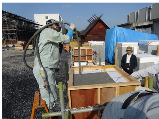
付写真 2-3 締固め状況
