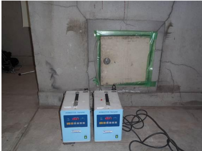
煙突点検口内サンプリング
