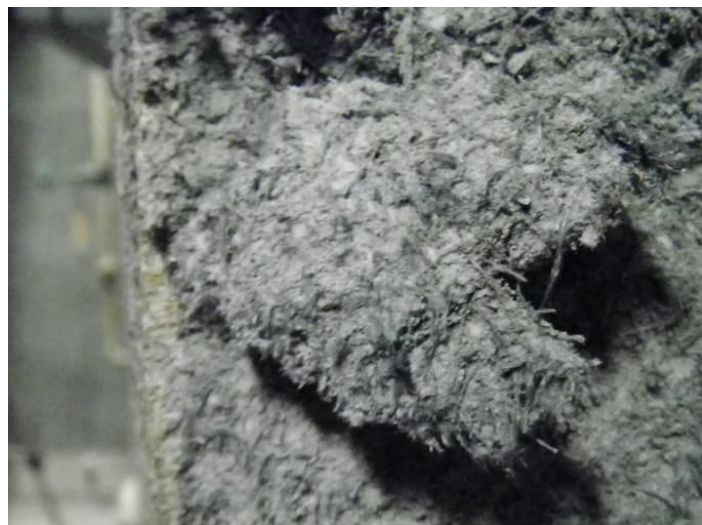
柱 角部拡大写真
