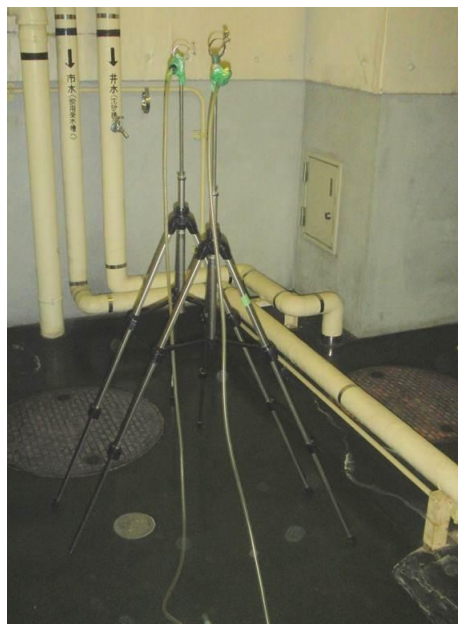
受水槽室内と点検口
