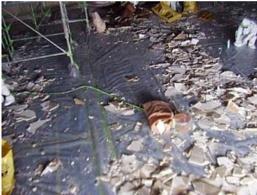
作業中の床状況
