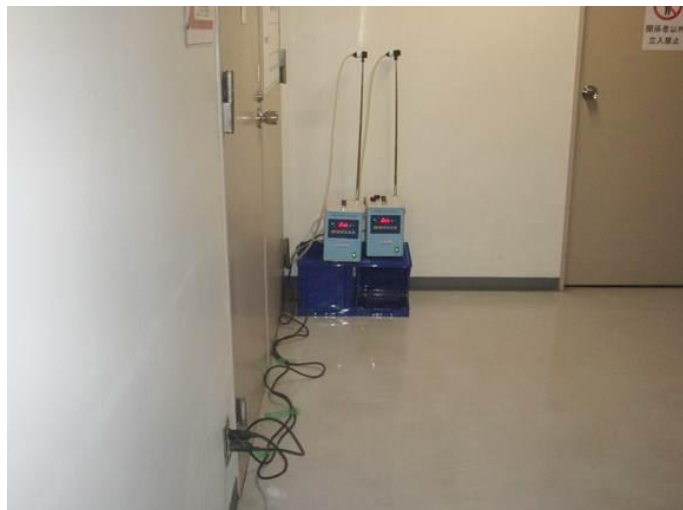
機械室前廊下
