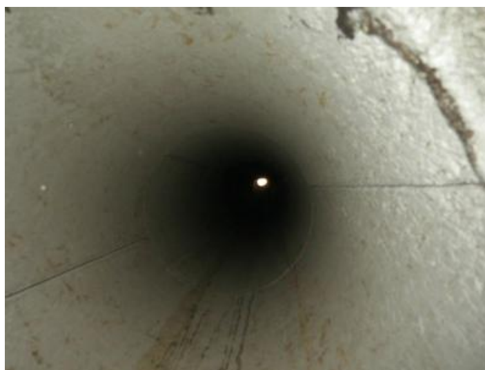
煙突点検口内天井側
