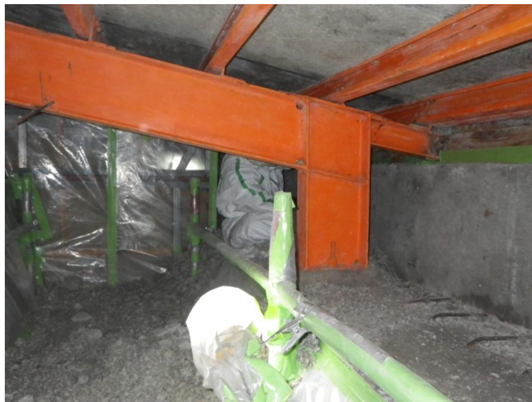
除去作業中の状況（みがき）
