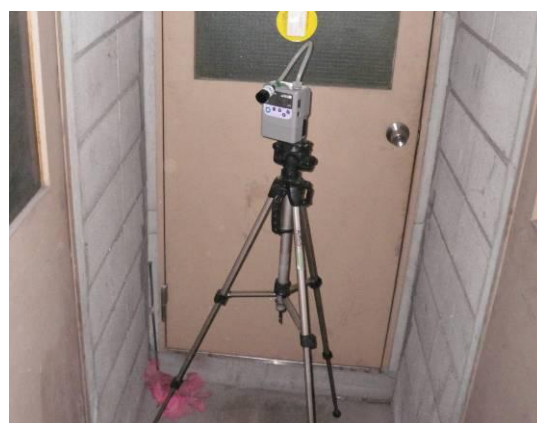
機械室前 廊下
