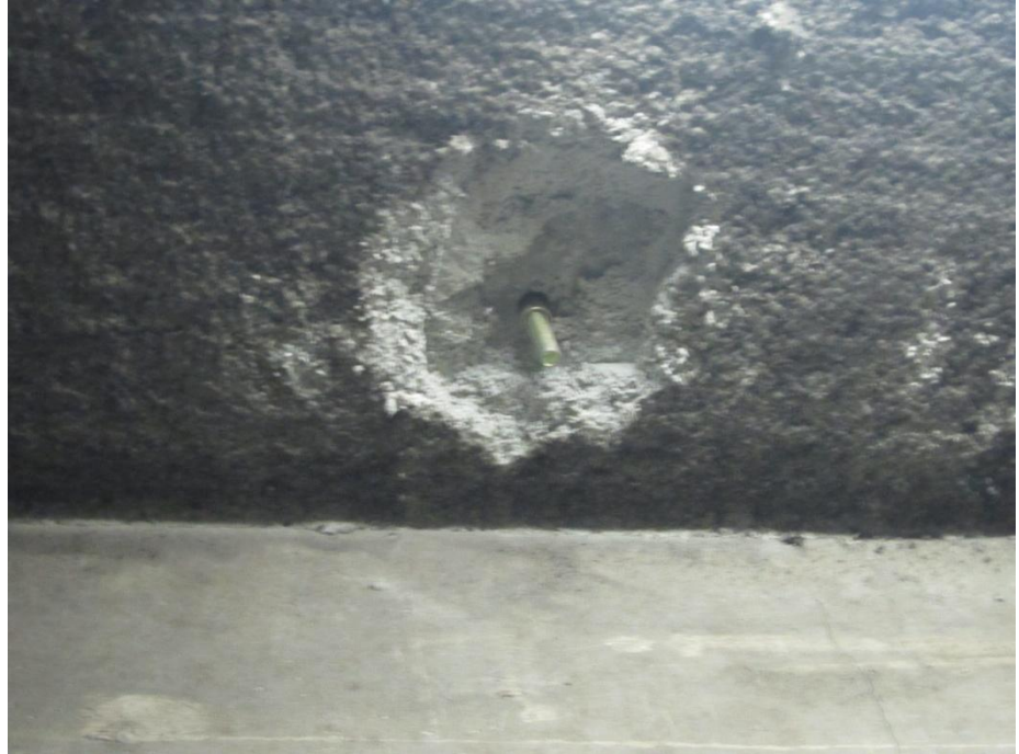
エレベーター機械室1 (No.1, No.2) 内②
