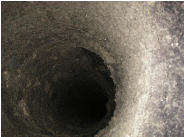
煙突内部（底部から）
