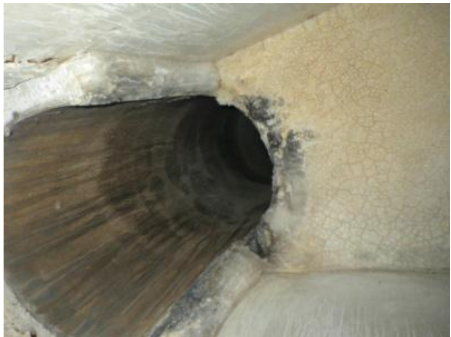
煙突点検口内天井側
