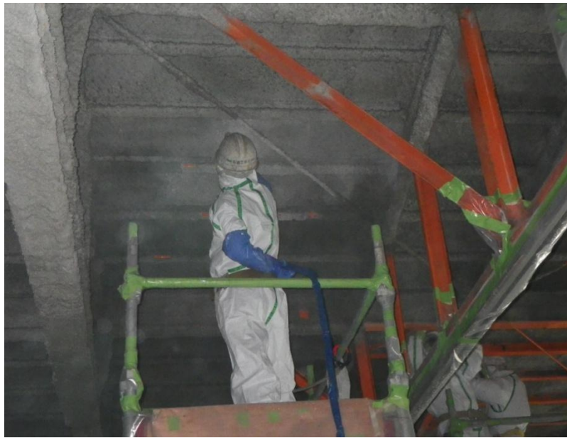
吹き付け面への薬液散布
