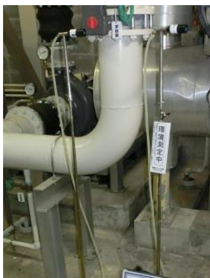
ボイラ室内採気状況
