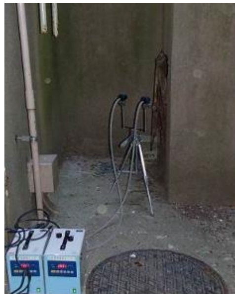
煙突点検口前
