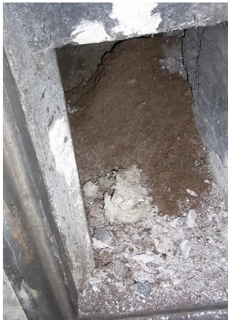
機械室内煙突下部
