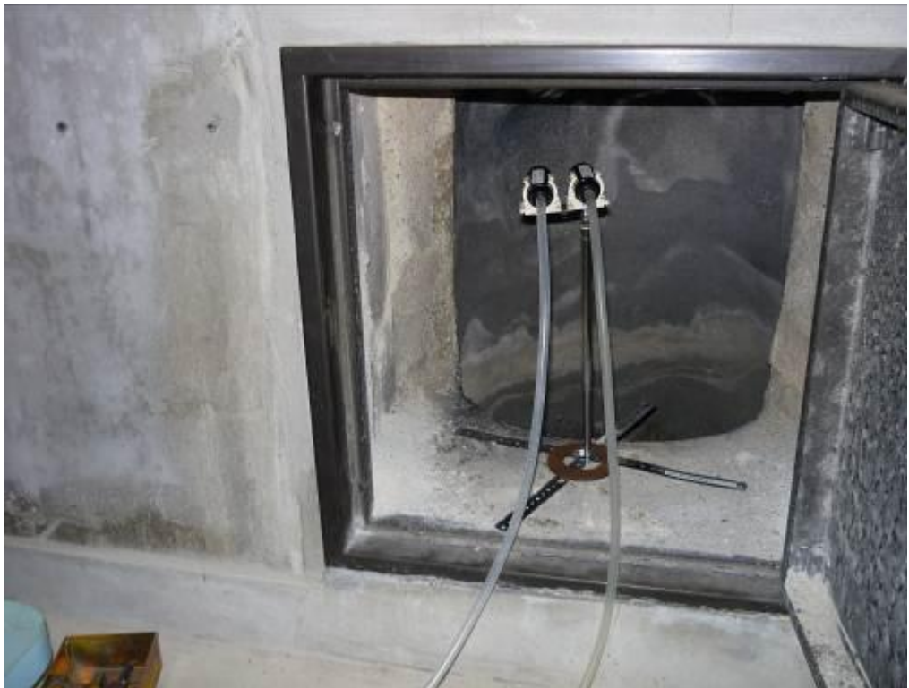
室内測定状況
