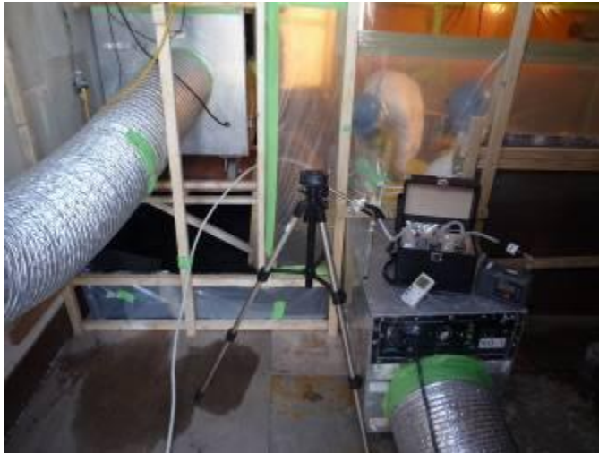
集じん・排気装置（2台）と 作業場所濃度測定（インピンジャー採取）
