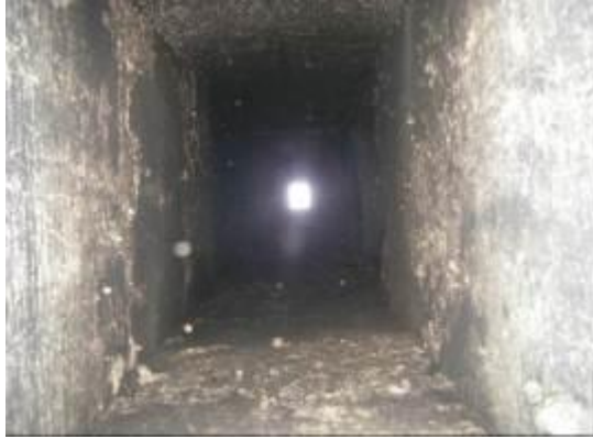
煙突点検口からの見上げ
