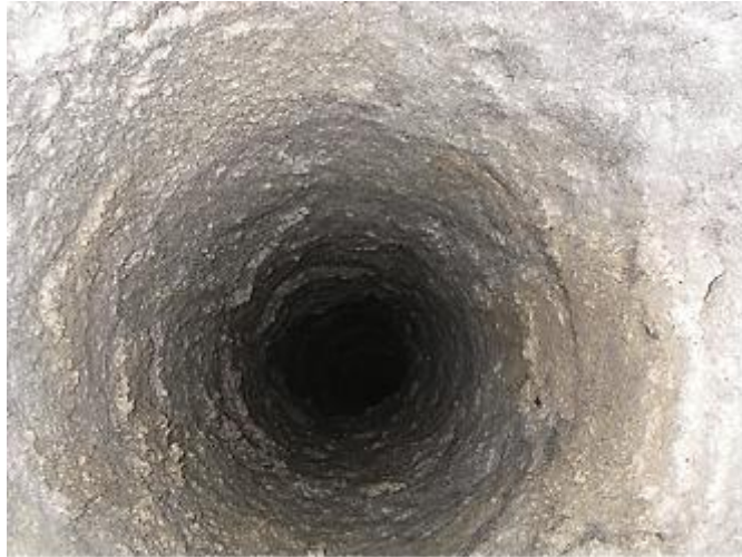
煙突内部状況写真
