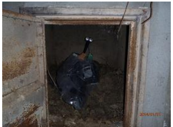
点検口内（開放時）
