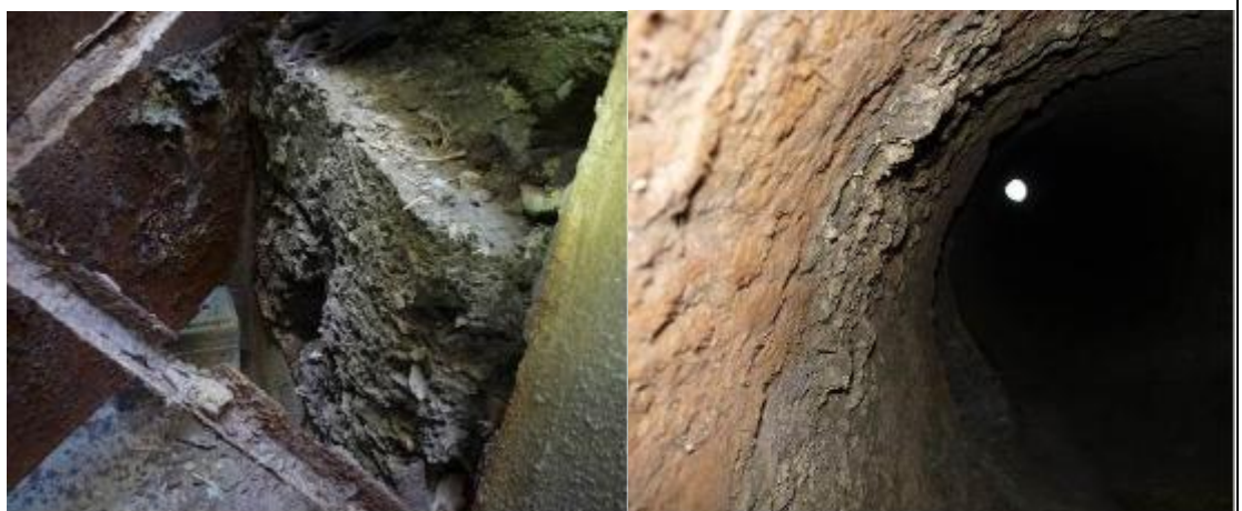
煙突点検口内
