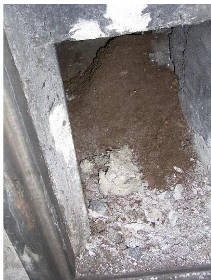
機械室内 煙突下部
