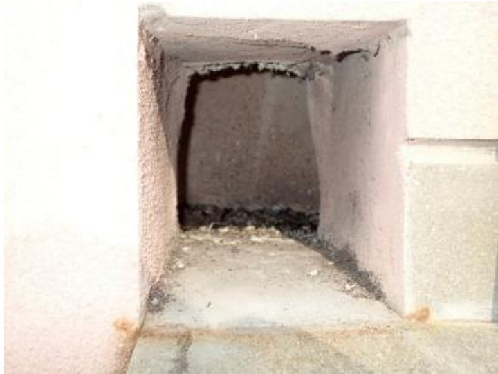
煙突点検口内
