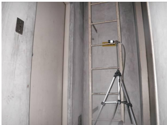
倉庫前廊下（隣室）
