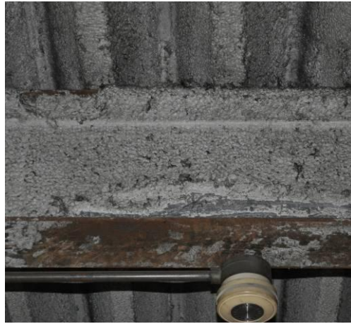
EV シャフト天井折板屋根&小梁損傷状況
