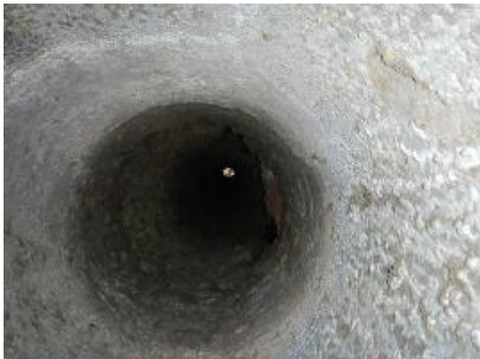
煙突内（点検口より内部を撮影）
