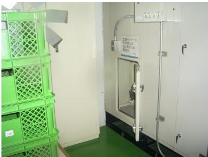
ボイラー室：省エネ対応に伴う外気吸入口の開放について
