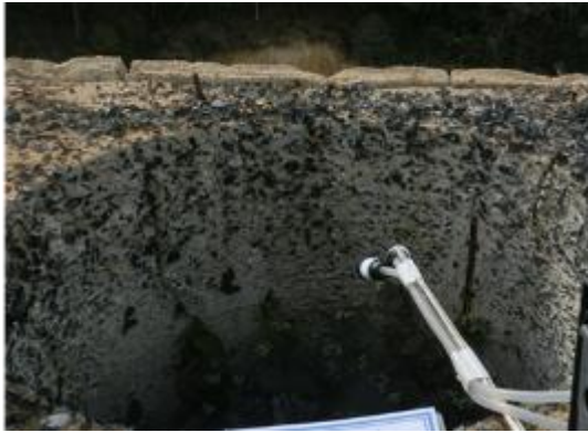
煙突頂部 測定状況
