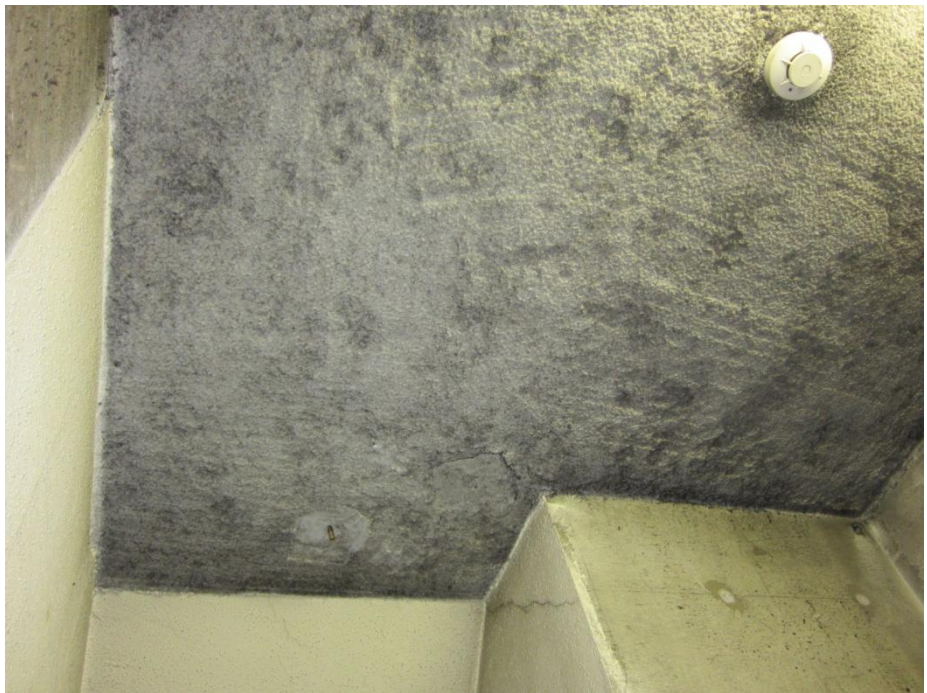
エレベーター機械室前廊下 (天井)
