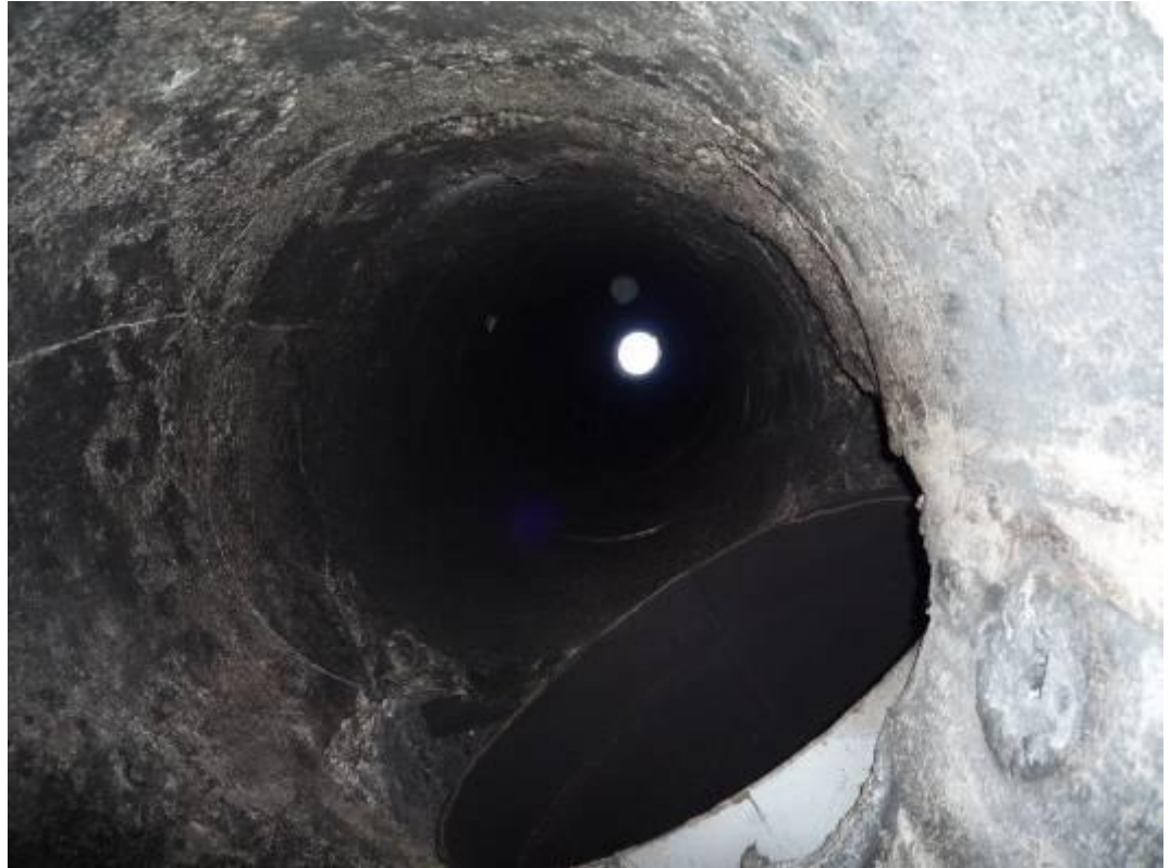
煙突内部底部からの見上げ
