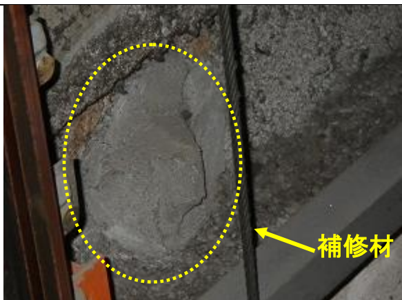
エレベーターシャフト内梁補修材、周辺は半乾式吹付けロックウール
