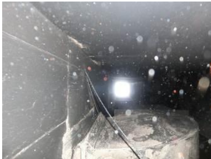
煙突点検口からの見上げ
