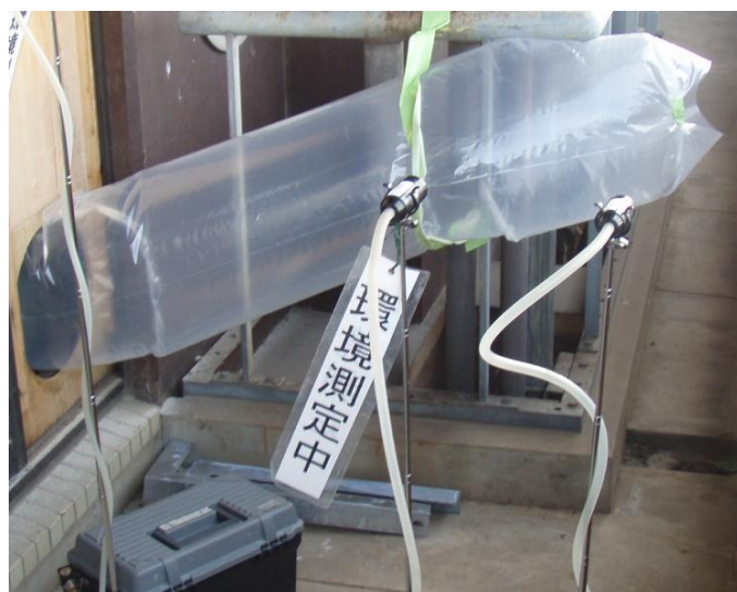
負圧除塵装置排気口前
