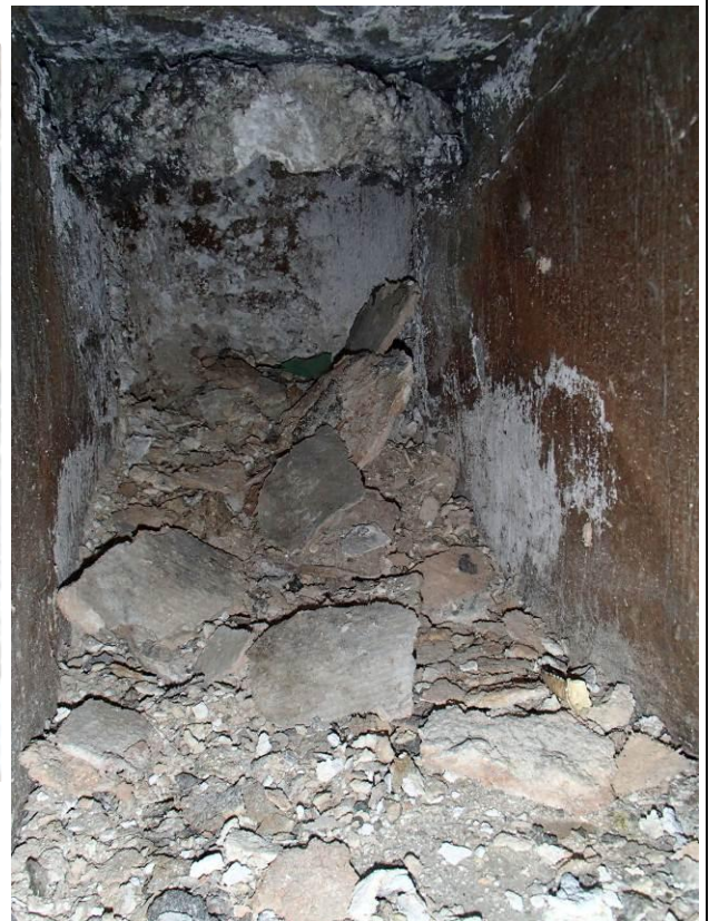
煙突点検口内状況
