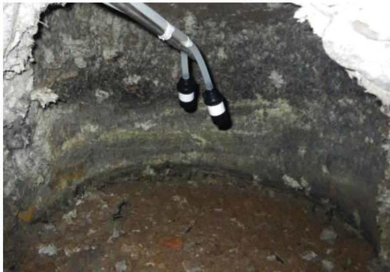
煙突内部断熱材（下部から）
