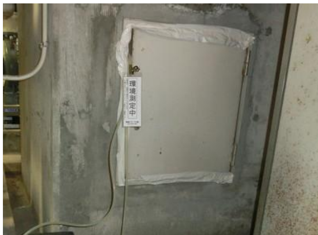
煙突点検口内採取状況
