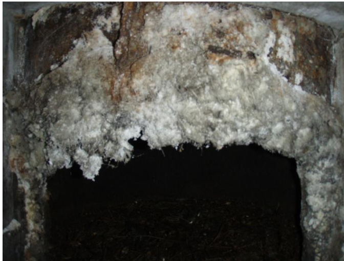
煙突断熱材内張り
