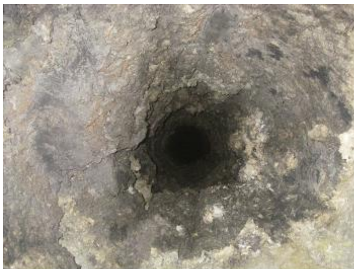
煙突内部の状況
