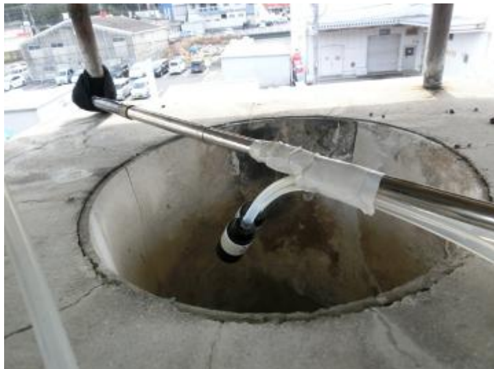
煙突頂部 測定状況
