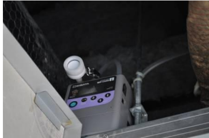
3 階天井点検口内部測定
