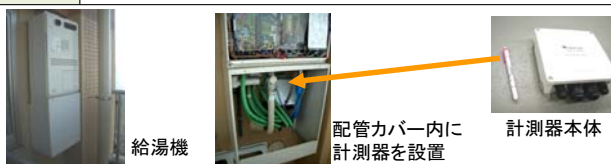
図 3.3.6 給湯機の内部データロギングによる計測方法
