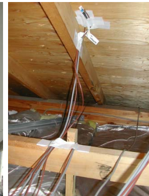
天井吊り木上 野地表面
