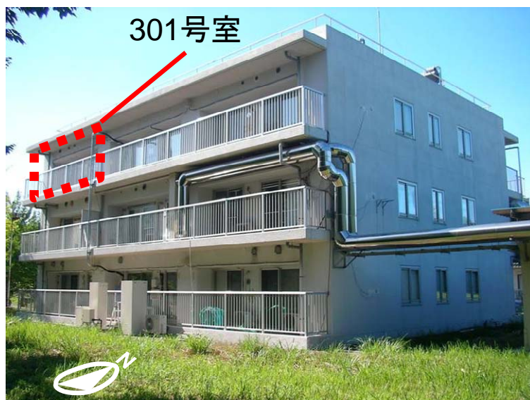
図 3.1.2 集合住宅試験体南側外観
