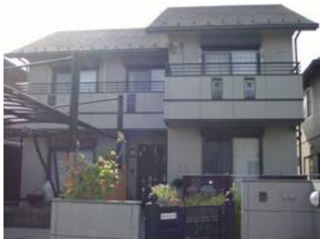
図 2.7.8 建物外観(B棟)
