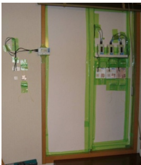
図 2.7.11 測定状況(室内側、B棟)
