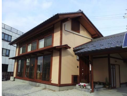
図 2.2.14 土壁住宅外観
