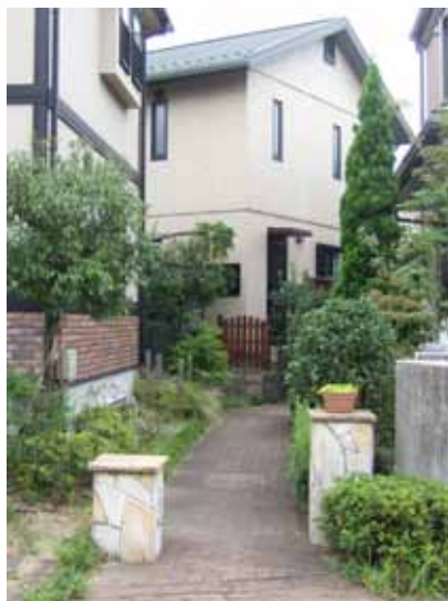
フットパスに面した通用口 (八王子みなみ野シティ／東京都八王子市)
