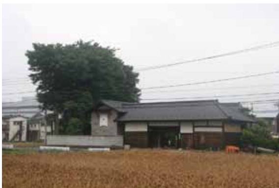
地域の歴史的な建物・蔵・樹木などが残る町並み（東京都日野市）
