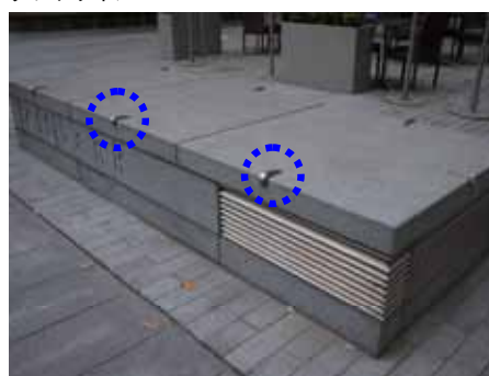
ベンチのスケートボード防止対策（イギリス・マンチェスター市）
