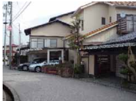
写真2：後付け車庫により街並みが崩れた例
