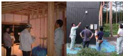
施工中进行う住まい手参加での立会い検査
