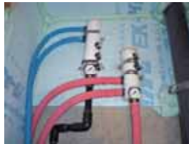
【②ヘッダー前圧力ゲージの設置】
