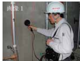
住宅診断：基礎配筋検査の例
