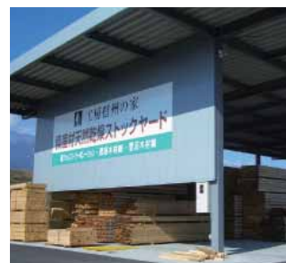
平成18年に弊社と地元の製材会社が協働して建設した、「工房信州の家」専用の「天然乾燥ストックヤード」
