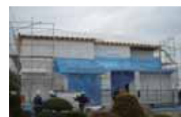
↑2日目の様子 上棟は2日工程です。
