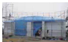
↑1日目の様子 2日目に備え、桁上に ブルーシートを施工します。
