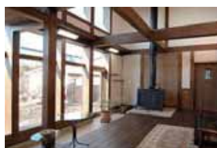
高窓からの採光と蓄熱土間
