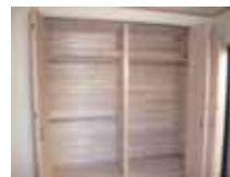
収納内部杉板貼(羽目板)
