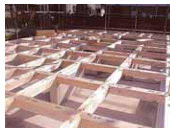
土台・大引組立状況
