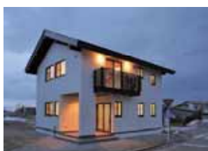
玄関ポーチの雪よけ空間
