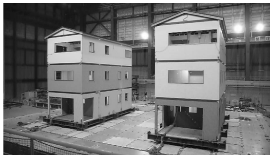
図3.5.1 試験体外観（左：試験体1、右：試験体2）
