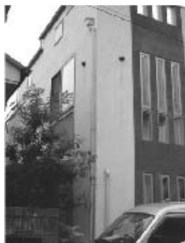
図6 手の届かない位置に屋外端末が設置されている例
