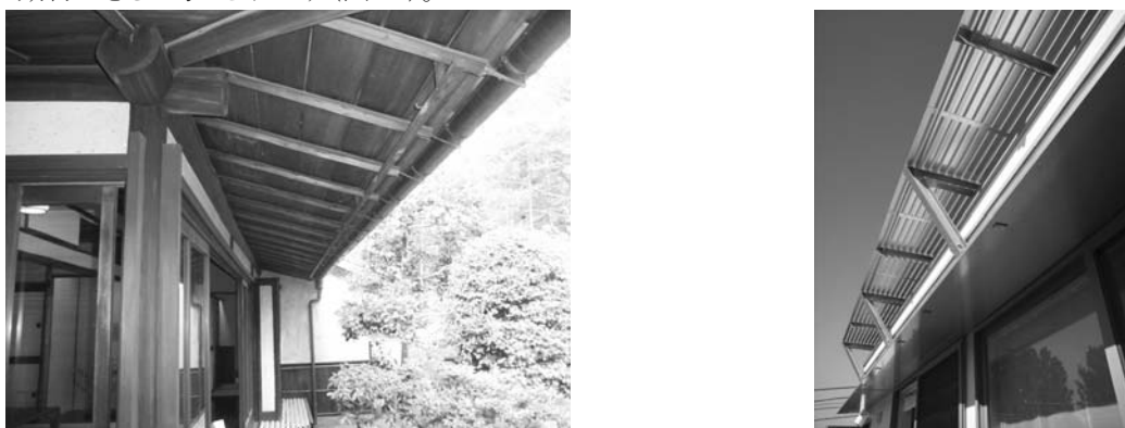
図17 庇等を利用した日射遮蔽の例
