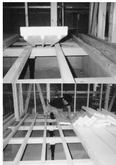
図 34 ボード状断熱材の施工状況
