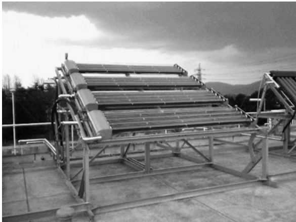
図3.5.5 太陽熱給湯システム 強制循環式（直接集熱）
