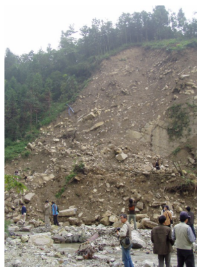
写真 4.2.7.1 地震により地表面に現れた断層(人のいる手前の崖が地震により生じた(以前は一帯が平坦)) 写真 4.2.7.2 都江堰市虹口地区の斜面崩壊
