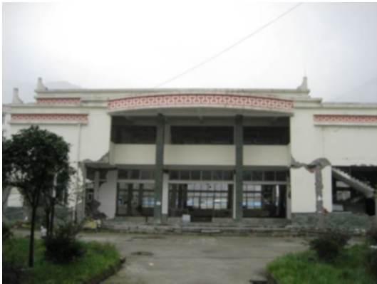
写真 4.2.1.2 漩口中学校内の校舎(1)
