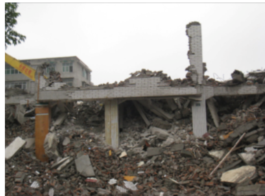
写真 4.2.2.12 解体途中の隣接建物( 解体 が進んでいることから、2 階以上は、写真 4.2.2.11 より被害が大きかったと推測さ れる。)
