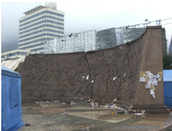
写真 4.2.3.26 RC 擁壁の傾斜
