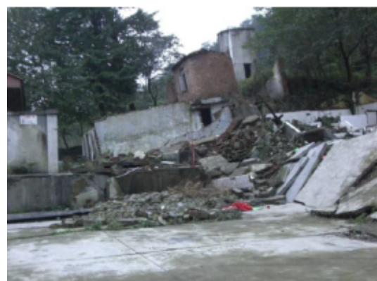
写真 4.2.4.8 敷地内の倒壊した建物(断層直上にあり手前の建物は崩壊、奥の建物は傾いている。)
