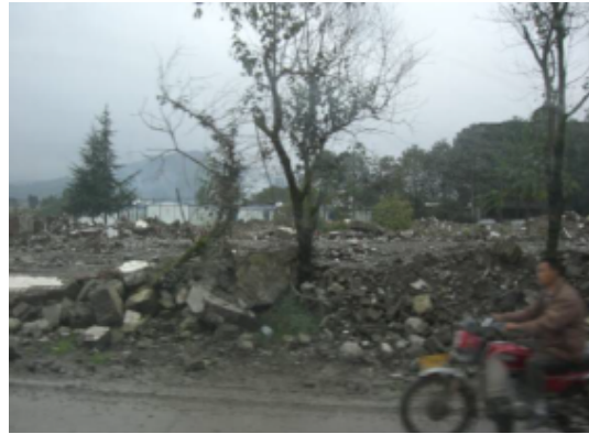
写真 4.2.4.12 倒壊した建物の跡(手前の瓦礫は倒壊した建物の跡であると思われる。奥に仮設住宅が見える。)
