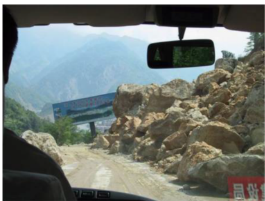
写真 4.2.5.1 落石による道路損傷 (北川県入口)
