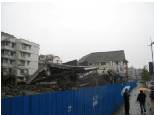
写真4.2.2.5 倒壊した共同住宅
