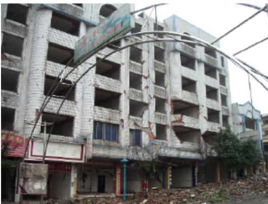
写真 4.2.3.5 (店舗兼住宅 3) 1階柱の曲げ破壊 + 2階以上の部分的組積壁のせん断破壊
