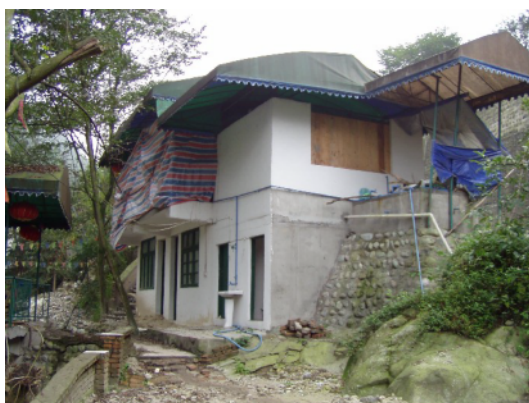
写真 4.2.7.10 2階建てで被害が軽微な住宅 (No.1)
