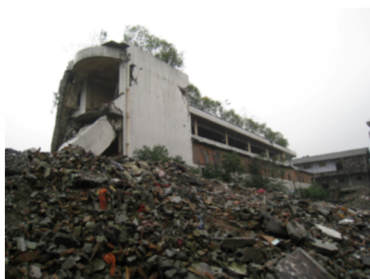
写真 4.2.2.2 写真 4.2.2.1 の側面（手前は崩壊した 2 階建て建物からの救助作業に伴う解体とのこと。）
