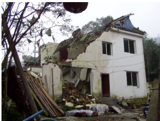
写真 4.2.7.7 地区でもっとも大きな住宅 (No.10) 無補強レンガ造。PCa パネルを受ける梁のみ RC 部材で、柱はない
