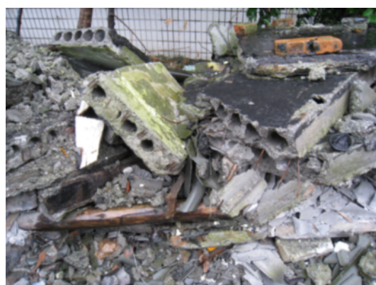
写真 4.2.2.4 解体跡に残る中空 PCa 床版
