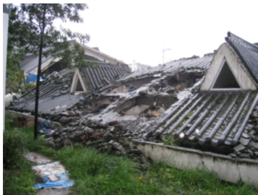
写真4.2.2.6 写真4.2.2.5の裏側（解体跡、救助作業に伴うものと思われる。）
