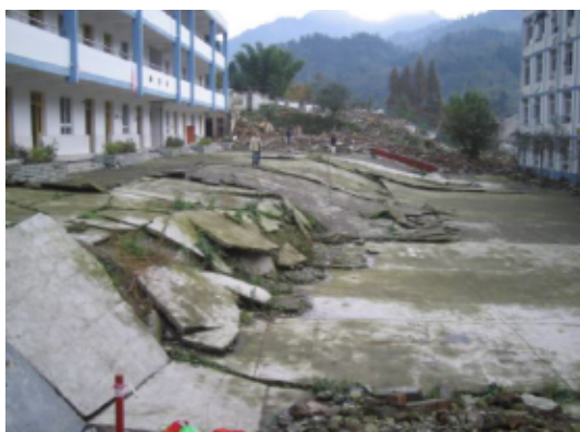
写真 4.2.4.1 敷地内の断層 ( 左右の建物は倒壊を免れているが奥の建物は倒壊している。 )
