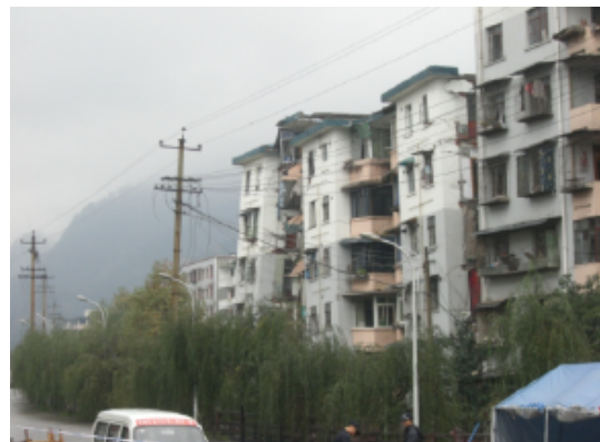
写真 4.2.3.23 立入禁止区域内の被災住宅全景
