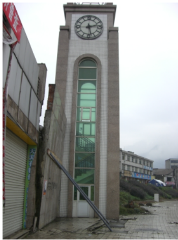
写真 4.2.3.26 RC 擁壁の傾斜
