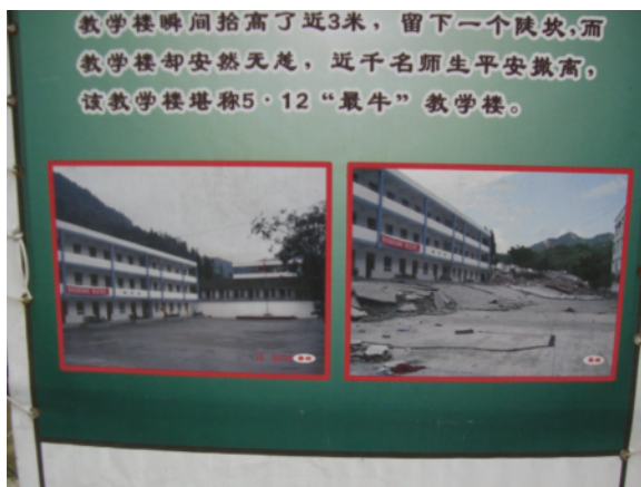
写真 4.2.4.9 敷地内に掲示された地震発生前後の比較写真1(写真 4.2.4.1 と同じ場所より撮影。左が震前、右が震後)
