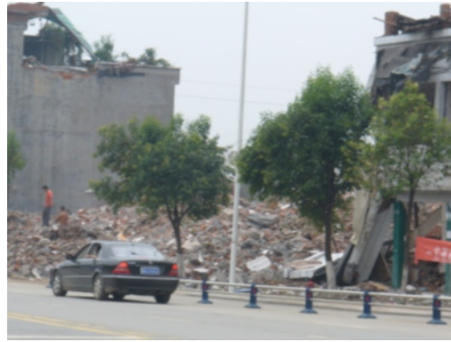
写真8 崩壊した建築物の残骸 めんちく かんおう (綿竹市漢旺鎮)
