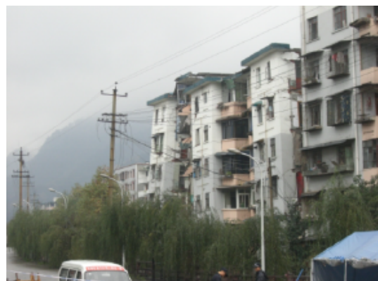
写真 4.2.3.23 立入禁止区域内の被災住宅全景
