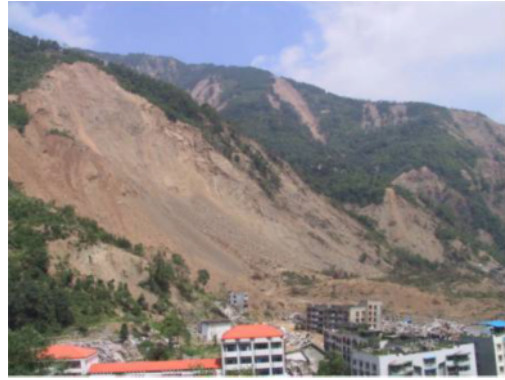
写真2 大規模な土砂崩落 (北川 きょう 羌族自治 きよくさん 県曲山鎮)
