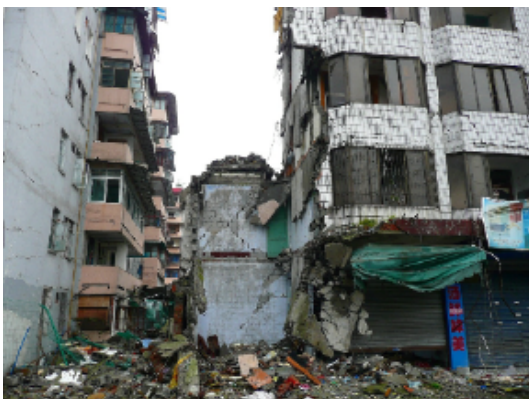
写真 4.2.3.22 (店舗兼住宅 8) 部分的崩壊
