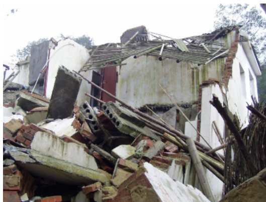
写真 4.2.7.8 同左。床に PCa パネルを使用していたことが分かる
