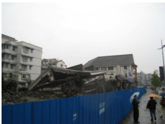
写真4.2.2.5 倒壊した共同住宅
