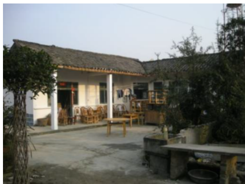
写真 6.3.4.3 自立建設された住宅
