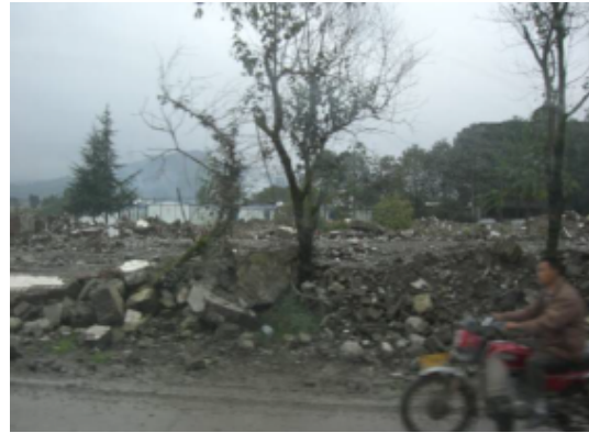
写真 4.2.4.12 倒壊した建物の跡(手前の瓦礫は倒壊した建物の跡であると思われる。奥に仮設住宅が見える。)
