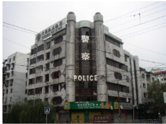
写真 4.2.3.12 (警察署) 被害状況全景
