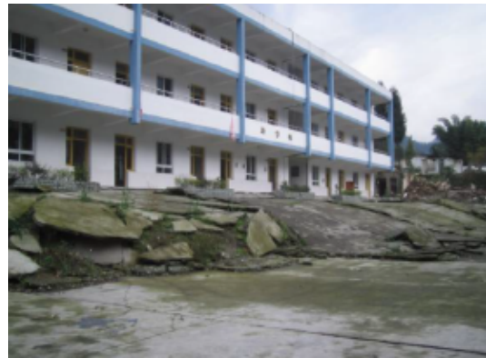
写真 4.2.4.2 断層上側の建物 ( この建物の被害は軽微である。手前の地盤と建物の地盤は地震前には同一の高さ。 )
