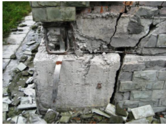
写真 5.14 基礎と上部構造のずれ（映秀） 写真 5.15 基礎と柱脚の詳細（映秀）
