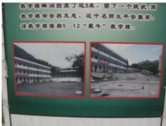
写真 4.2.4.9 敷地内に掲示された地震発生前後の比較写真1(写真 4.2.4.1 と同じ場所より撮影。左が震前、右が震後)
