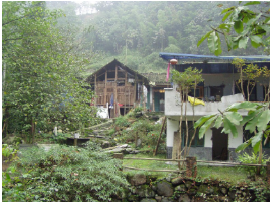
写真 4.2.7.5 木造(左 No.8)とレンガ造 (右 No.9) が並存する敷地。木造は、 農作物が収納されており継続使用され ている
