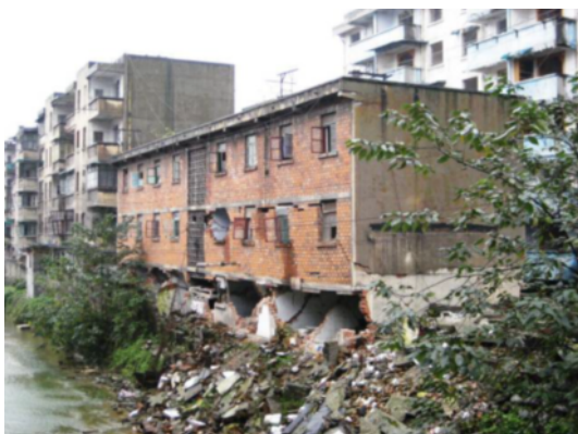
写真 5.1 1階が完全に崩壊した学生寮(映秀) 写真 5.2 写真 5.1 の妻面の1階部分
