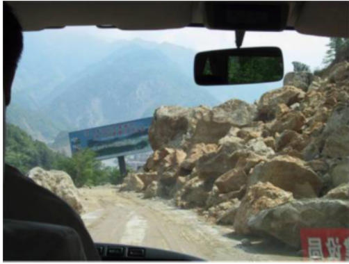
写真1 落石による道路損傷 (北川 ほくせん 県入口)
