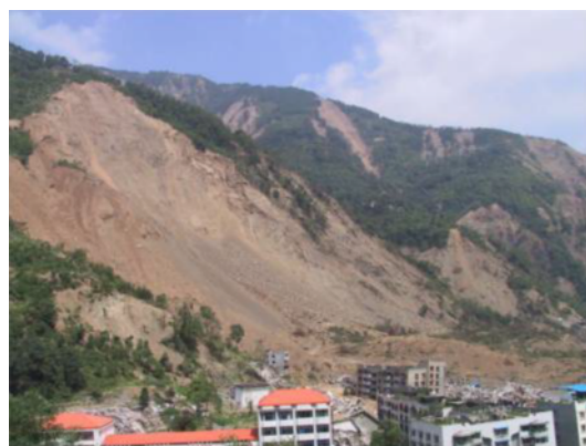
写真 4.2.5.2 大規模な土砂崩落 (北川羌族自治州曲山鎮)
