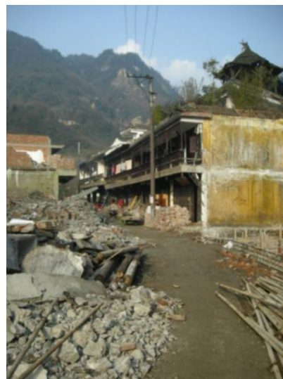
写真 6.3.5.4 被災した建築
