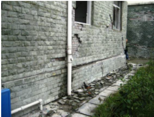
写真 5.14 基礎と上部構造のずれ（映秀） 写真 5.15 基礎と柱脚の詳細（映秀）
