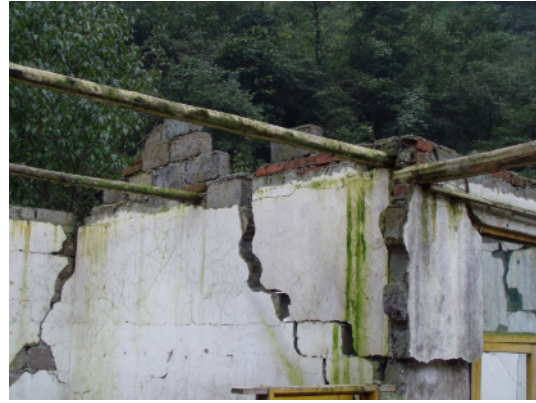
写真 4.2.7.4 コンクリートブロック造 (No.5) ゲーブルの崩壊、屋根の落下、 壁のせん断破壊が見られる
