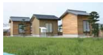
屋内環境 測定 実験棟
