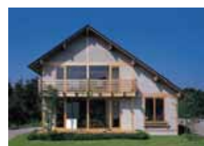
外壁真壁の外観
