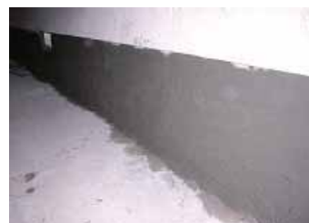
③鉄筋コンクリート並の強度を実現
