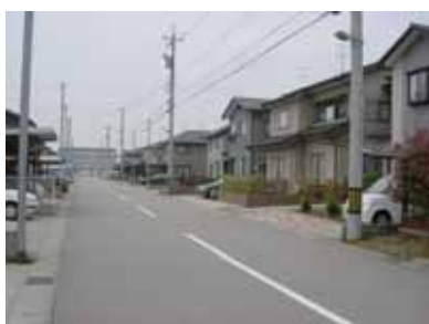
●ルールの無い街並みと区割りを優先した住宅地（日本）
