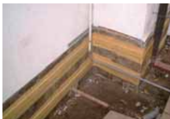
②帯鋼の上にアラミド繊維シートを樹脂接着剤で貼る
