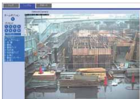
マンションの建設現場に複数の固定カメラを設置し、ライブ映像をインターネットで配信
