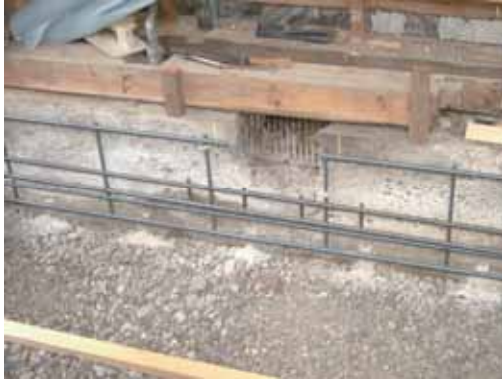
◆RUM-BR工法：配筋施工中
