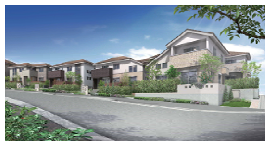
環境共生住宅への取り組み：近鉄白庭台施工事例
