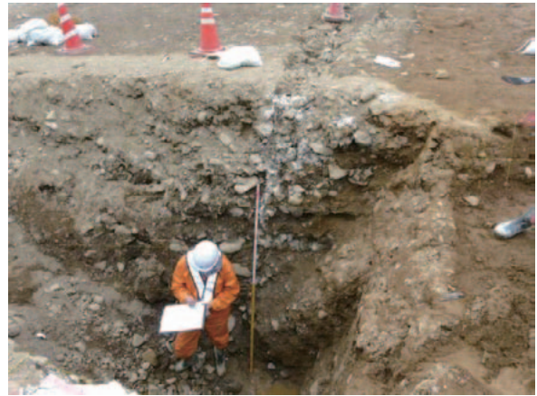
写真-5.13 亀裂深度調査開削状況（フィルター部）（東北地方整備局胆沢ダム工事事務所提供）
