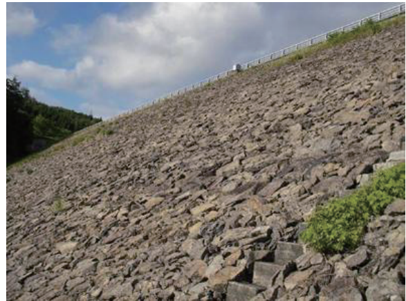
写真-5.26 堤体下流面の状況（リップラップのずれも認められない）
