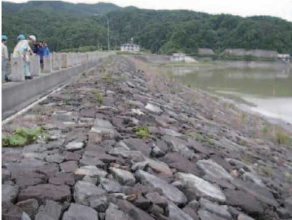
写真-5.21 堤体上流面の状況（リップラップのずれは認められない）
