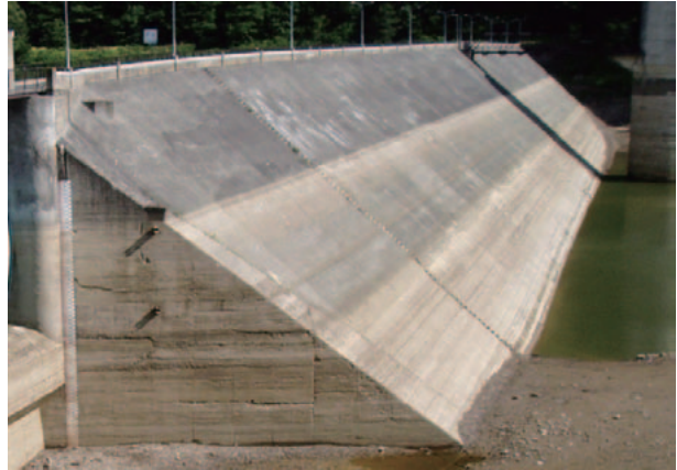
写真-5.1(b) 地震前の上流遮水壁状態(2006年8月撮影)(東北地方整備局北上川ダム統合管理事務所提供)
