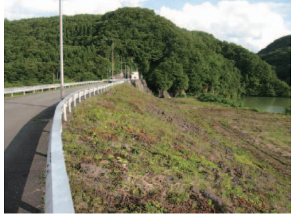
写真-5.47 衣川2号ダム堤体（フィルダム堤体部）
