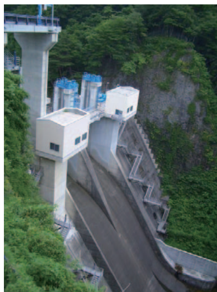
写真-5.35 花山ダム堤体
