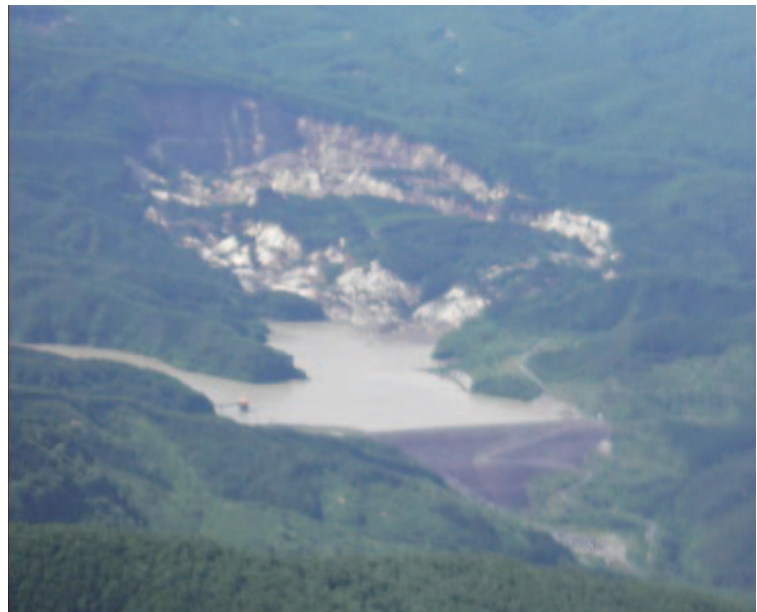
写真-5.18 荒砥沢ダムと貯水池周辺で発生した地すべり（6月15日14:24撮影）
