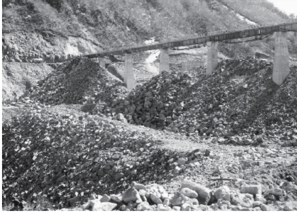
写真-5.6 投石工法による盛立工事 中の石淵ダム（トロッコ軌道の ピアは堤体内に埋没させた） （東北地方整備局北上川ダム 統合管理事務所提供）
