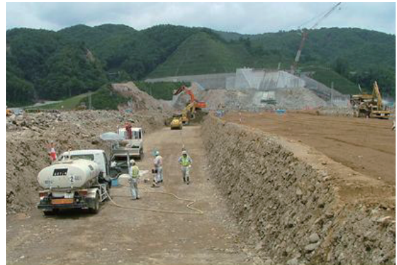
写真-5.15 フィルターの再盛立のための掘削状況（東北地方整備局胆沢ダム工事事務所提供）
