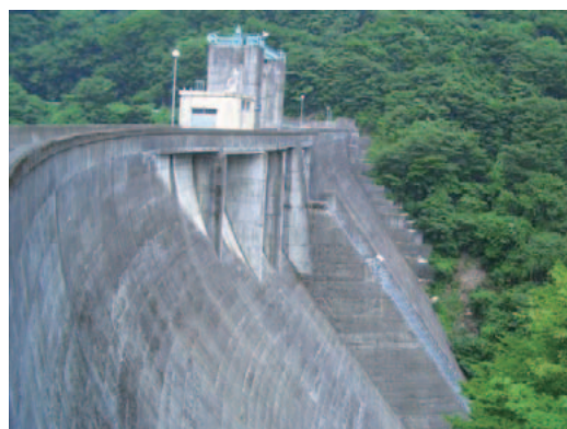
写真-5.36 栗駒ダム堤体
