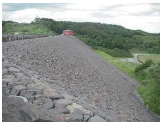
写真-5.34 堤体下流面の状況（リップラップにずれは認められない）
