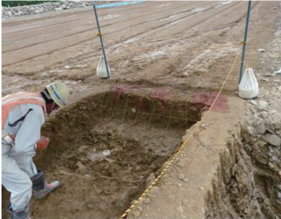
写真-5.12 亀裂深度調査開削状況（コア部）（東北地方整備局胆沢ダム工事事務所提供）
