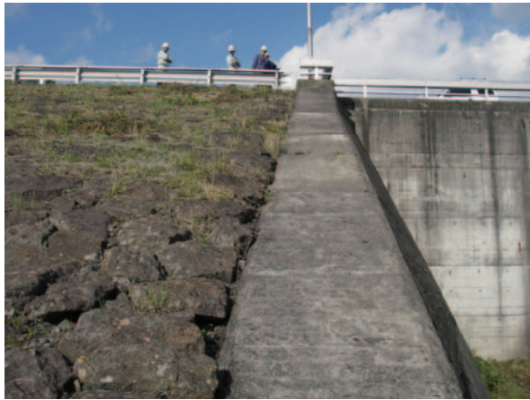
写真-5.48 衣川2号ダム堤体（セパレートウォール周辺上流部）
