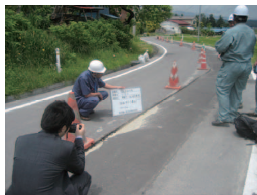
写真-4.4 埋戻し部沈下【栗原市・一迫清水塚の原】
