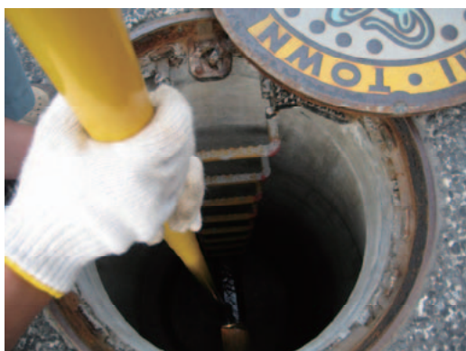
写真-4.13 管路施設の現地調査の様子（岩泉町）
