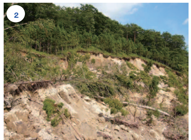
写真-3.4.35 左岸の頭部滑落崖 (8月9日撮影)
