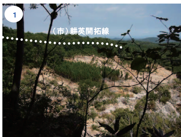
写真-3.4.34 左岸崩壊地の全景 (8月9日撮影)
