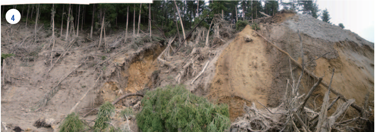
写真-3.4.7 地すべり本体の末端部には、斜面への泥の付着や倒木が見られる。このことから、地すべり本体が尾根地形部に衝突したと考えられる。(6月22日撮影)
