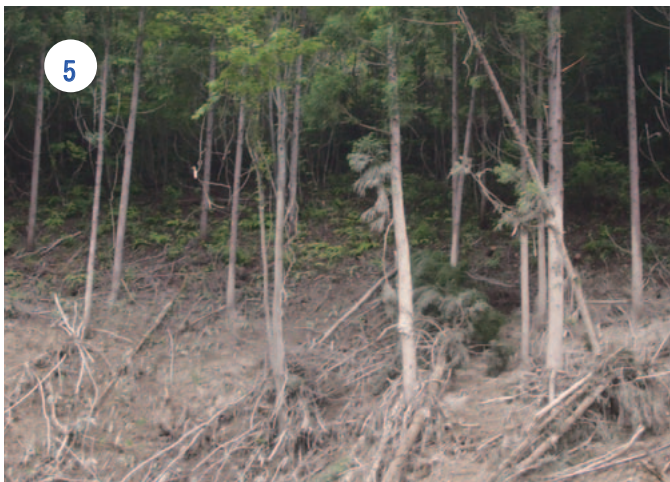
写真-3.4.8 上記の立木箇所との近接。斜面裾部から高さ約10mまで倒木し、その上方の立木にも泥が飛散している。(6月22日撮影)
