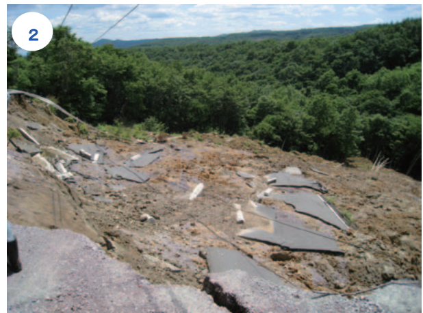
写真-3.4.38 崩壊土砂の堆積状況 （7月15日撮影）
