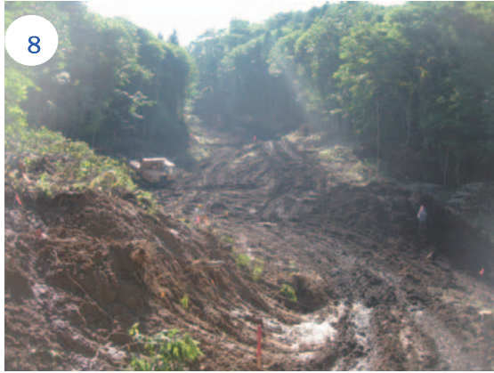
写真-3.4.20 仮設道路建設状況（7月14日撮影）
