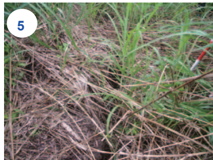
写真-3.4.17 市道北側の休耕地の連続した新しい開口亀裂 (6月22日撮影)
