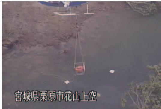
図-3.7.3 ヘリコプターによる設置の様子
