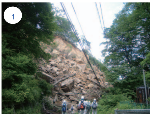
写真-3.4.45 地すべり末端部の状況（上流より）（7月15日撮影）
