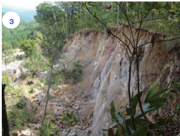
写真-3.4.36 右岸の頭部滑落崖（8月9日撮影）
