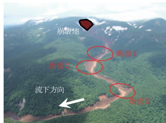
写真-3.5.1 三迫川上流で発生した土石流の状況 (6月15日撮影)
