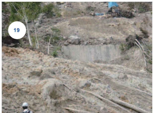
写真-3.4.33 市道からみた御沢支川の全景（8月9日撮影）
