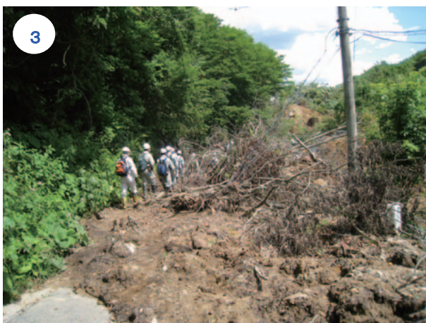
写真-3.4.43 県道に堆積した崩土 (7月15日撮影)
