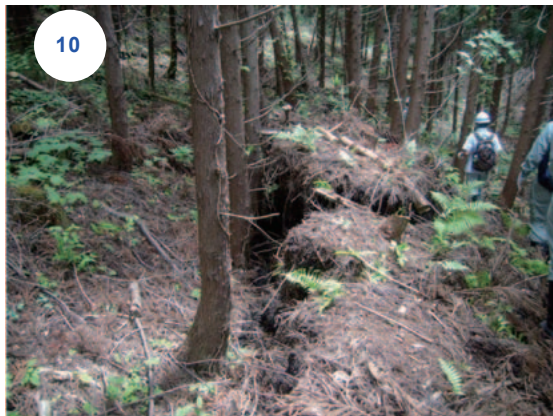
写真-3.4.22 地すべり背後地に生じた段差（7月14日撮影）
