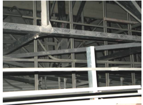
図-4.41 上部から曲面状仕上げ部分を見下げ
