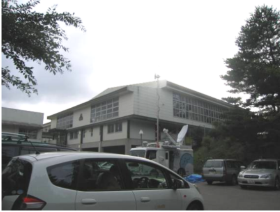
図-4.6 B 建築物外観（東側より）
