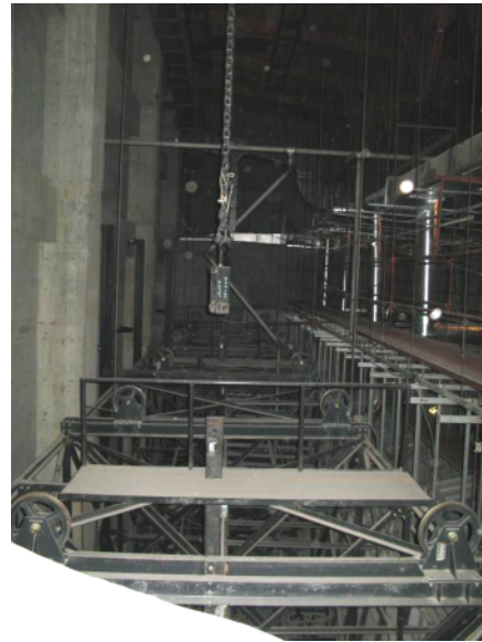
図-4.35 同上部の吊り状況
