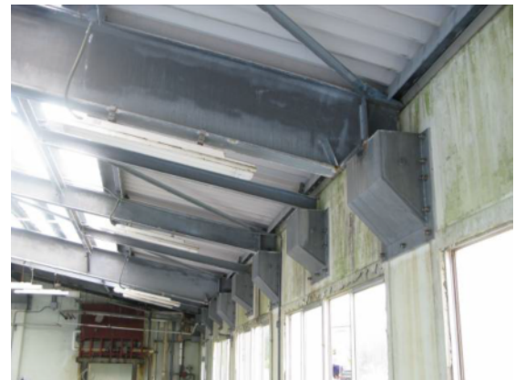
図-4.29 屋根大梁端部(突出部の鋼板は改修時のもの)
