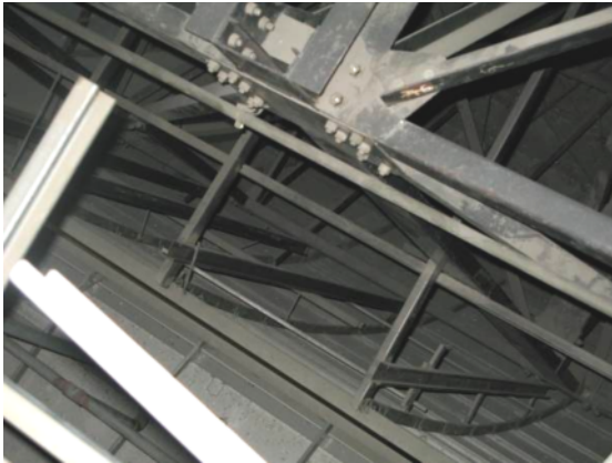
図-4.40 上部から曲面状仕上げ部分を見下げ
