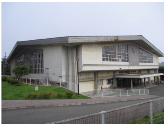
図-4.13 C 建築物外観（北西より）
