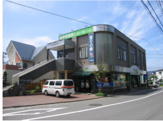
図-4.50 脱落箇所と逆側の面
