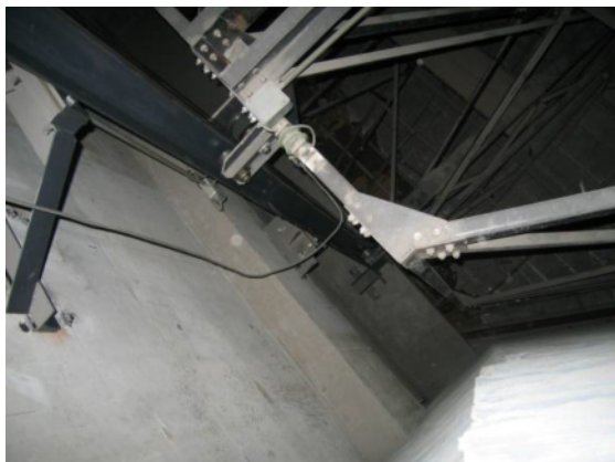
図-4.36 同骨組みとガイドレール取り付け
