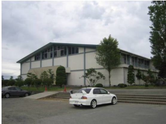
図-4.6 B建築物外観（北西方向より）
