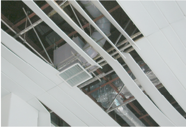
図-4.32 天井裏の状況
