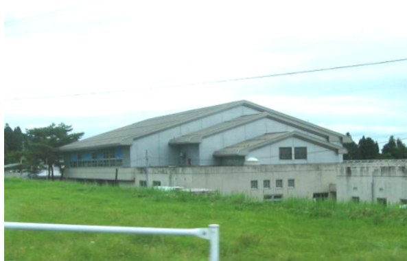
図-4.16 D 建築物外観
