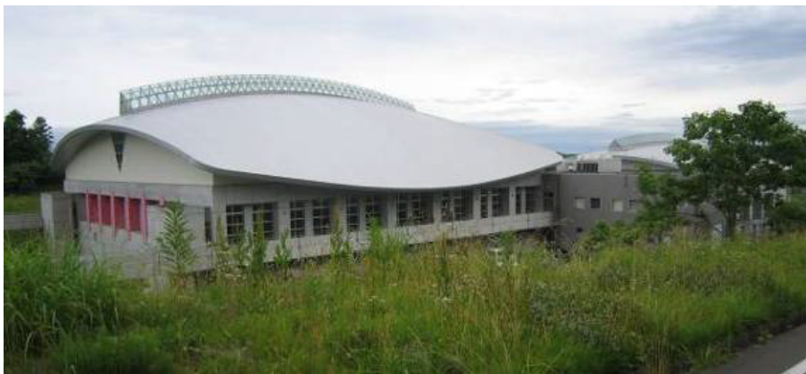
図-4.22 E 建築物外観（左が体育館、右が屋内プール棟）
