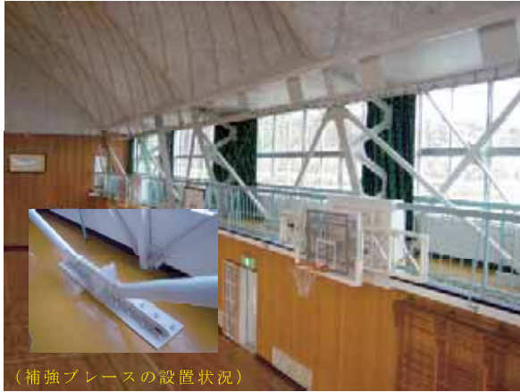
写真 6.1 既存ブレースと補強ブレースの設置
