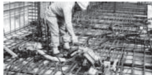
図5 鉄筋接合への適用事例
