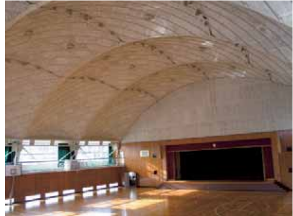
写真 6.2 天井等非構造部材の被害無し
