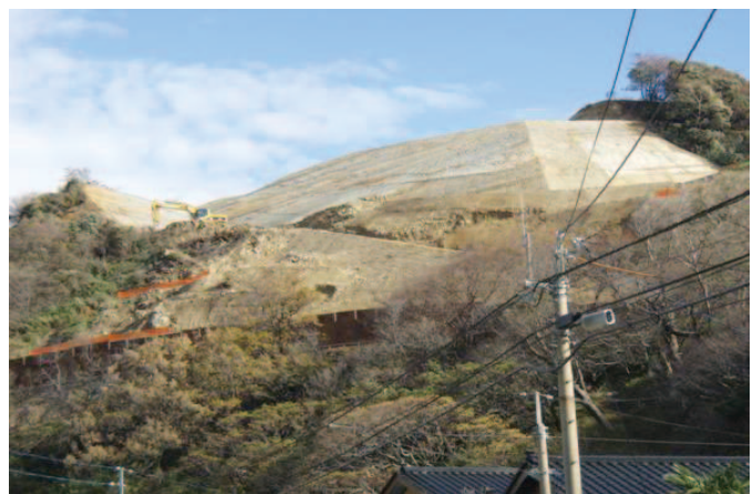
写真-3.15 対策状況 (新潟県提供：11月20日撮影)
