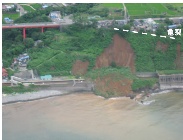
写真-3.6 地すべり全景(北陸地方整備局提供)
