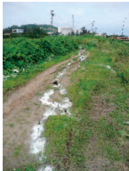
写真-9.4.24 地割れの延長線上にある損傷したゴミ焼却場の煙突
