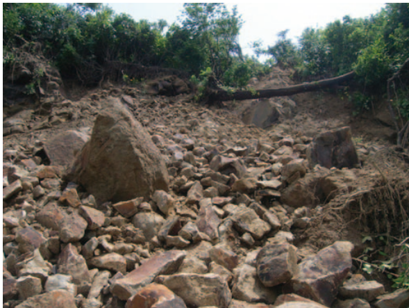
写真-3.13 崩落土砂(7月19日撮影)
