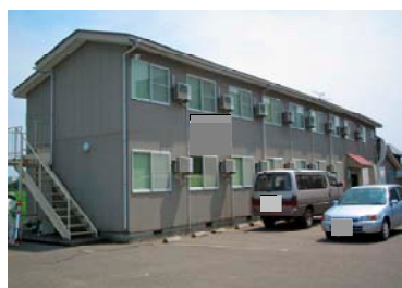
写真-9.7.11 液状化による木造建物の被害状況 （基礎形式：直接基礎、数十 cm の不同沈下）
