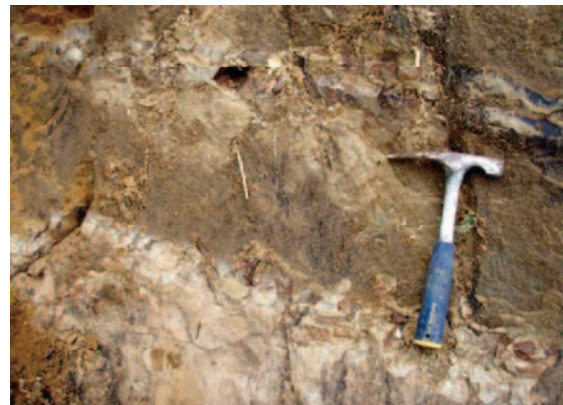
写真-8.3.24 崩壊斜面の凝灰質砂岩の露頭
