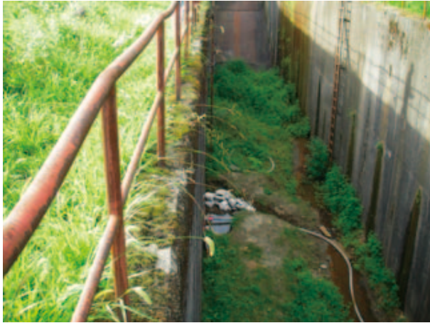
写真-6.20 仮設管による浸透流導水状況 (浸透流導水管が土砂により詰まったため、 導水管を切断し、仮設管による導水を実施)
