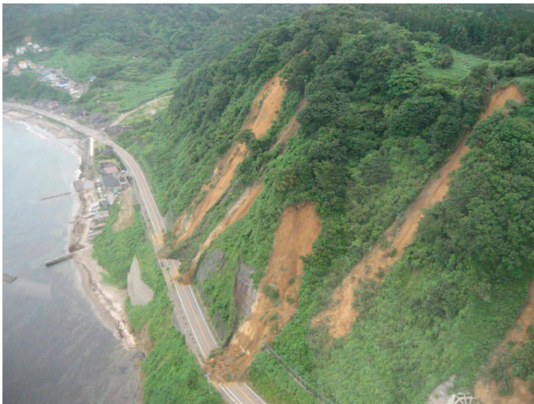
写真-8.3.17 崩壊による国道の被災状況
