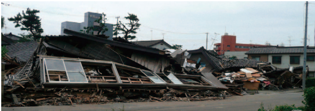
写真-9.4.7 倒壊家屋が連続する新花町
