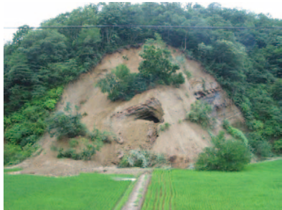
写真-3.3 内陸部で発生した崩壊（長岡市（旧小国町）渋海川支川芝ノ又川の右岸）
