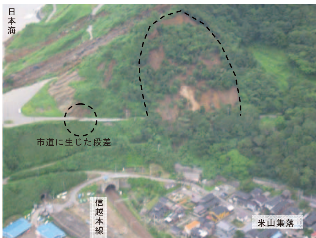
写真-3.10 地すべり全景(北陸地方整備局提供)
