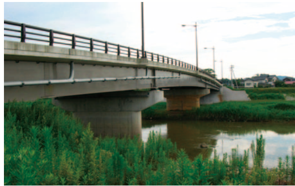
写真-7.22 なごみ橋
