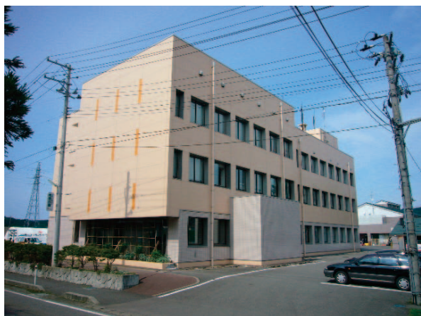
写真-9.3.7 西山町事務所外観(西から)
