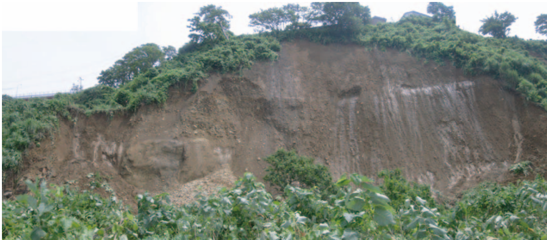
写真-3.8 崩落面の状況（7月19日撮影）
