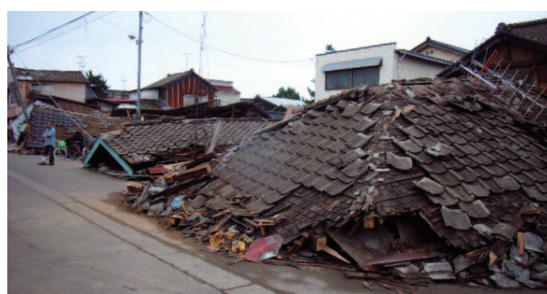
写真-9.4.2 軒並み倒壊した古い構法による家屋
