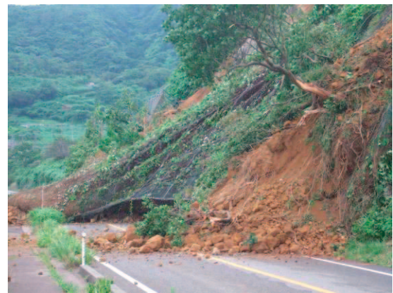
写真-8.3.22 国道に堆積した崩積土
