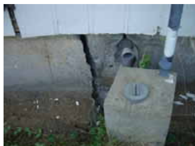
写真-9.7.8 住宅基礎の被害例
