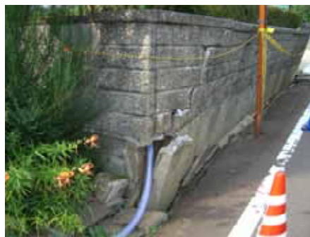
写真-9.7.7 擁壁の被害例
