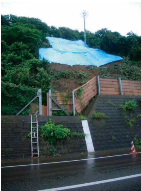
図-8.3.12 上越市竹鼻（国道 8 号）の表層崩壊の写真およびスケッチ図
