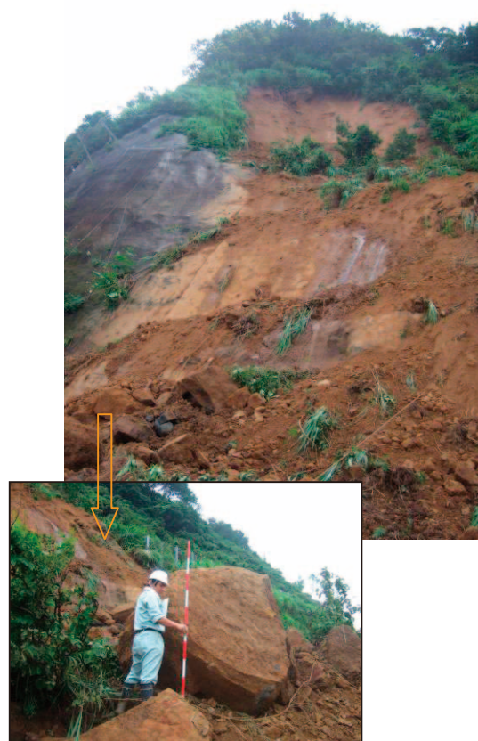
写真-8.3.19 斜面崩壊と国道に到達した巨石（φ=3m）
