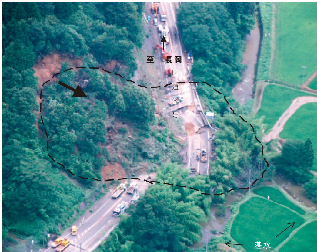
写真-8.3.2 被災直後の大積地すべり
