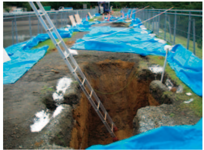
写真-6.13 トレンチ坑掘削状況 (手前はトレンチ坑⑤⑥)
