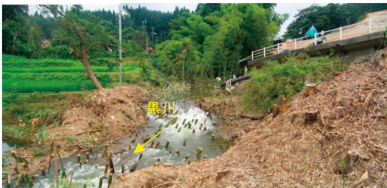
写真-8.3.15 末端部の黒川への押し出し状況（竹木の伐採後）
