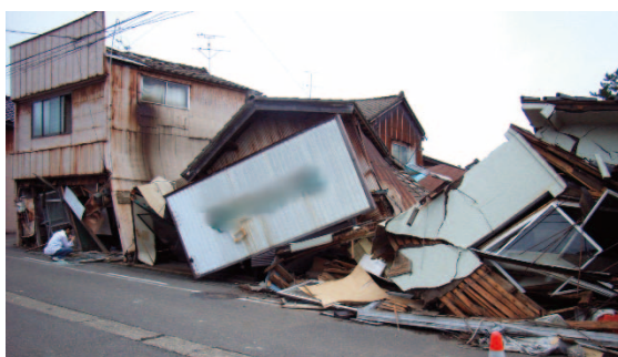
写真-9.4.3 倒壊した店舗併用住宅
