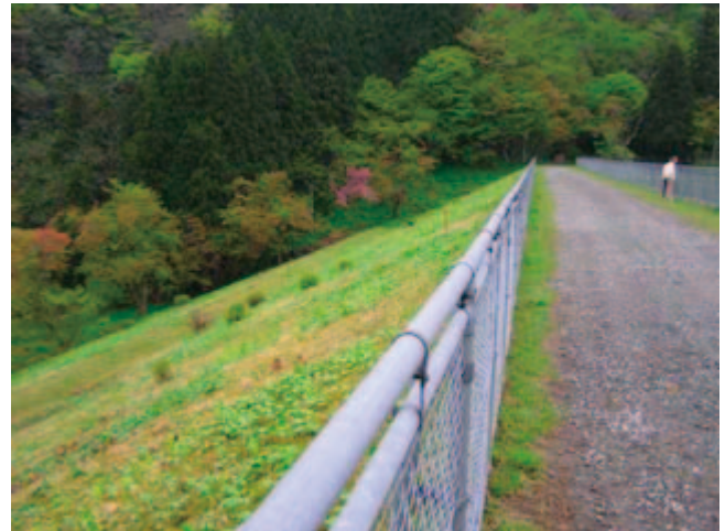
写真-6.8 地震前の天端欄干手すりの状況 （2005.4.29 撮影）（© damsuki.com）
