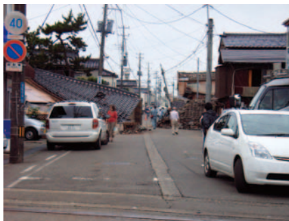
写真-9.4.1 東本町 3 丁目で道路閉塞した倒壊家屋群
