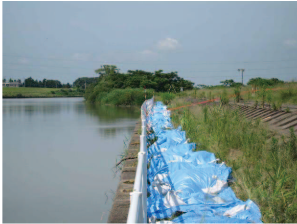
写真-5.6 低水護岸矢板の被災状況（下流側から上流側を望む）
