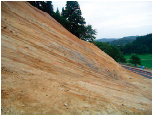
写真-8.3.11 地すべり斜面整形後に現れた砂岩・シルト岩の互層
