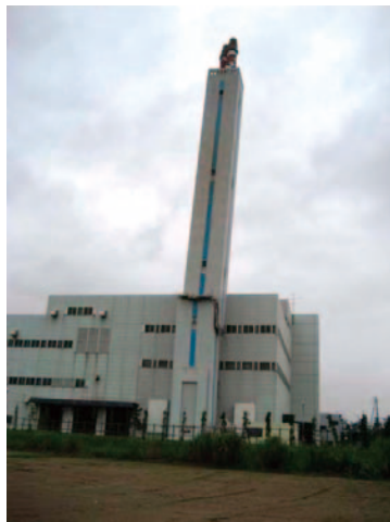
写真-9.5.1 柏崎市橋場にある塔状工作物（自立型煙突）の全景
