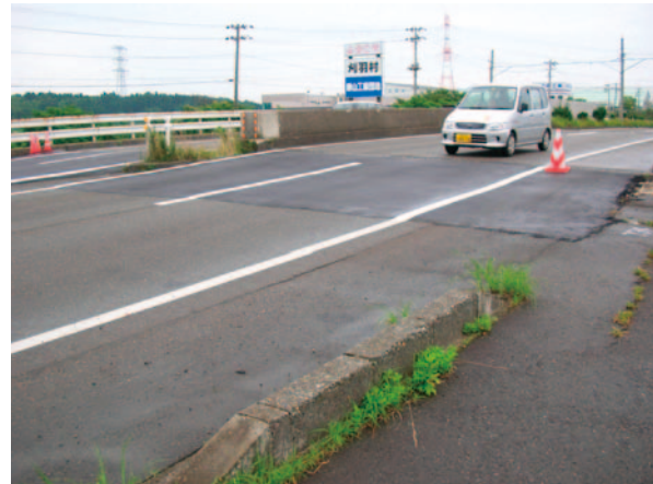
写真-7.37 橋台背面土の沈下（補修後）
