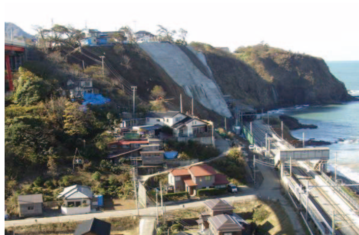
写真-3.9 対策状況（新潟県提供：11月20日撮影）
