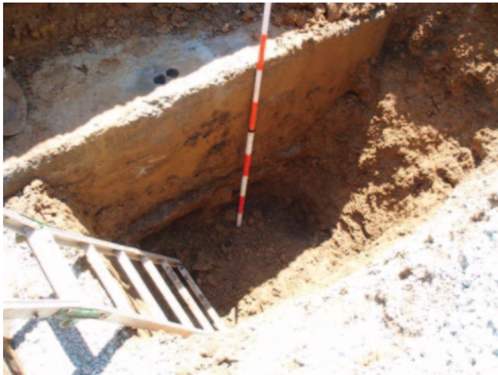
写真-6.14 トレンチ坑⑥によるコンクリート壁の高さ確認（1.25m；壁＋基礎部） （柏崎市提供）
