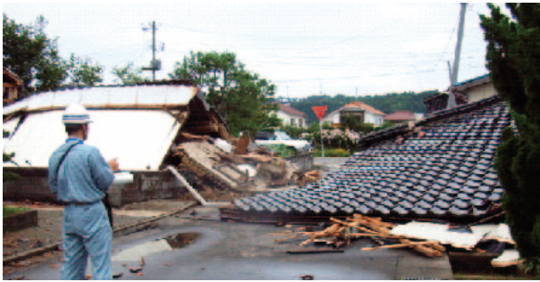
写真-9.4.25 倒壊して道路を塞いだ木造家屋
