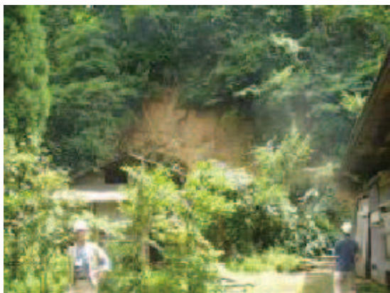
写真-3.1 新潟県長岡市大積善間町の急傾斜地崩壊危険箇所の点検状況
