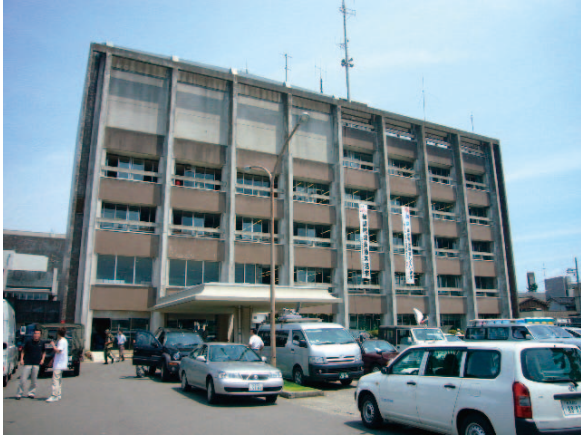
写真-9.3.1 柏崎市役所本館外観(南から)
