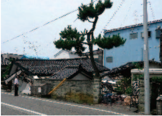
写真-9.4.10 一見新しく見える住宅の倒壊
