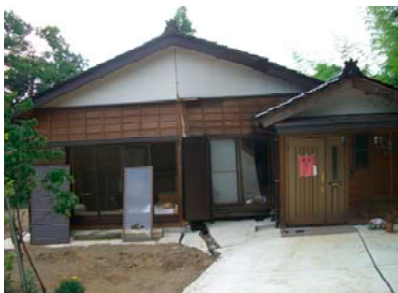
被災住宅 前面
