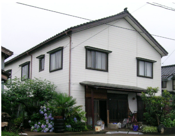
写真-4.3.2 T-1 外観
