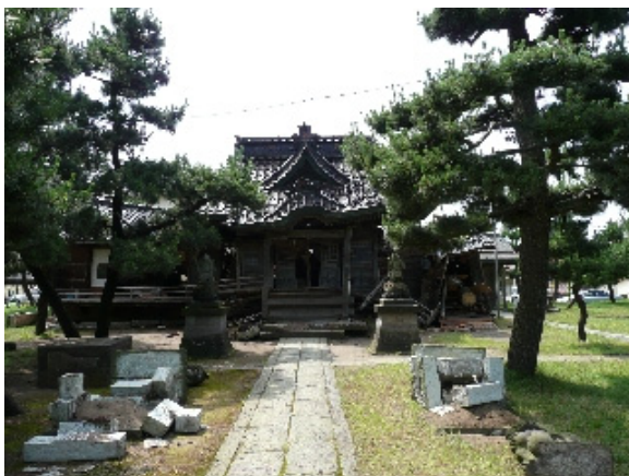
写真-4. 2. 33 壊滅的な被害を受けた新花町の 金比羅宮
