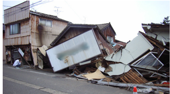
写真-4.2.12 倒壊した店舗併用住宅
