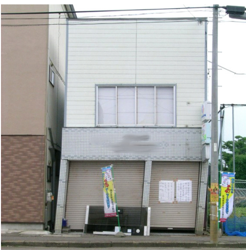
写真-4.3.35 道路からの全景
