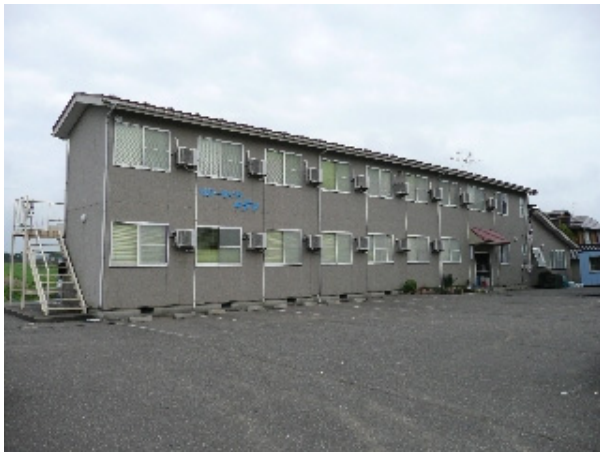
写真-4.2.57 一部損壊（裏手部分）した木造共同住宅
