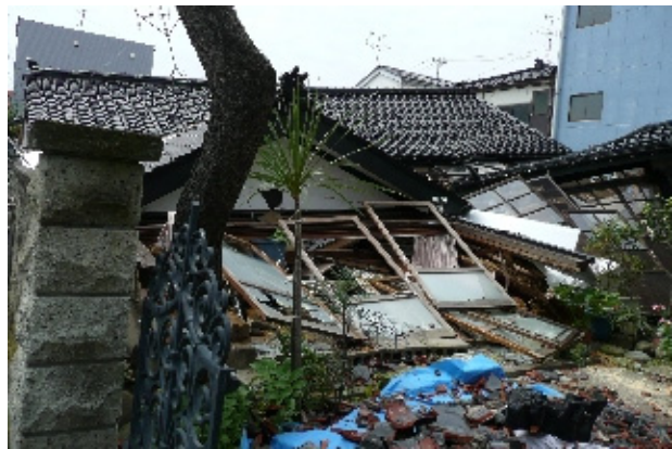
写真-4. 2. 32 写真-4. 2. 31 近景（土塗り壁の残骸 が確認された）
