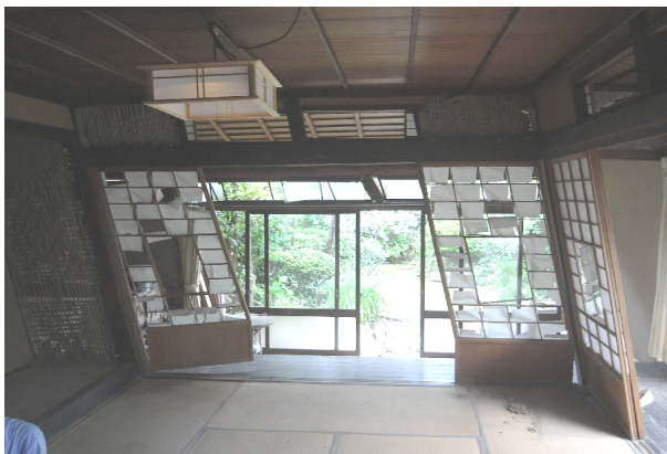
写真-4.3.31 H-2 内部
