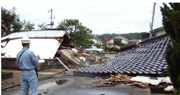
写真-4.2.1 倒壊して道路を塞いだ木造家屋
