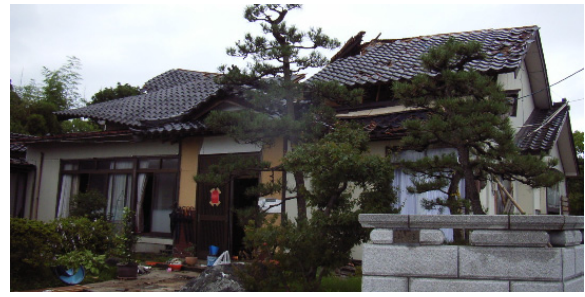
写真-4.2.4 小屋組の一部が崩壊する希少な被害例
