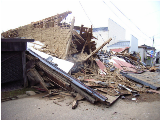
写真-4.2.15 土壁を有する古い構法の倒壊家屋
