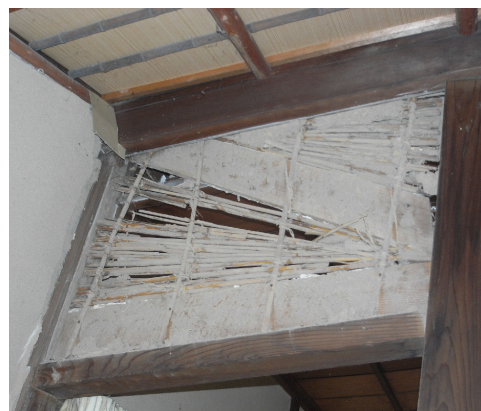
写真-4.3.32 垂れ壁の筋かい
