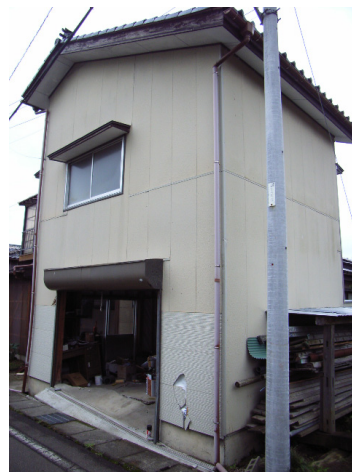
写真-4.2.6 外観上無被害の車庫
