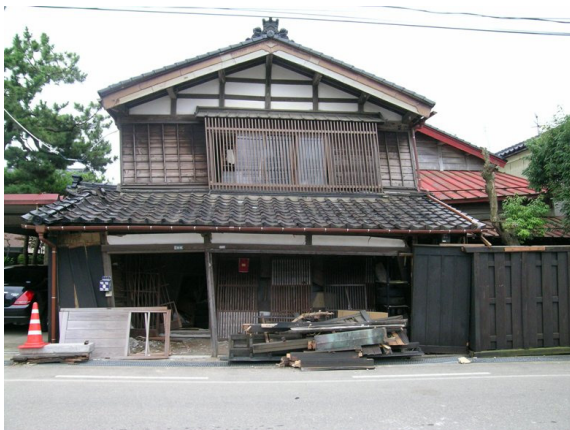
写真-4.3.39 道路からの全景
