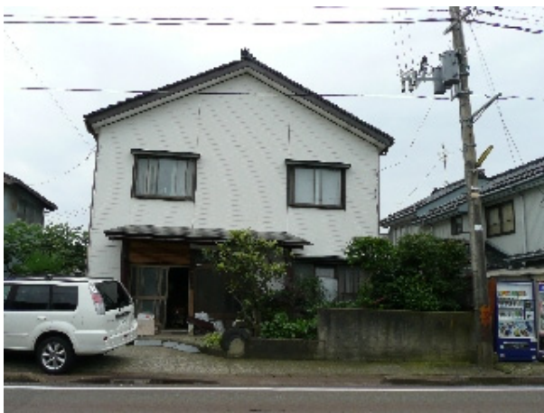
写真-4.2.21 多少の残留変形が残る住宅
