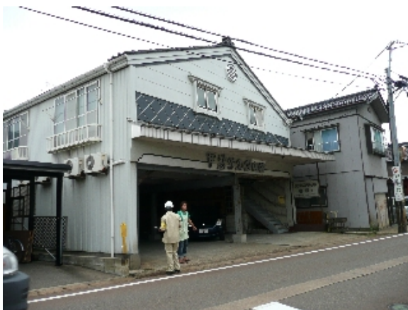
写真-4.2.38 1階に大きな車庫を取り、鉄骨と木造を併用した例
