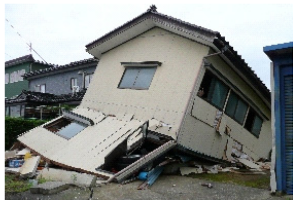
写真-4.2.18 倒壊した比較的新しい車庫兼作業所
