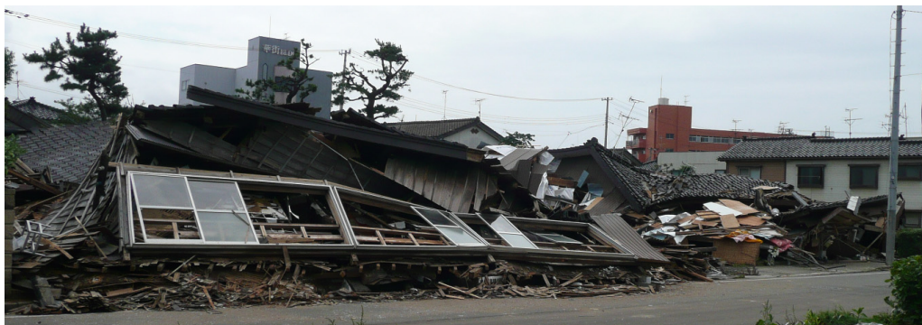
写真-4.2.28 倒壊家屋が連続する新花町
