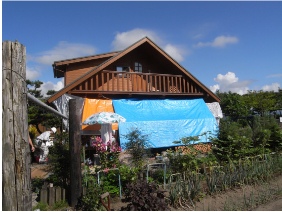
写真-4.3.71 全景 (ほとんど被害なし)
