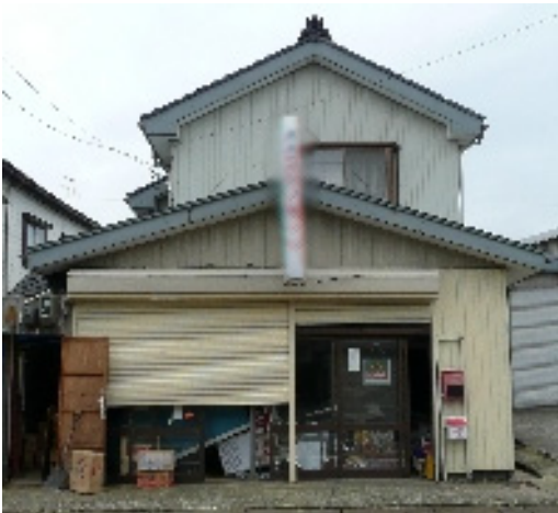
写真-4.3.8 T-2 外観
