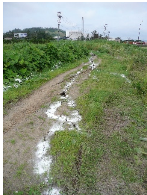
写真-4.2.52 ひび割れの進む方向にある損傷したクリーンセンターの煙突
