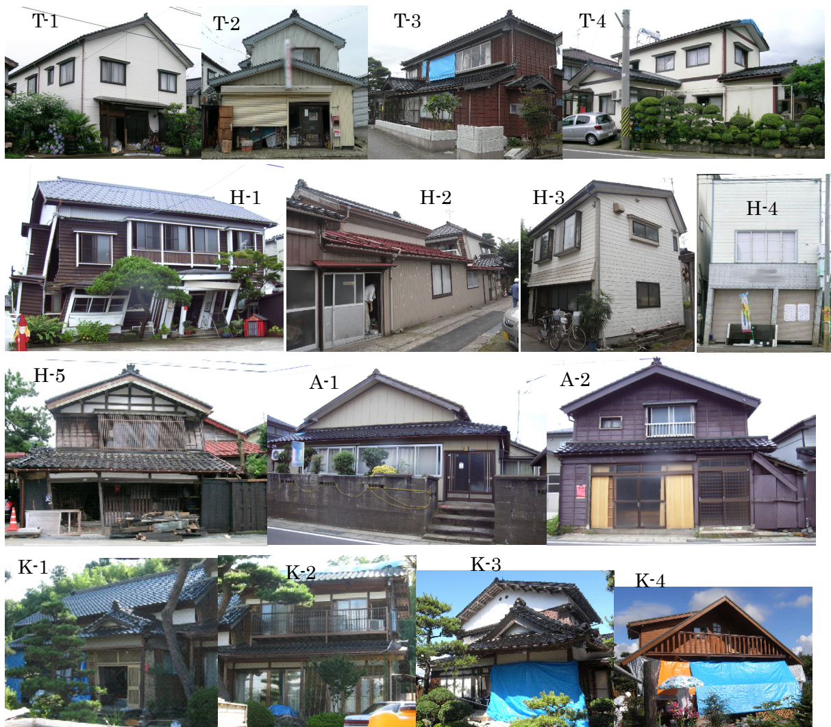
写真-4.3.1 詳細調査対象物件の外観
