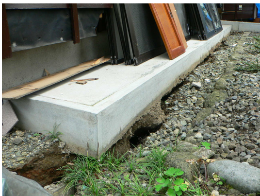
写真-4.3.68 周辺地盤と分離した布基礎
