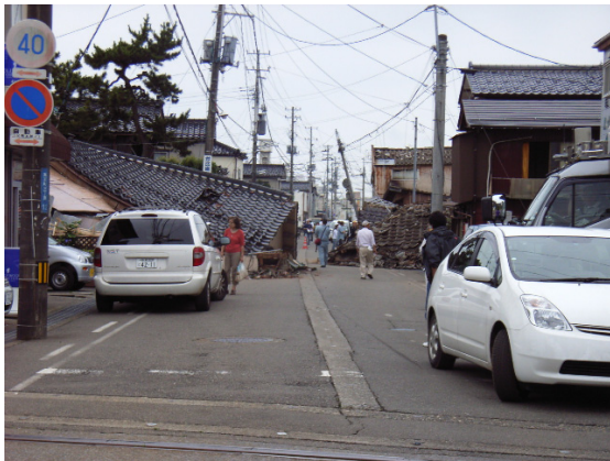
写真-4.2.9 東本町3丁目の倒壊家屋群
