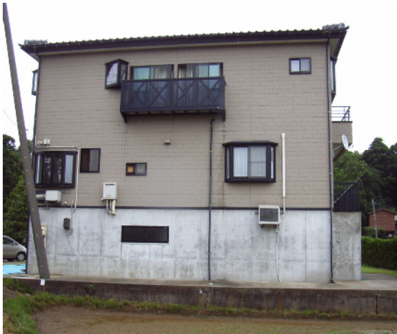
写真-4.2.5 ほぼ無被害の高床式住宅
