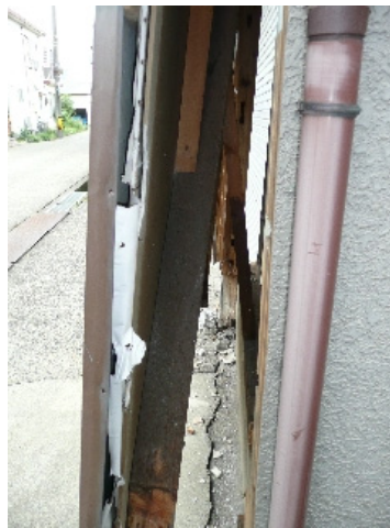
写真-4.2.42 写真-4.2.41の前面開口脇の 無開口壁に入る正角筋かい
