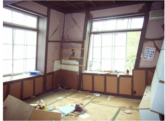
写真-4.3.23 H-1 内部
