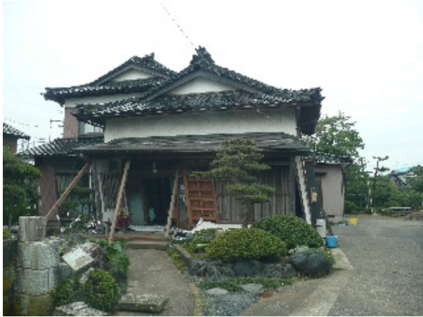
写真-4.2.19 大破した比較的古い構法による住宅
