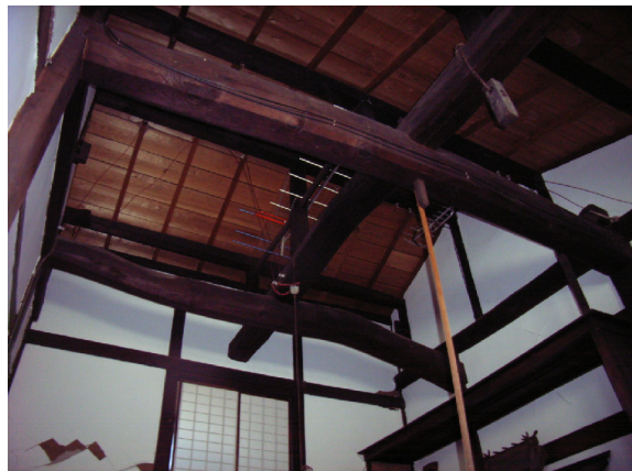
写真-4. 3. 50 吹抜部分上部 (サシヅクリ)
