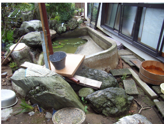
写真-4.3.6 池の浮き上がりと噴砂痕
