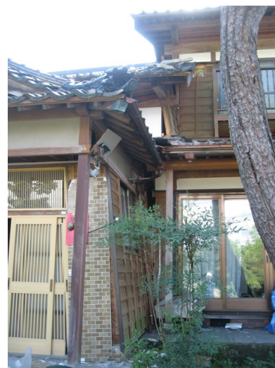
写真-4.3.60 平屋部分と増築部分の接合部分
