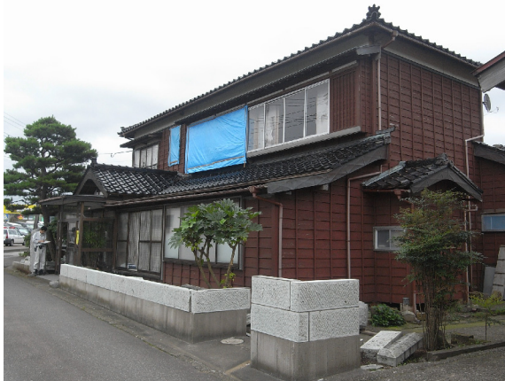
写真-4.3.14 T-3 外観
