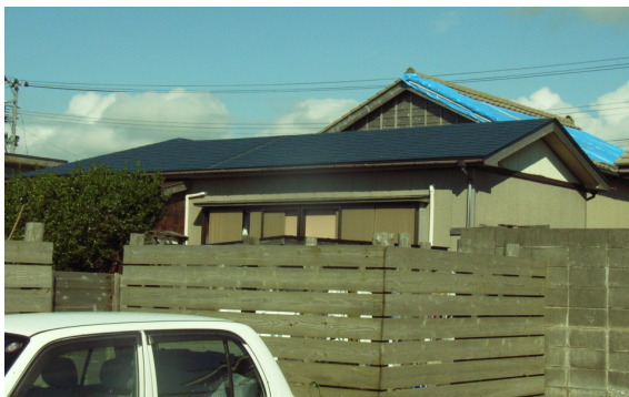
写真-4.3.46 手前の青い金属屋根が増築部分
