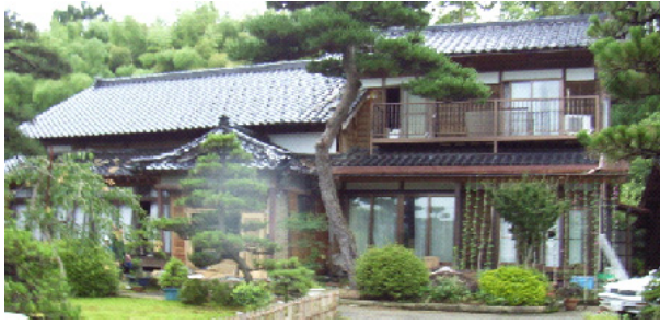
写真-4.2.3 比較的築年数が浅いように見受けられるにもかかわらず、残留変形が大きい木造家屋
