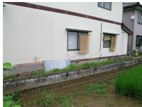
写真-4.3.19 水田側の擁壁
