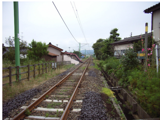
写真-4.2.10 線路に向かって倒壊した家屋
