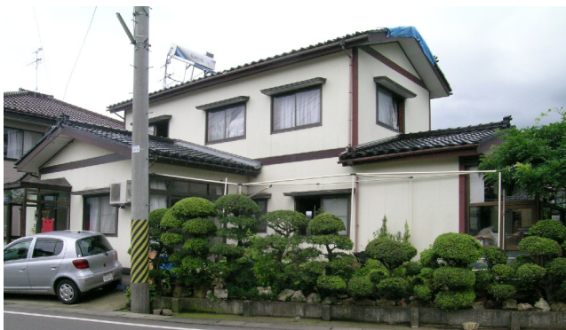
写真-4.3.18 T-4 外観
