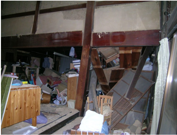
写真-4.3.41 H-5 内部の様子
