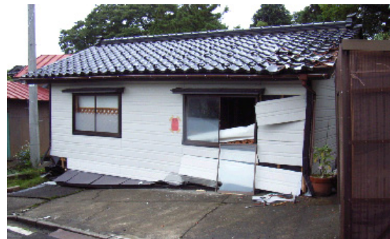
写真-4.2.2 新しい構工法でも倒壊した1階を車庫等にした家屋
