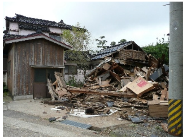
写真-4.2.37 車庫又は倉庫と推測される倒壊家屋
