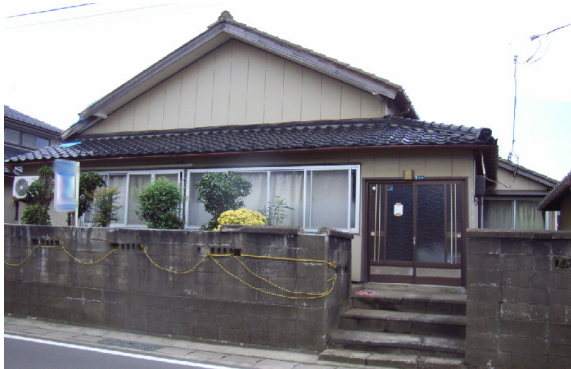
写真-4.3.43 A-1 外観
