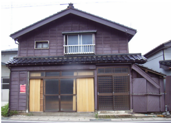
写真-4. 3. 49 A-2 外観
