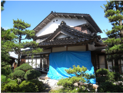
写真-4.3.64 K-3 全景（玄関部分に大きな被害）
