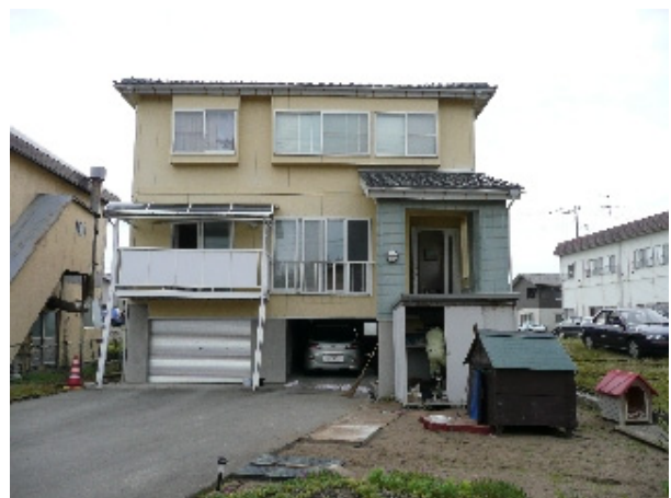
写真-4.2.54 地盤変状により大きな被害を受けた高床式木造（1階部分RC造）
