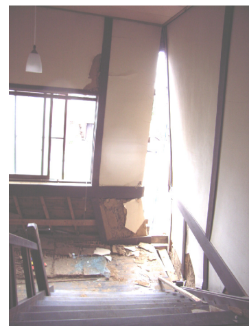
写真-4.3.28 通し柱から抜けた梁
