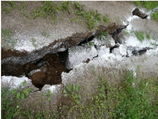
写真-4.2.51 鯖石川記念公園北側の土手を貫くひび割れ（深さ1 m以上）の北端部付近
