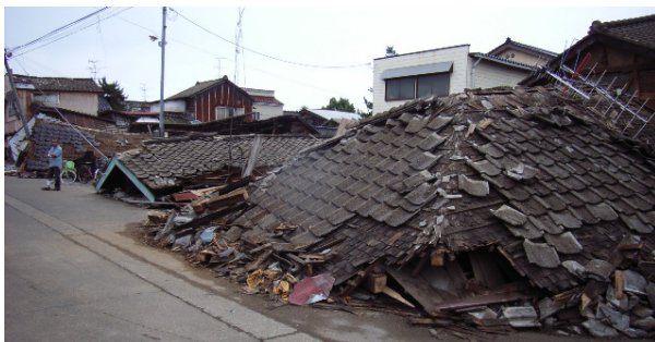
写真-4.2.11 軒並み倒壊した古い構法による家屋
