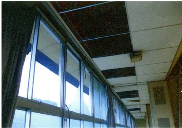
写真-7.27 被災直後のランニングロード上部の様子 写真-7.28 脱落しかけたガラスウールボード (加賀市役所提供資料より)
