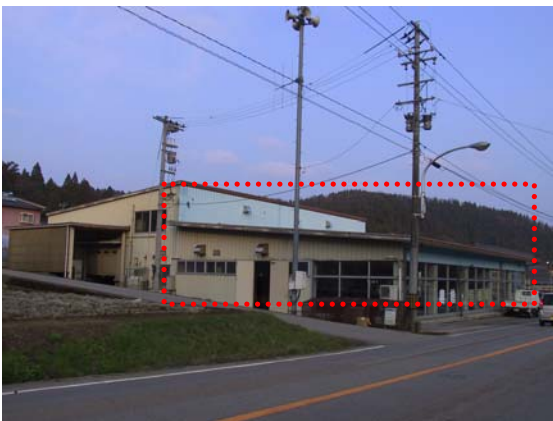
写真-7.35 建物L外観（破線部で天井被害を確認）
