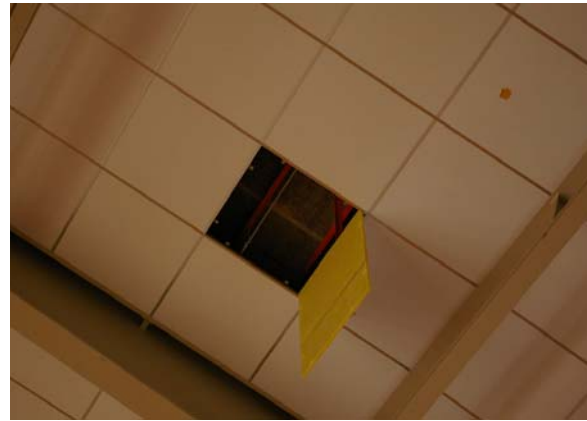
写真-7.27 被災直後のランニングロード上部の様子 写真-7.28 脱落しかけたガラスウールボード (加賀市役所提供資料より)
