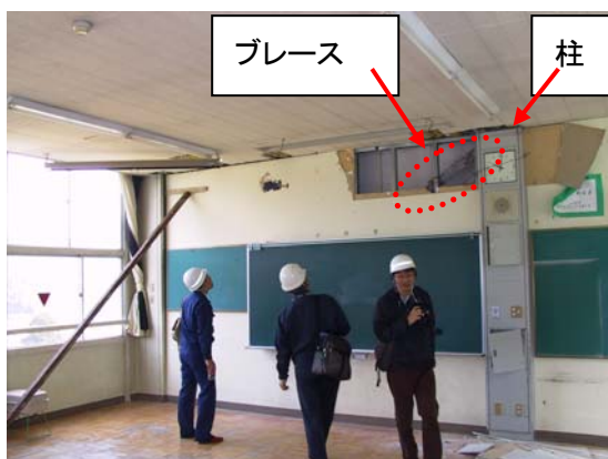
写真-5.7 張間方向のブレース
