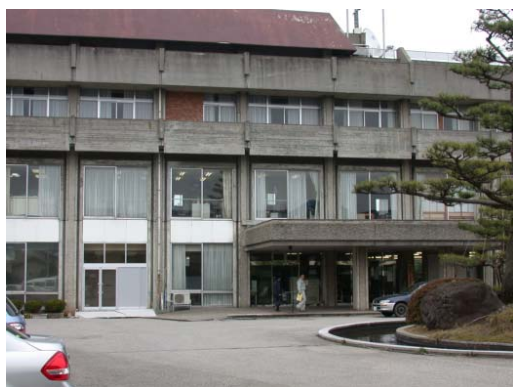
写真-6.14 七尾市役所田鶴浜支所
