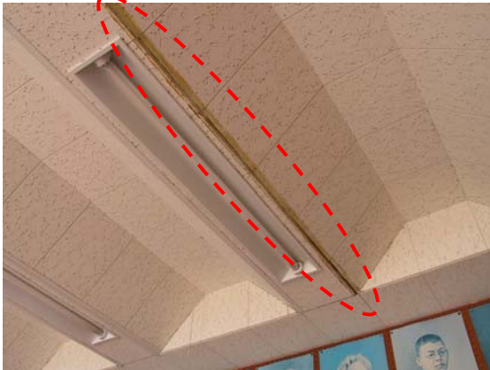
写真-5.18 音楽室の天井
