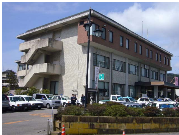
写真-3.6 門前支所概観(南東から)
