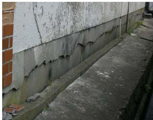
写真-8.5 ブロック基礎の被害例 (ブロックや土台の外周をモルタル等で覆って無筋コンクリートと区別が難しい場合もある)
