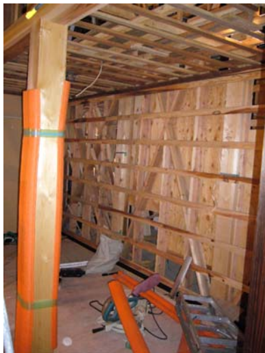
写真-4.110 筋かいが多数施工されている
