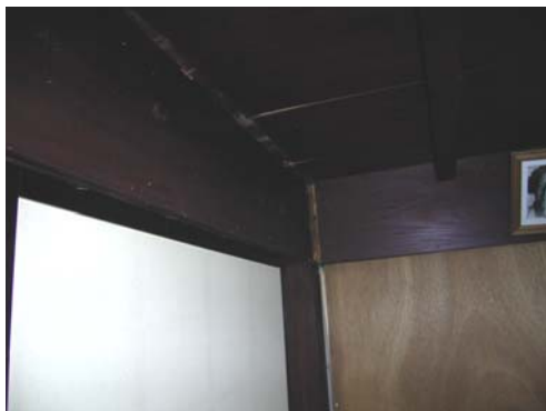
写真-4.68 改装時に設置された合板壁
