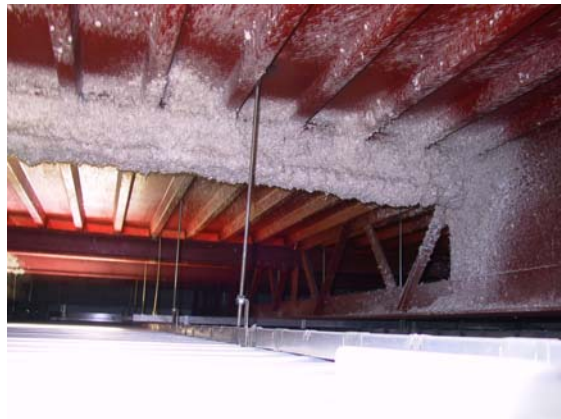
写真-5.10 天井裏の様子
