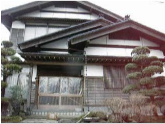
写真-4.45 外観上被害が軽微な建物
