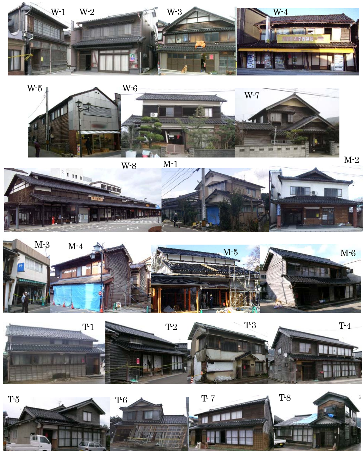
写真-4.57 詳細調査対象物件の外観
