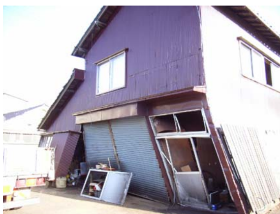
写真-4.2 倒壊寸前のチップ工場の倉庫
