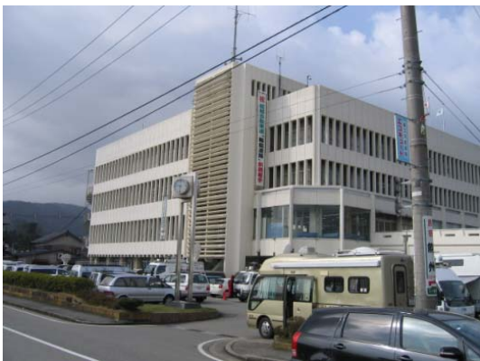
写真-6.1 輪島市役所
