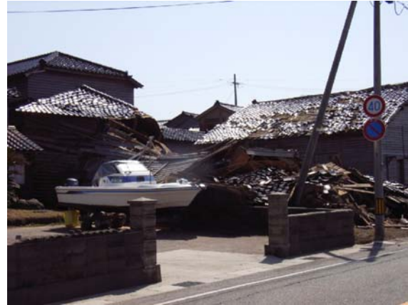
写真-4.34 倒壊した納屋又は倉庫
