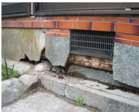
写真-8.5 ブロック基礎の被害例 (ブロックや土台の外周をモルタル等で覆って無筋コンクリートと区別が難しい場合もある)
