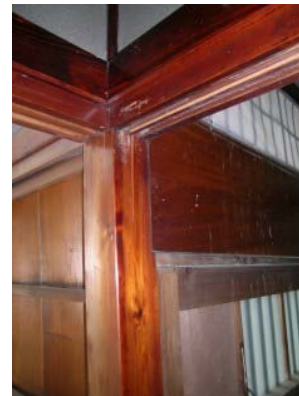
写真-4.59 内部の被害（柱の傾斜）
