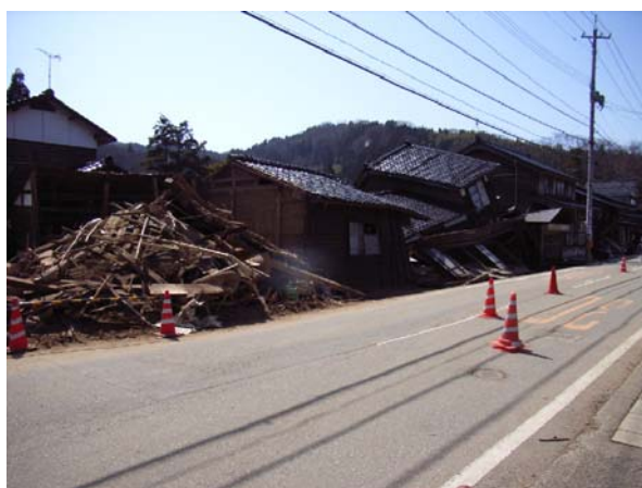
写真-4.13 倒壊家屋が建ち並ぶ門前地区
