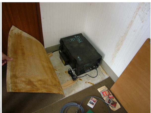
写真-3.4 輪島市役所 4階強震計設置状況
