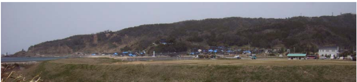
写真-4.35 鹿磯地区の遠景
