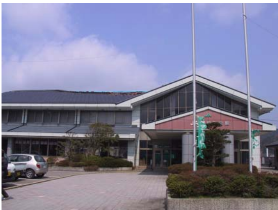
写真-7.39 建物Mの外観
