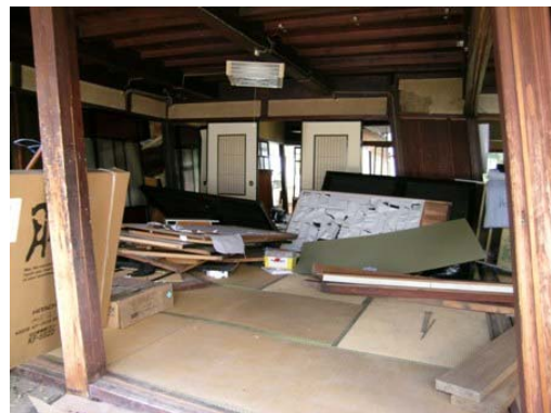
写真-4.115 内部の様子
