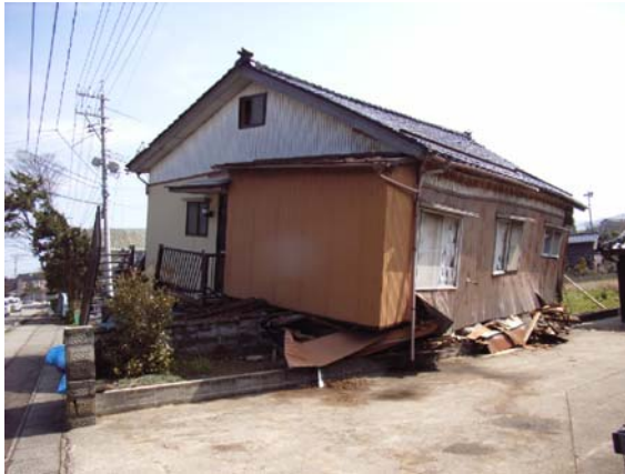
写真-4.11 小伊勢地区の倒壊家屋
