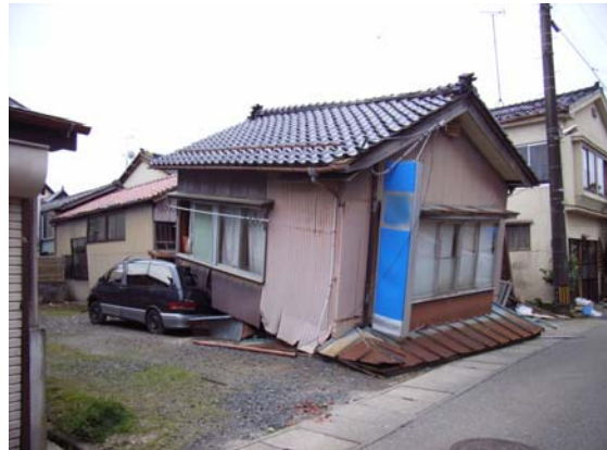
写真-4.42 倒壊し車両をつぶした家屋
