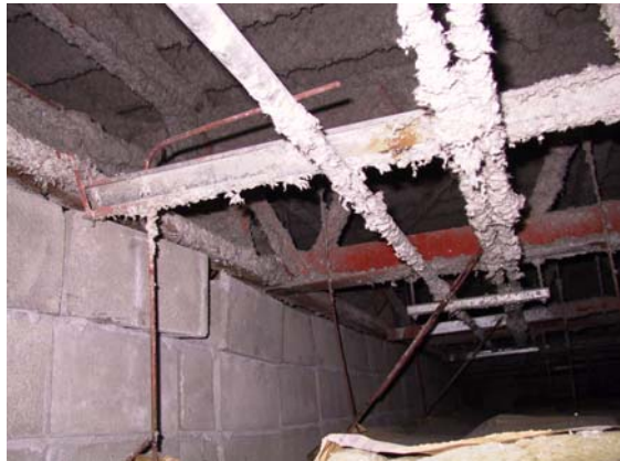
写真-5.19 音楽室と廊下の間仕切り壁
