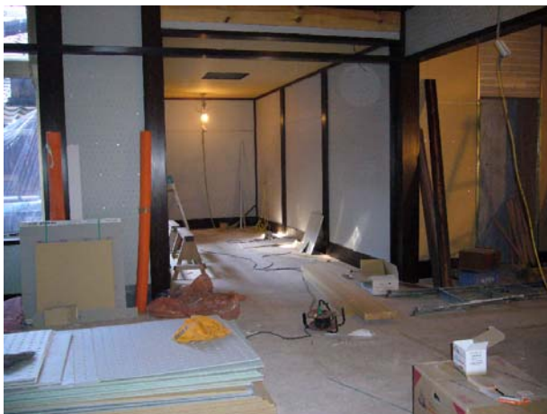
写真-4.112 施工中の内装
