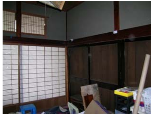
写真-4.59 内部の被害（柱の傾斜）
