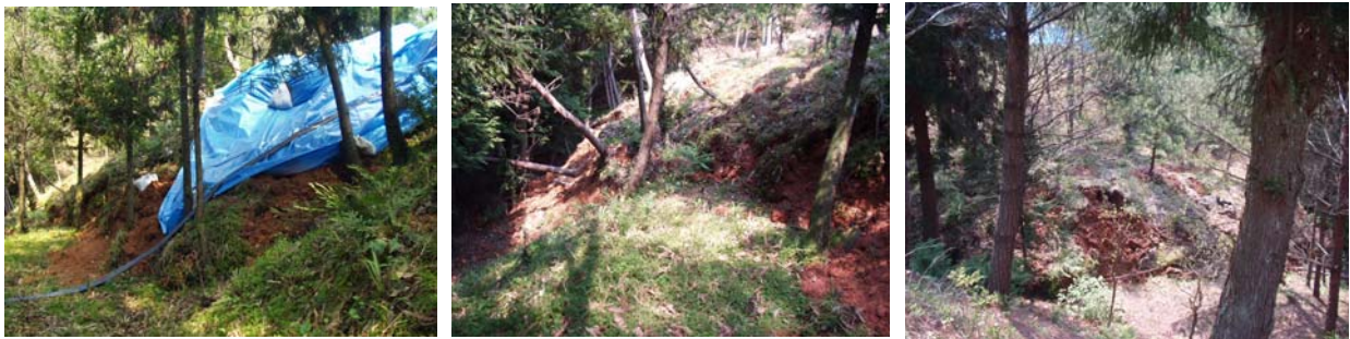
写真-8.15 崩壊した斜面の先端付近の状況
