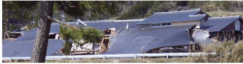
写真-4.36 鹿磯地区で倒壊した製材工場
