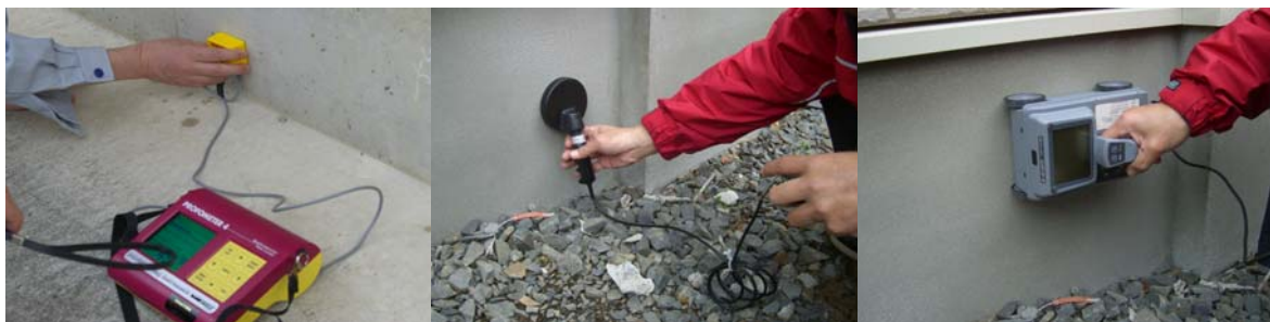
写真-8.9 鉄筋計による基礎コンクリートの配筋等の調査
