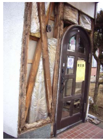
写真-4.46 衝突して外側へ傾いた建物
