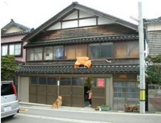
写真-4.66 全景 (2 階に筋かいが見える)
