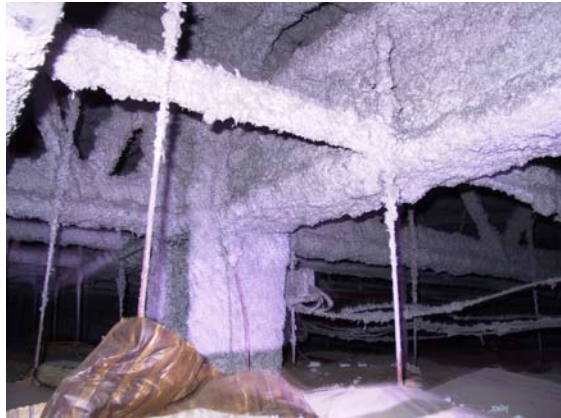
写真-5.21 柱梁接合部
