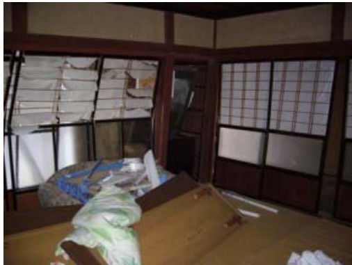
写真-4.133 筋かいが多数施工されている
