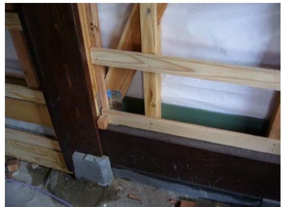
写真-4.111 筋かい端部には所定の金物
