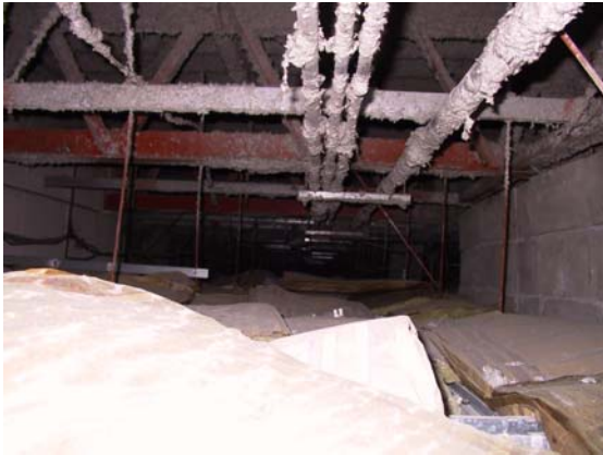
写真-5.20 張間方向のラチス梁
