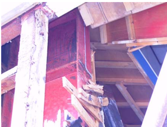
写真-5.25 柱（梁のH形鋼の跡が見える）
