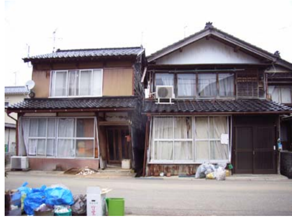
写真-4.46 衝突して外側へ傾いた建物
