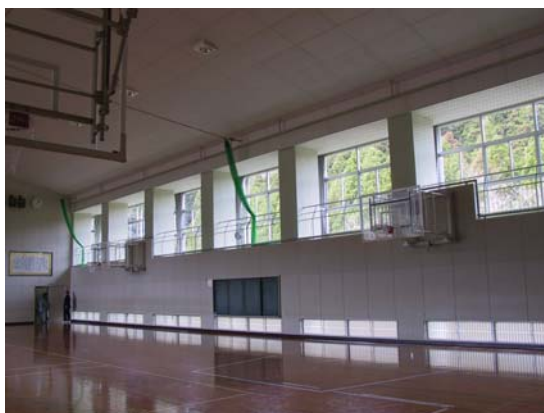
写真-5.1 2階までRC造の体育館
