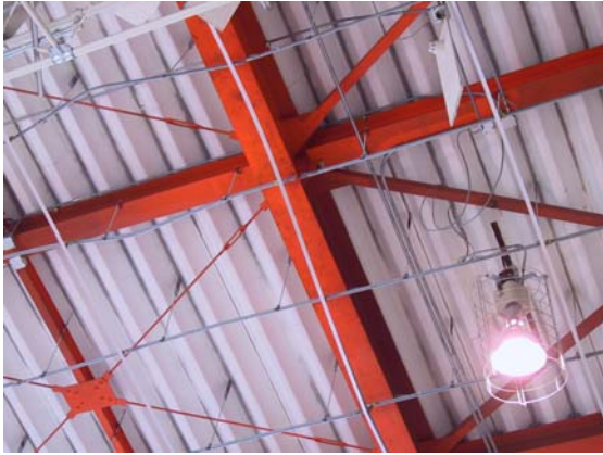
写真-7.13 天井下地の様子
