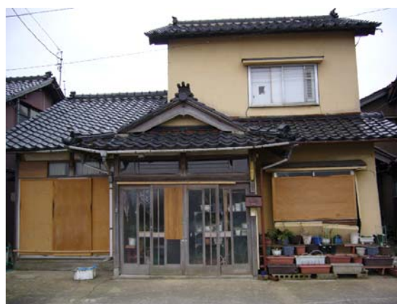
写真-4.52 国道 249 号線沿いの被害家屋
