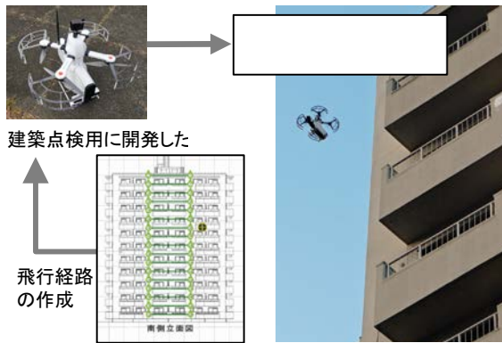
ドローンによる外壁点検の事例
