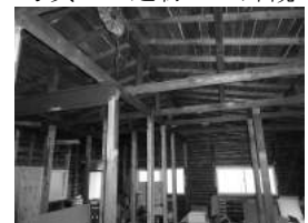
写真 2 軸組表しの二階内部 （写真 1、2 は筆者撮影）
