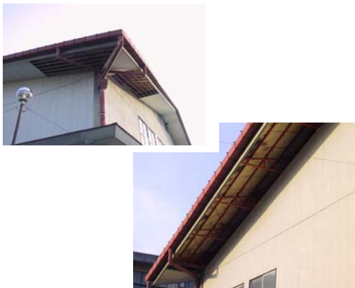
農協施設（屋根剥離、窓ガラス破損、天井落下）
