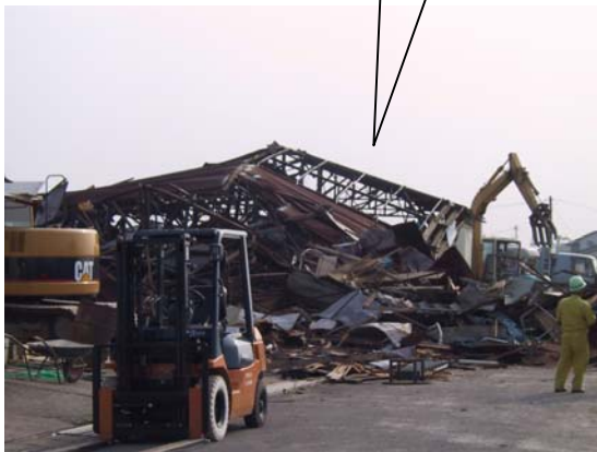
建設資材置場（鉄骨造倉庫の崩壊）
