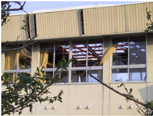
農協施設（屋根剥離、窓ガラス破損、天井落下）
