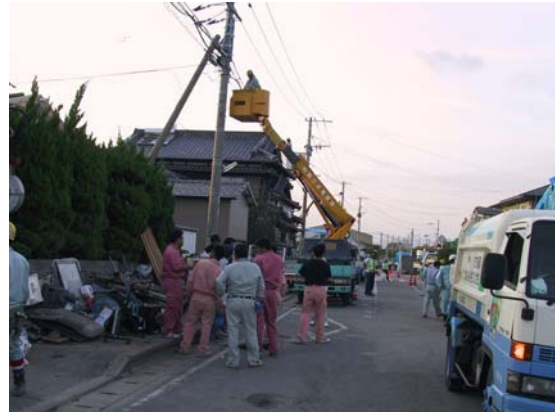
電線等の復旧工事
