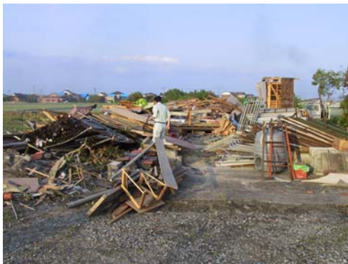
全壊した作業場
