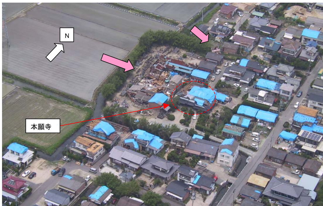
本願寺周辺（中央が本願寺（屋根の崩壊） 本願寺西側の縫製工場の崩壊）
