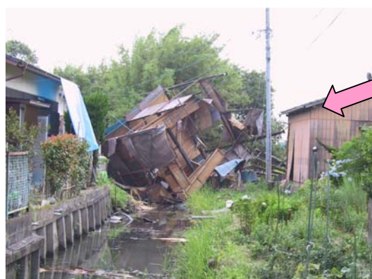
倒壊した家屋
