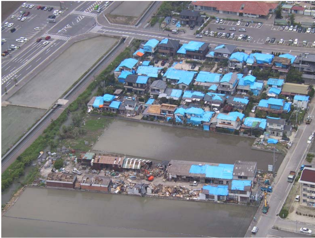
図 12 木原地区の被害
