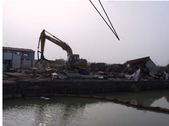
建設資材置場（鉄骨造倉庫の崩壊）
