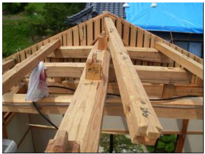
図10 地棟と棟木の北側端部
