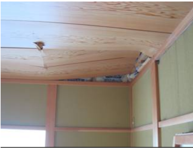
図 18 住家の 1 階室内の天井
