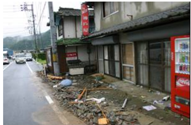
図 29 瓦等の飛散物 (安蘇地区 美作市撮影)
