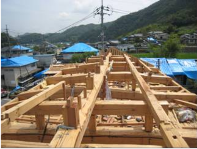
図7 小屋組の状況
