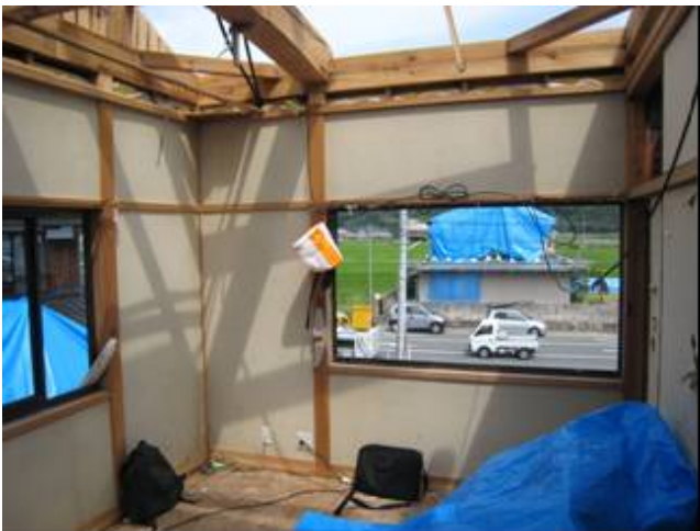
図11 2階北側室内の様子
