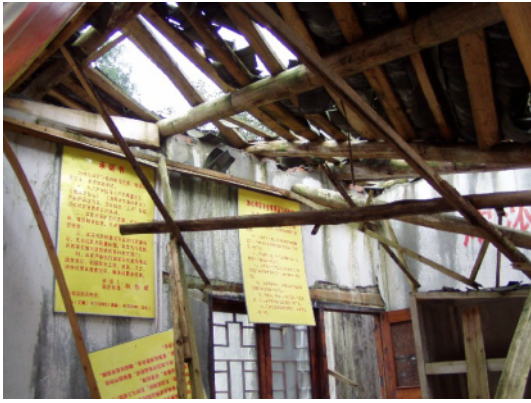
写真 4.2.7.9 組積造の典型的な倒壊パターンの一つであるケーブル崩壊による屋根の落下 (No7) 写真 4.2.7.10 2階建てで被害が軽微な住宅 (No1)
