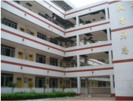
写真 4.2.6.1 天井脱落等の学校建築
