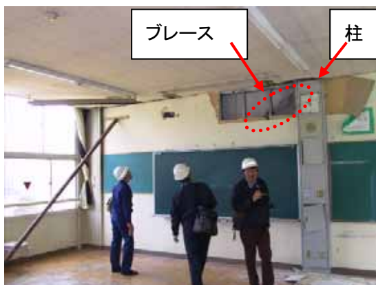
写真-5.7 張間方向のブレース
