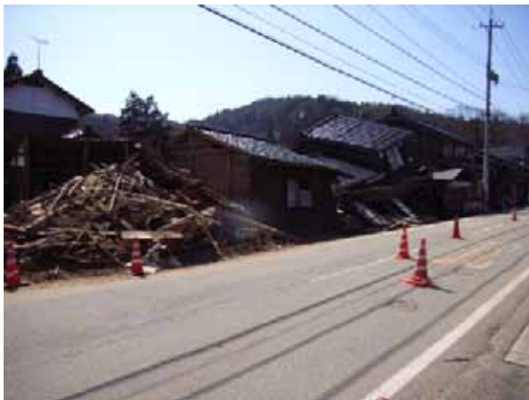
写真-4.13 倒壊家屋が建ち並ぶ門前地区
