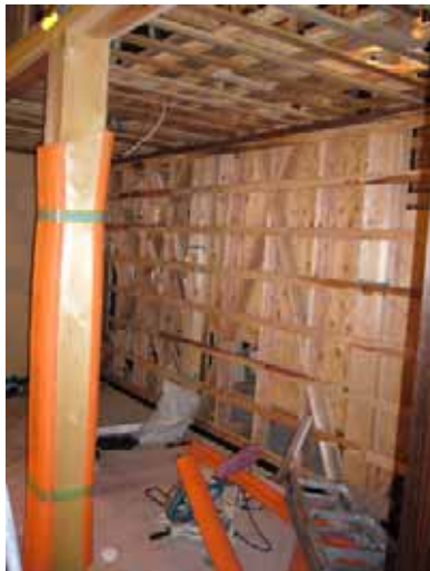
写真-4.110 筋かいが多数施工されている
