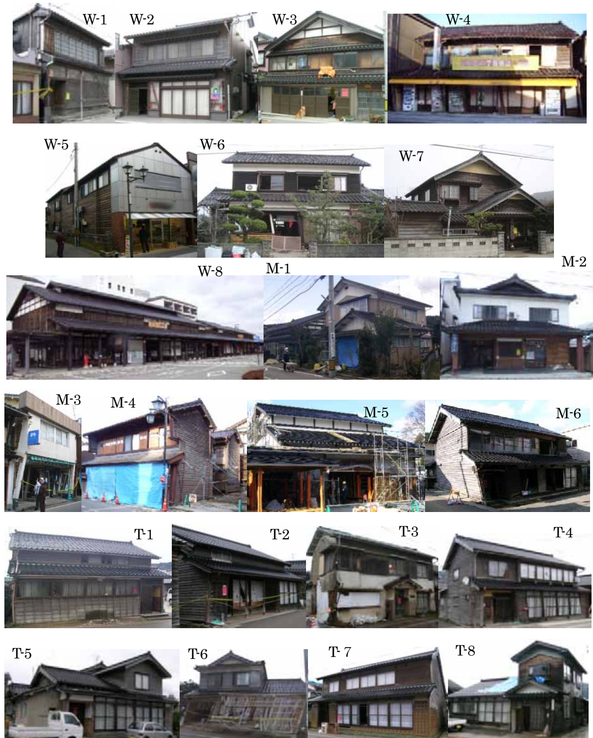
写真-4.57 詳細調査対象物件の外観
