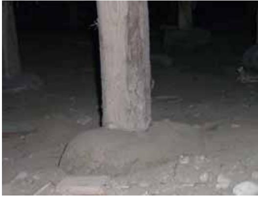
写真-8.3 土台基礎やブロック基礎を用いた住宅の建物内部の束基礎
