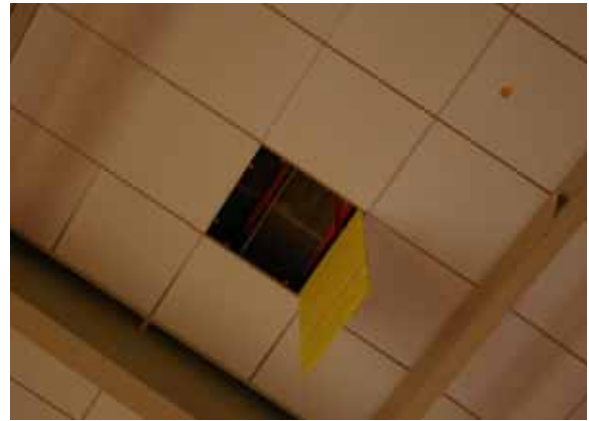
写真-7.27 被災直後のランニングロード上部の様子 写真-7.28 脱落しかけたグラスウールボード (加賀市役所提供資料より)
