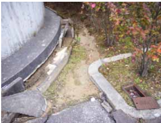
写真-4.51 田鶴浜支所裏の噴砂痕
