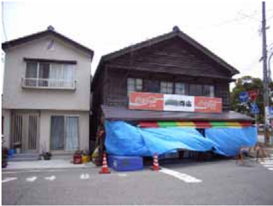
写真-4.41 倒壊した店舗
