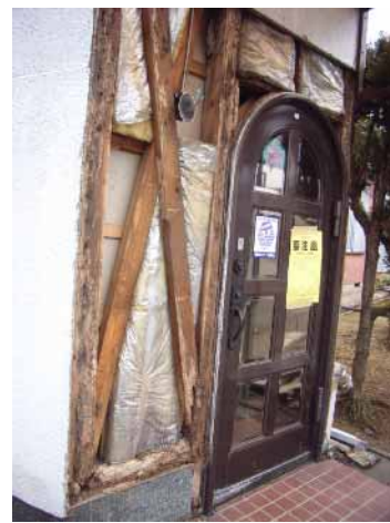
写真-4.46 衝突して外側へ傾いた建物
