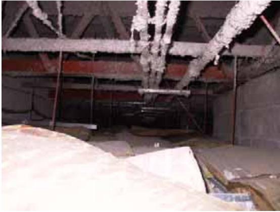
写真-5.20 張間方向のラチス梁
