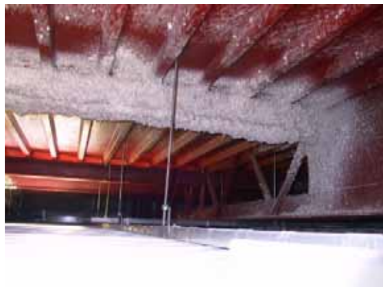
写真-5.10 天井裏の様子
