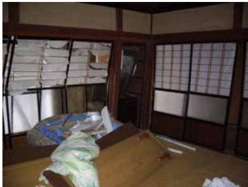
写真-4.133 筋かいが多数施工されている
