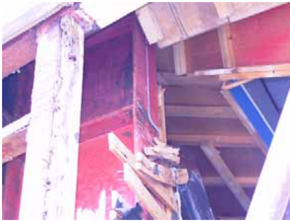
写真-5.25 柱（梁のH形鋼の跡が見える）
