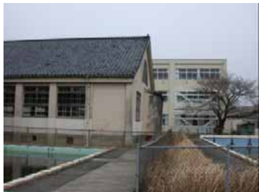
写真-6.7 A小学校（手前が講堂、奥が校舎）
