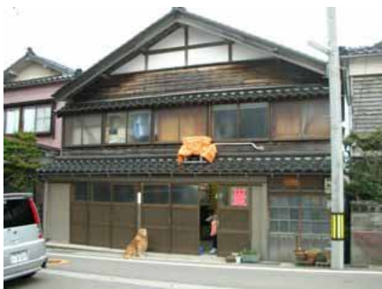
写真-4.66 全景 (2階に筋かいが見える)
