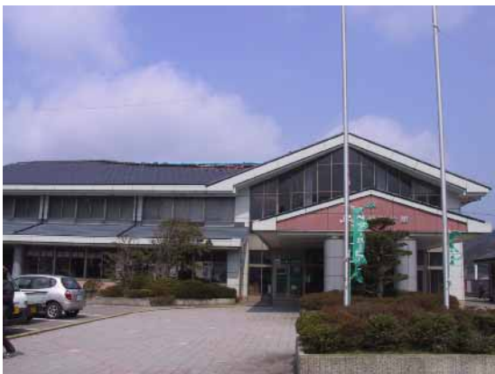
写真-7.39 建物 M の外観
