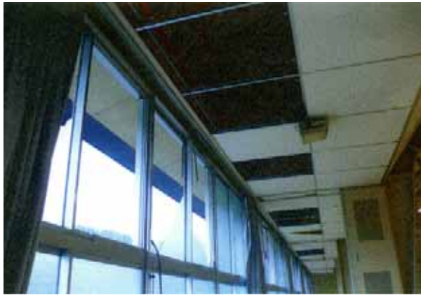
写真-7.27 被災直後のランニングロード上部の様子 写真-7.28 脱落しかけたグラスウールボード (加賀市役所提供資料より)
