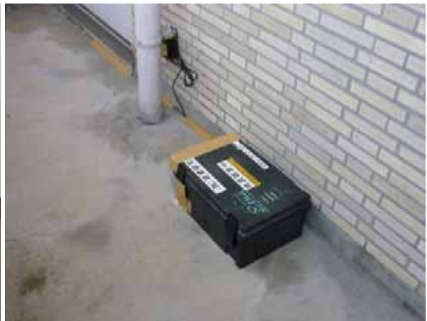
写真-3.8 門前支所3階強震計設置状況
