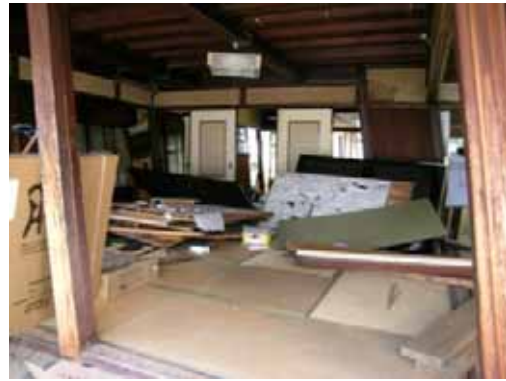
写真-4.115 内部の様子
