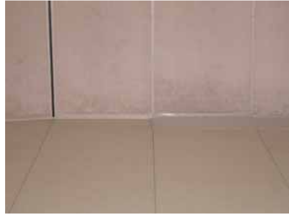
写真-7.11 壁と天井の取り合い
