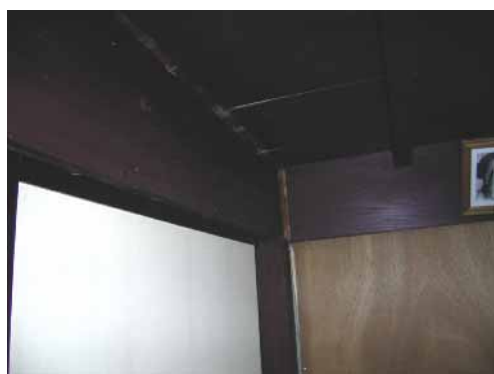
写真-4.68 改装時に設置された合板壁
