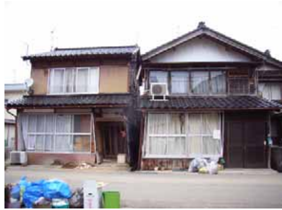
写真-4.46 衝突して外側へ傾いた建物
