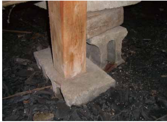
写真-8.3 土台基礎やブロック基礎を用いた住宅の建物内部の束基礎
