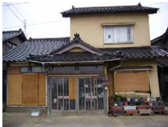
写真-4.52 国道 249 号線沿いの被害家屋
