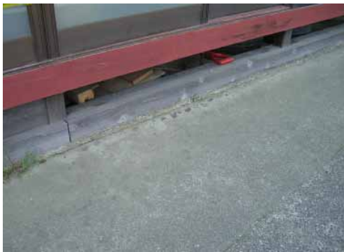
写真 8.1 地上での立ち上がり部分がほとんどない古い土台基礎 (地表面付近に切石などを設け、地表面から数 cm ほど上部に木質土台を置く基礎形式)
