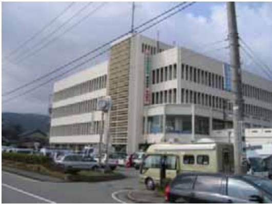
写真-6.1 輪島市役所
