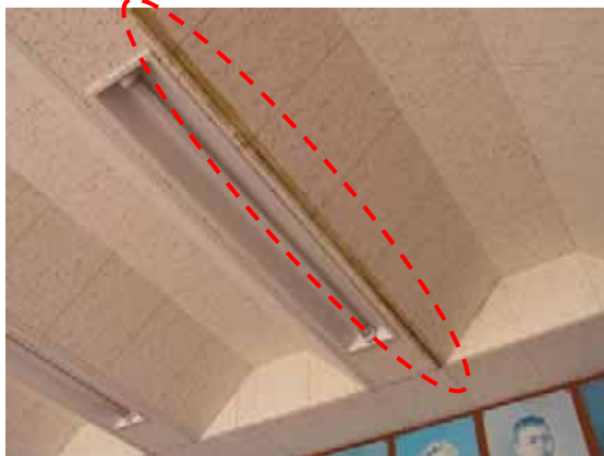
写真-5.18 音楽室の天井
