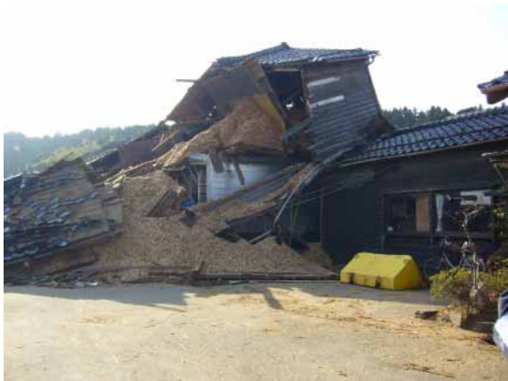
写真-4.1 倒壊したチップ工場
