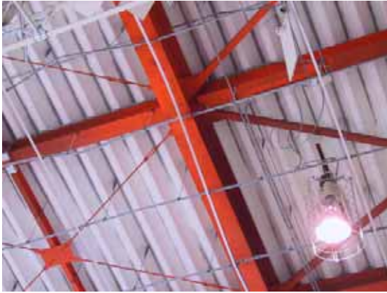
写真-7.13 天井下地の様子
