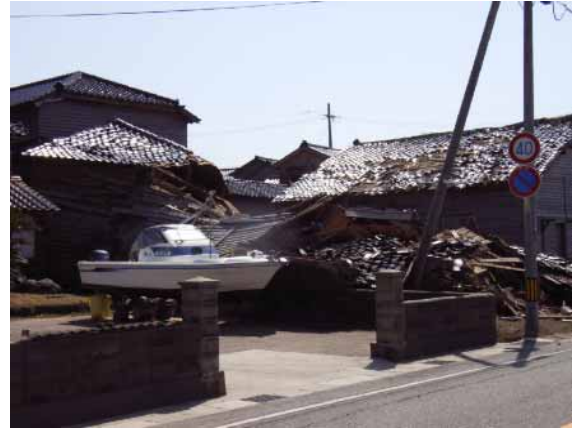
写真-4.34 倒壊した納屋又は倉庫
