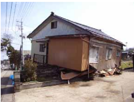
写真-4.11 小伊勢地区の倒壊家屋
