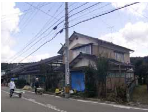
写真-4.90 全景（2階建部分と増築部）
