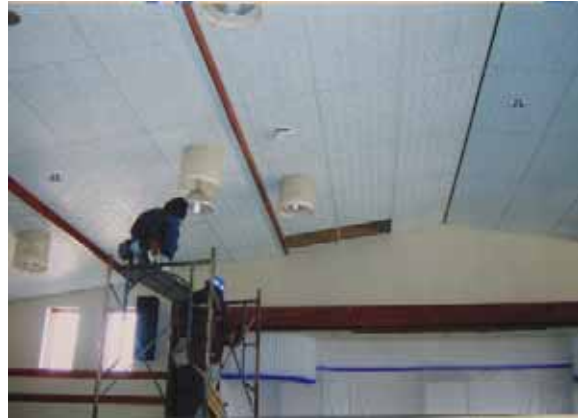
写真-7.42 天井補修工事の様子 (建物N 関係者提供)
