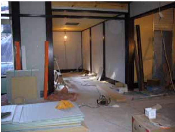
写真-4.112 施工中の内装
