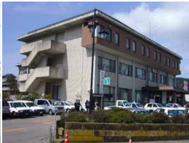
写真-3.6 門前支所概観(南東から)
