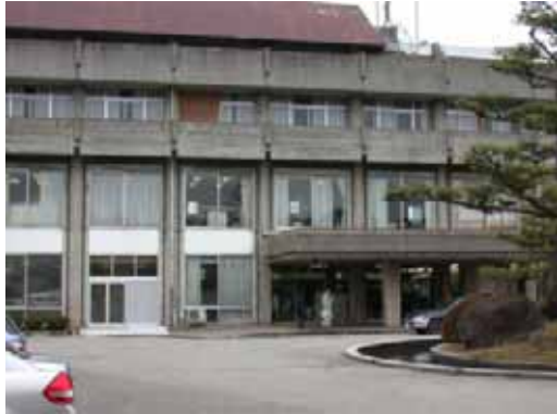
写真-6.14 七尾市役所田鶴浜支所
