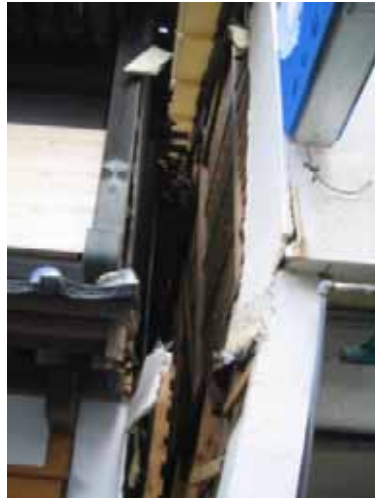
写真-4.100 北側壁面
