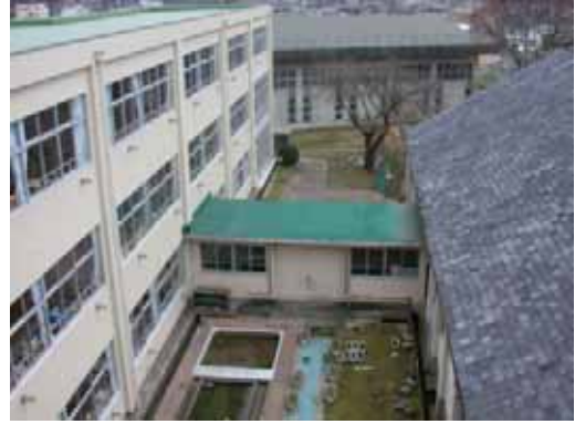
写真-6.10 校舎棟と講堂の渡り廊下
