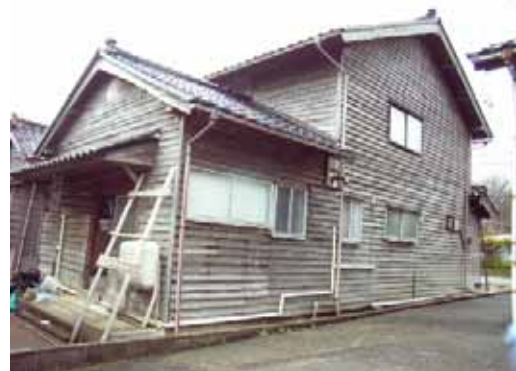
写真-4.132 北側外観
