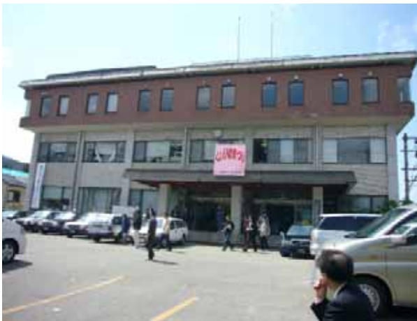
写真-3.5 門前支所概観(東から)
