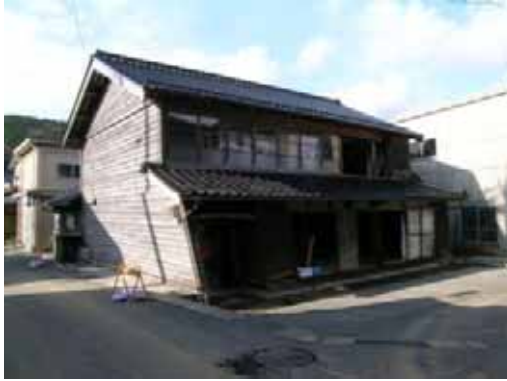
写真-4.114 全景。左（西）に残留変形大
