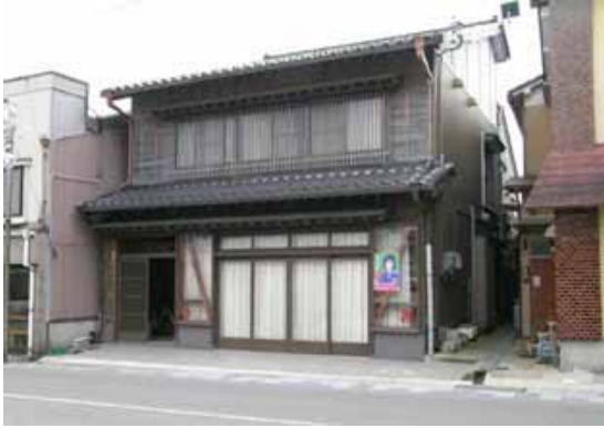
写真-4.62 外観、1階に筋かいが見える
