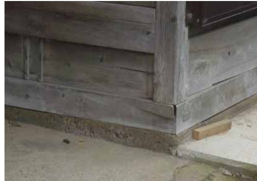
写真 8.1 地上での立ち上がり部分がほとんどない古い土台基礎 (地表面付近に切石などを設け、地表面から数 cm ほど上部に木質土台を置く基礎形式)
