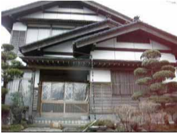
写真-4.45 外観上被害が軽微な建物
