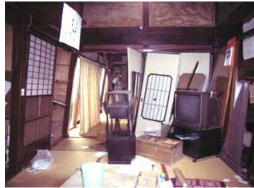
写真-4.71 内部の被害状況
