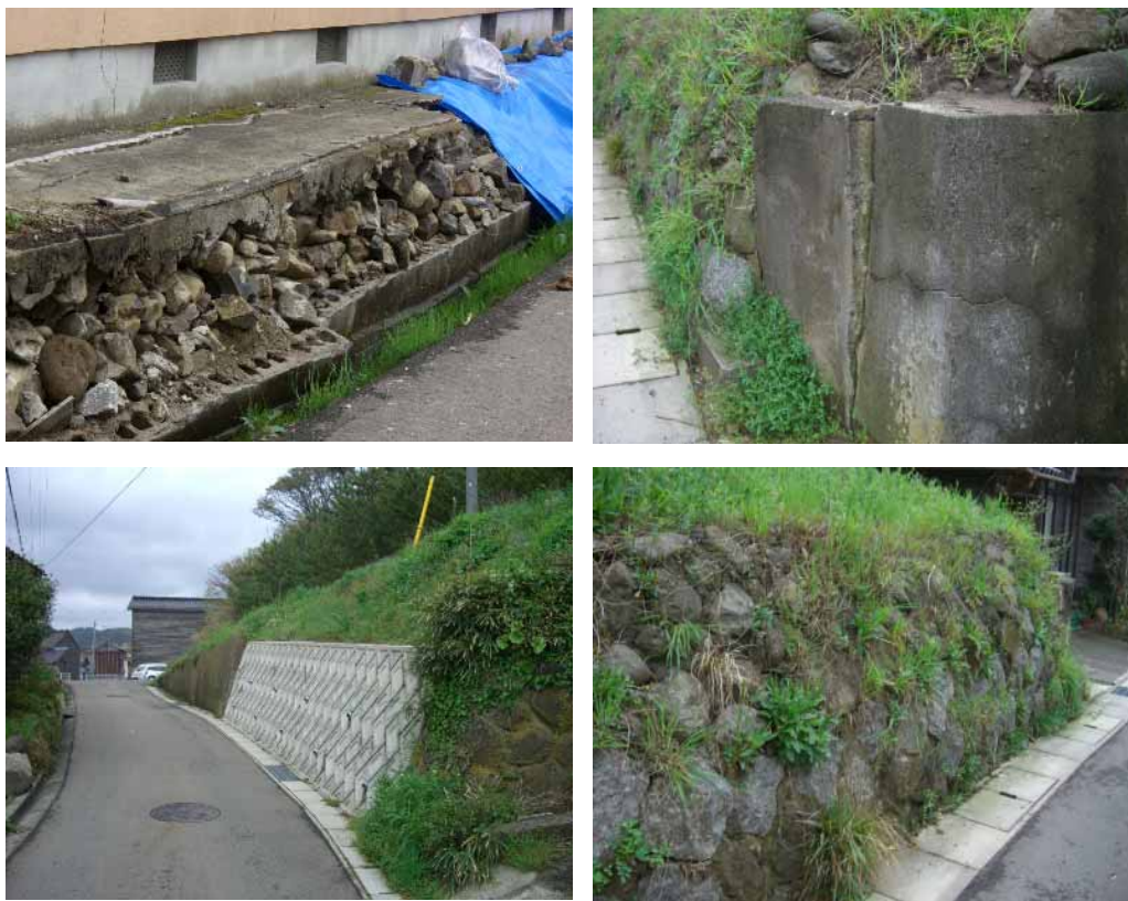
写真-8.10 道下地区の土留め・擁壁の状況
