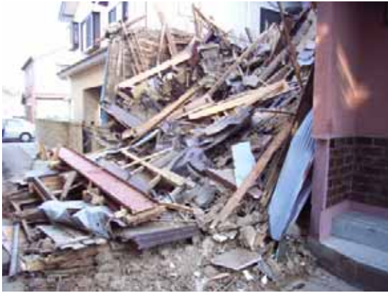
写真-4.3 鳳至地区で選択的に倒壊した家屋
