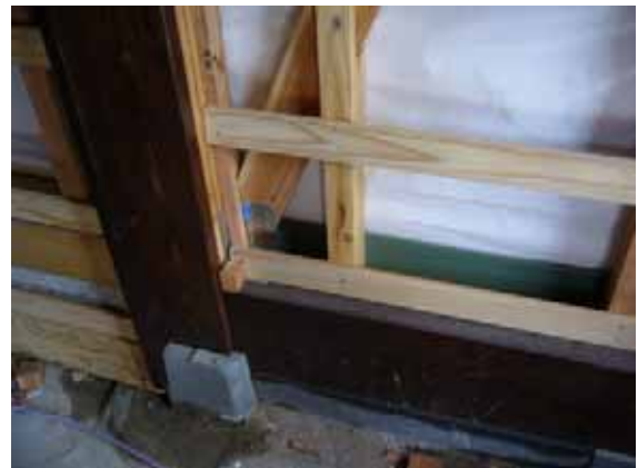
写真-4.111 筋かい端部には所定の金物
