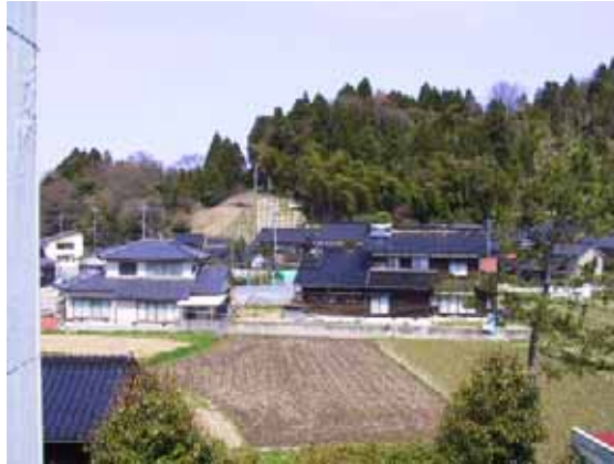
写真-5.22 周辺の民家（棟瓦のずれ）
