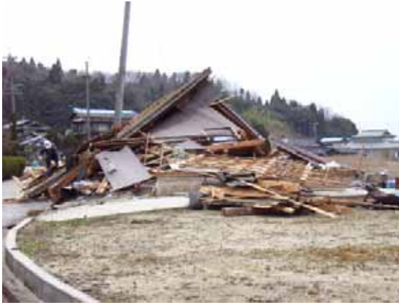
写真-4.53 倒壊した作業所または倉庫
