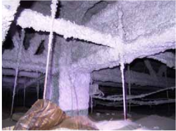
写真-5.21 柱梁接合部
