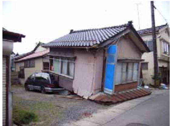
写真-4.42 倒壊し車両をつぶした家屋
