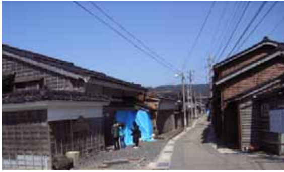
写真-4.31 黒島地区の中腹の町並み
