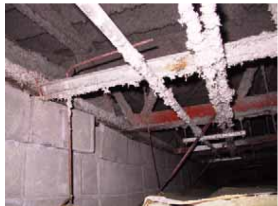
写真-5.19 音楽室と廊下の間仕切り壁
