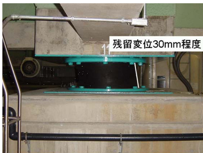
図 8.3 積層ゴムの状況
