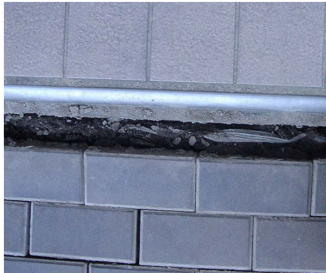
図 8.4 正面入り口付近の免震・非免震部分の様子
