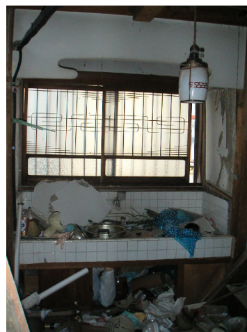
写真 4.18 道路に直交方向の壁は比較的被害軽微
