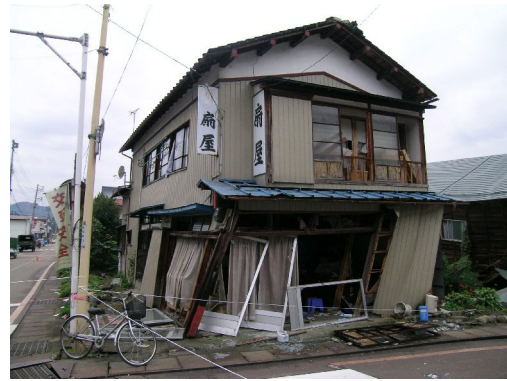
写真 4.10 大破した店舗併用住宅
