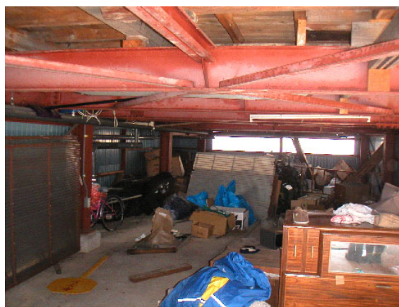
写真 4.16 1階鉄骨造部分
