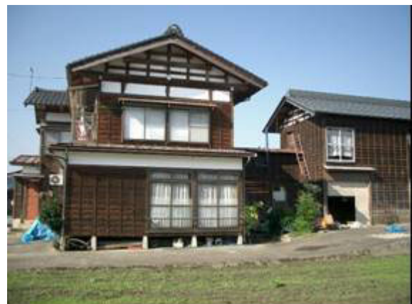
写真 4.106 北側に接続する別棟
