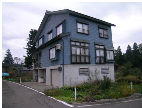
写真 4. 40 一方向(東西)の障子の破れ
