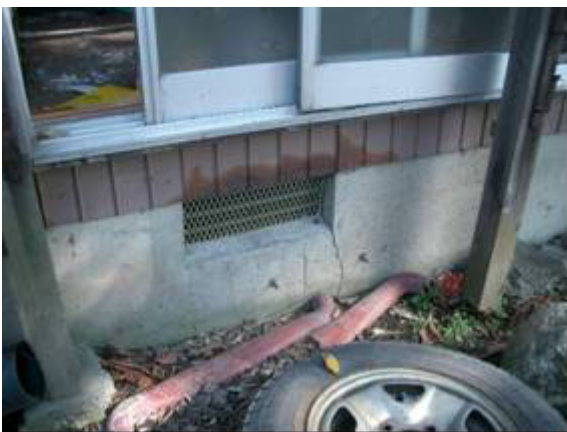
写真 4.109 基礎の亀裂
