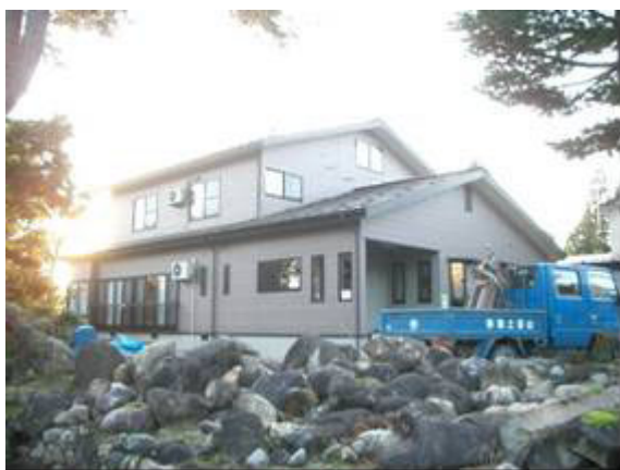
写真 4.94 建物外観（北東側）
