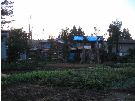
写真 4.69 屋根瓦、開口部の被害が目立つ
