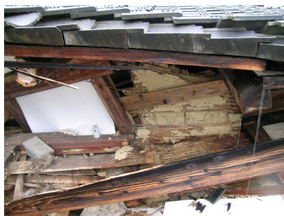
写真 4.74 同左詳細 土塗り壁
