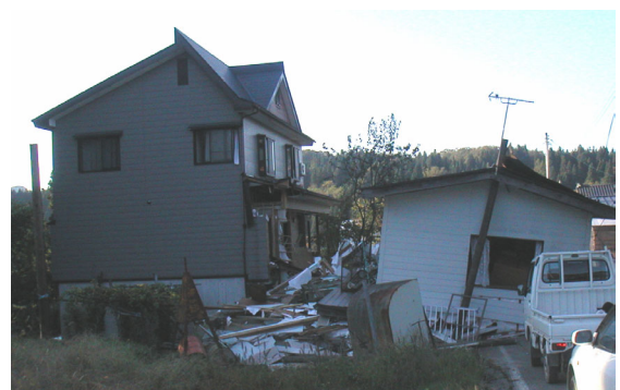
写真 4.64 連結部が解離して倒壊した作業所
