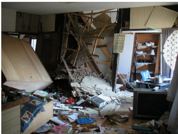
写真 4.43 内壁の脱落
