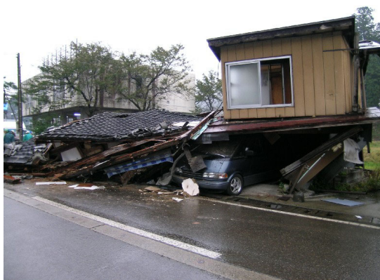
写真 4.73 竜光地区の倒壊した住宅 （1 階部分は車庫）
