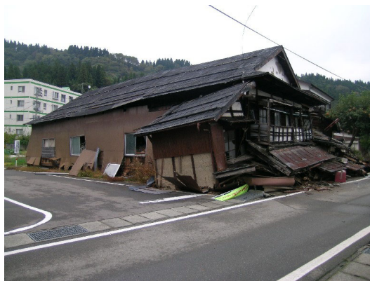
写真 4.13 築 60～70 年と推測される木造 劇場建築物の倒壊
