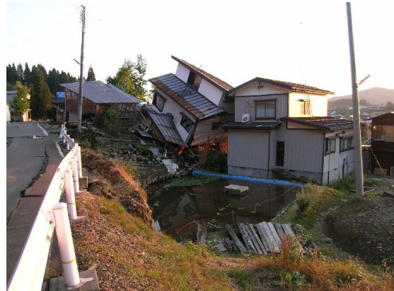
写真 4.72 地盤崩壊に伴う住宅倒壊
