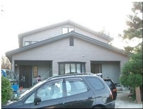
写真 4.92 建物概観（道路・北側）
