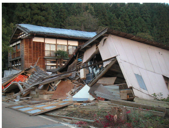
写真 4.65 納屋または作業小屋の倒壊
