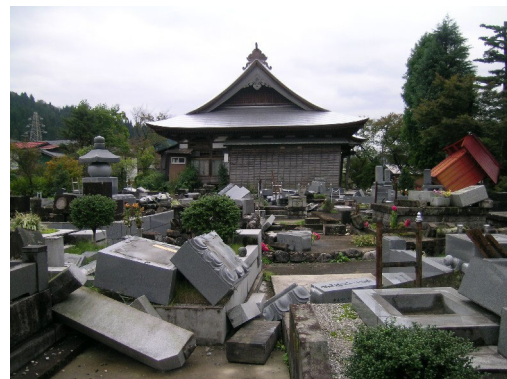
写真 4.12 墓石の転倒（画面右が西）
