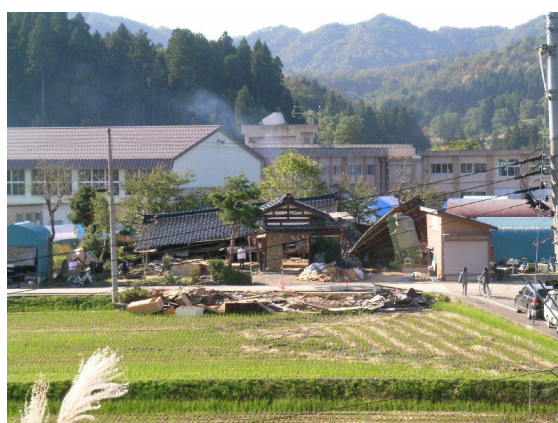
写真 4.7 住宅倒壊。後ろは吉谷小学校
