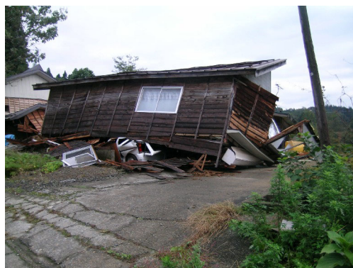
写真 4. 38 車庫の倒壊
