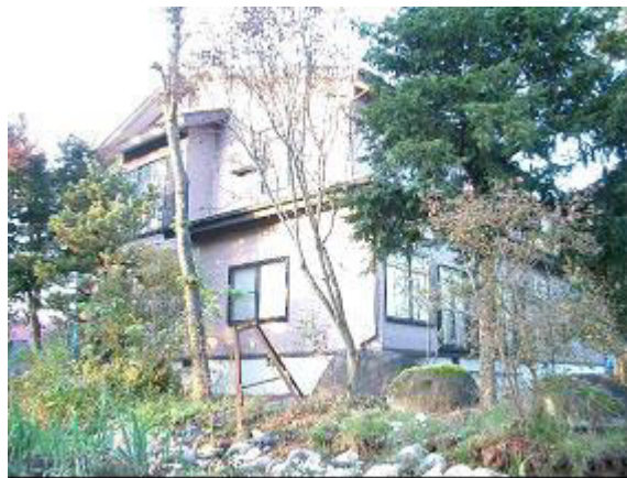
写真 4.93 建物外観（南西側）
