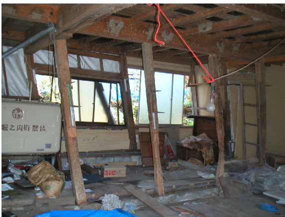
写真 4.97 作業場部分の内観
