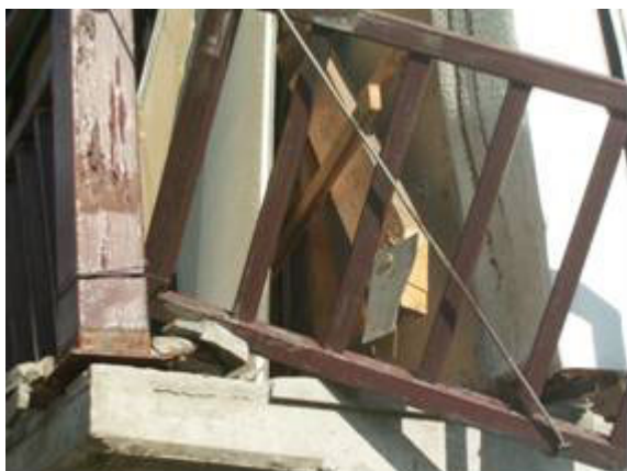
写真 4.25 二つ割り筋かいと筋かいプレート
