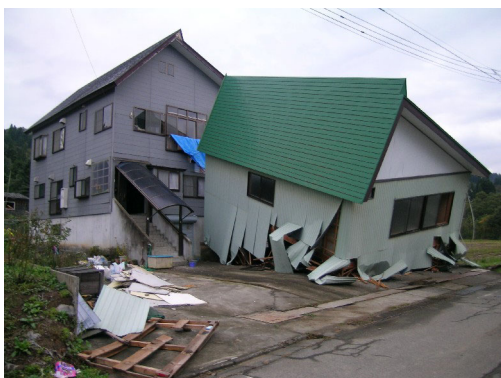
写真 4. 39 作業小屋の倒壊
