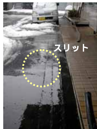
(b) 補修状況
