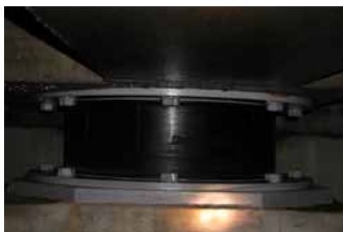
写真 9.5.8 積層ゴムの状況
