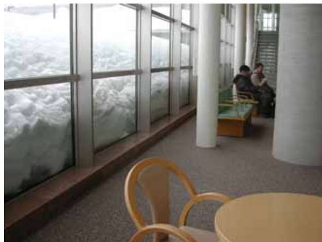
写真 9.5.20 1 階ロビー外部の積雪状況
