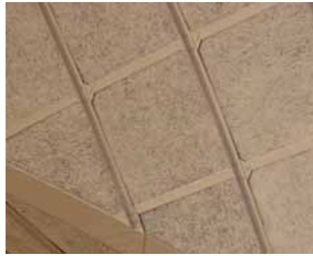
写真 7.74 木毛セメント板天井(面外交叉)
