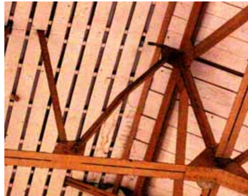
写真 7.36 張間方向トラス梁斜材座屈(OJY-9) 写真 7.37 張間方向トラス梁斜材座屈(OJY-9)
