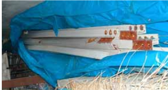
写真 7.8 交換のため取り外されたブレース材
