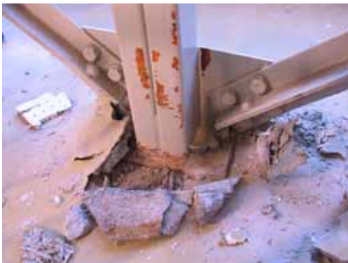
写真 7.19 ブレース付間柱脚部の破壊(TCO-2) 写真 7.20 ブレース付間柱脚部の破壊(NGO-1)
