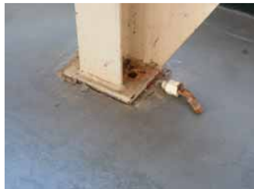
写真 7.17 ブレース付間柱脚部の破壊(HRH-4) 写真 7.18 ブレース付間柱脚部の破壊(HRH-7)
