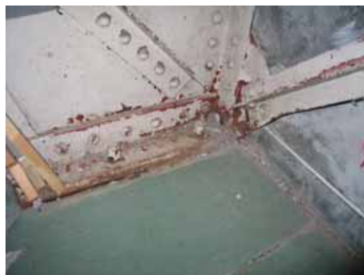
写真 7.12 アンカーボルトの伸び(HRN-2)
