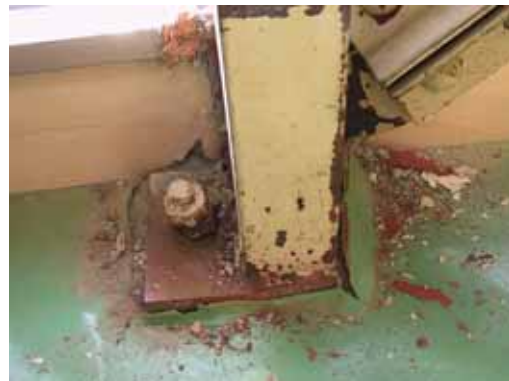
写真 7.19 ブレース付間柱脚部の破壊(TCO-2) 写真 7.20 ブレース付間柱脚部の破壊(NGO-1)
