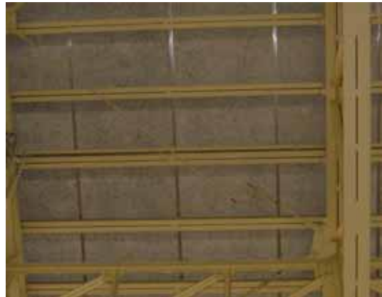
写真 7.29 水平ブレース破断(TOK-4)
