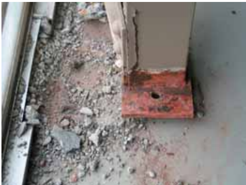
写真 7.15 ブレース付間柱脚部の破壊(OJY-8) 写真 7.16 ブレース付間柱脚部の破壊(HRN-2)
