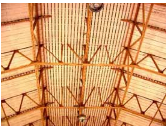
写真 7.36 張間方向トラス梁斜材座屈(OJY-9) 写真 7.37 張間方向トラス梁斜材座屈(OJY-9)
