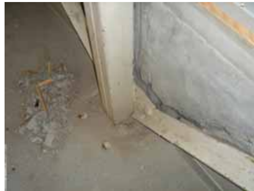
写真 7.15 ブレース付間柱脚部の破壊(OJY-8) 写真 7.16 ブレース付間柱脚部の破壊(HRN-2)
