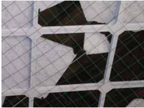
写真 7.73 木毛セメント板天井(面内交叉)
