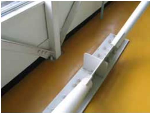
写真 7.21 ブレース付間柱(KWG-4)
