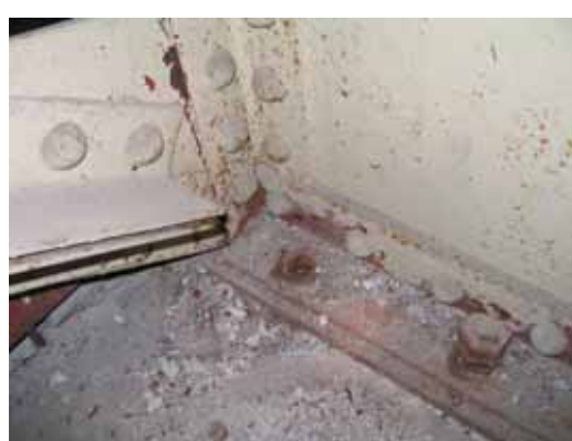
写真 7.14 アンカーボルトの破断(NGO-1)
