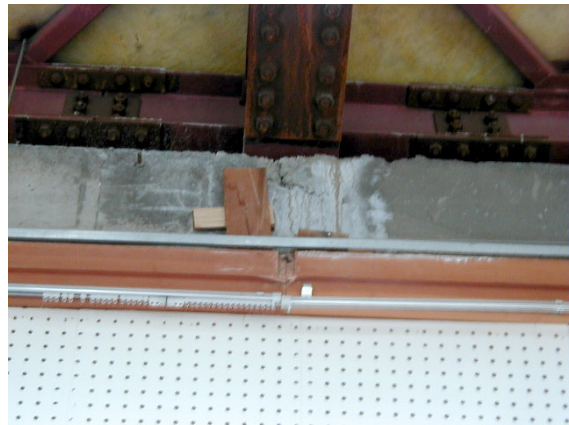
写真 2.2.10 回り縁の配置状況
