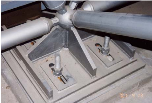
写真 2.3.2 屋根トラスの支点（スライド可能）
