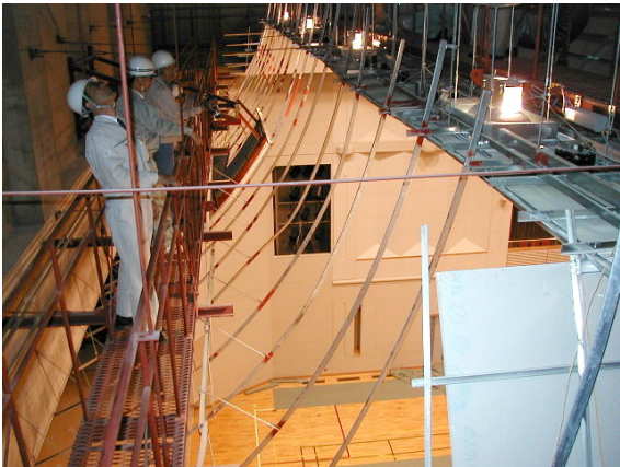
写真 2.1.15 野縁受けの吊ボルトによる支持状況
