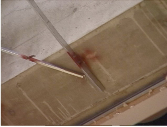
写真 2.1.13 曲面部分の野縁受けの接合状況（下端）
