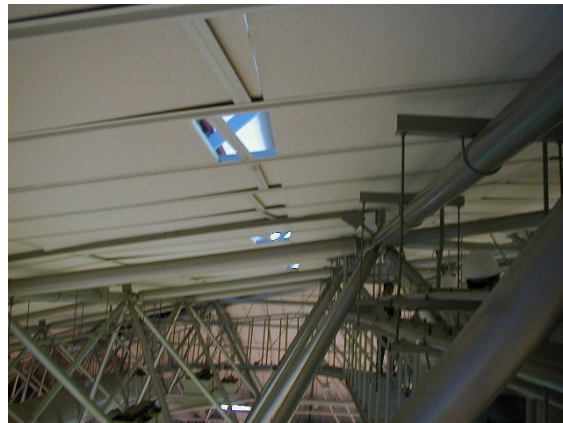
写真 2.3.5 天井材の落下（上より）
