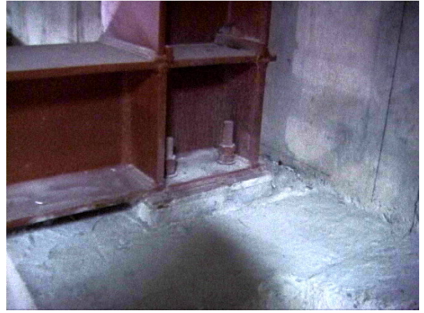
写真 2.1.8 トラス梁のピン支持位置に損傷無し
