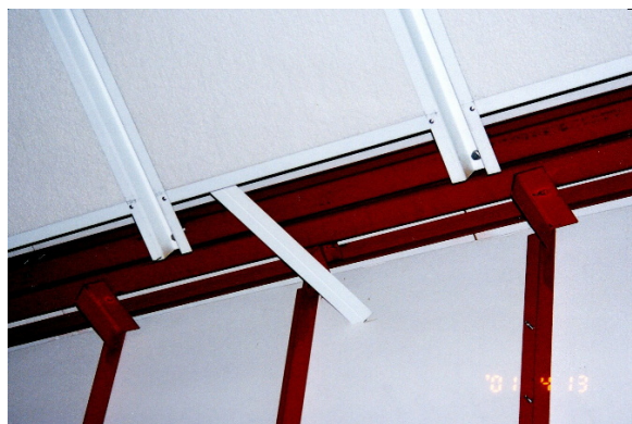
写真 2.3.8 硬質ウレタンに刺さったTバー（右）
