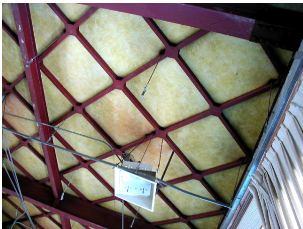
写真 2.2.3 屋根面ブレース
