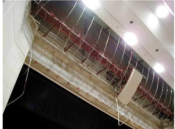
写真 2.1.10 野縁受けの配置 (約 90cm 間隔)
