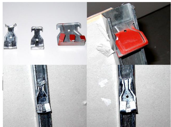
写真 2.1.12 使用されていたクリップと支持状況
