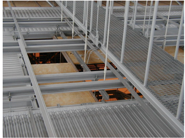
写真 2.3.5 天井材の落下（上より）
