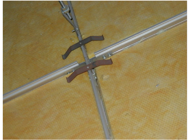
写真 2.4.5 落下防止金物の設置状況
