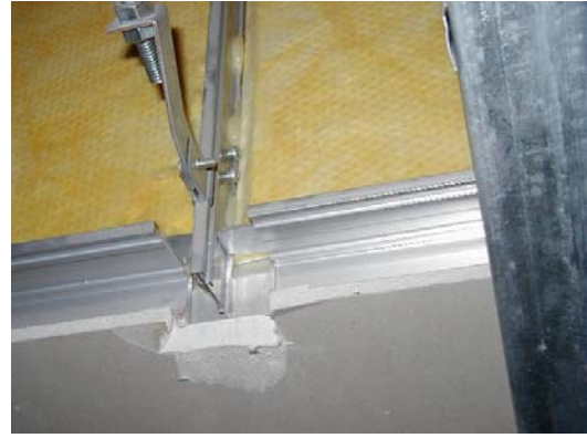
写真 2.4.3 Tバーによる格子点の部分
