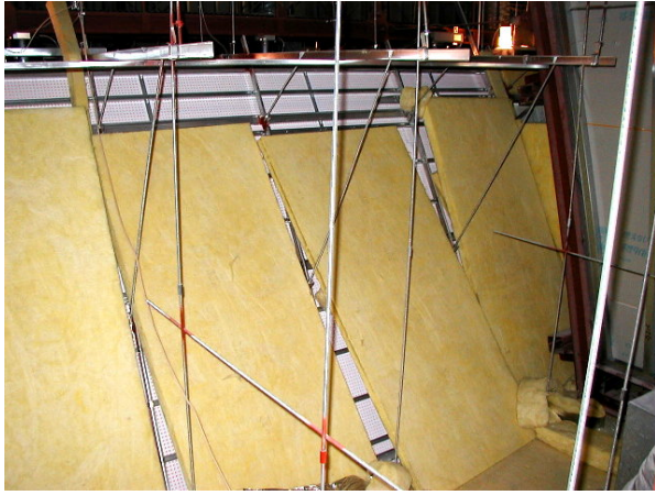
写真 2.1.7 グラスウールの移動
