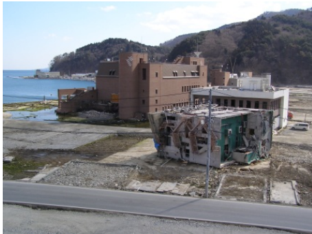
← 津波より転倒された建物
